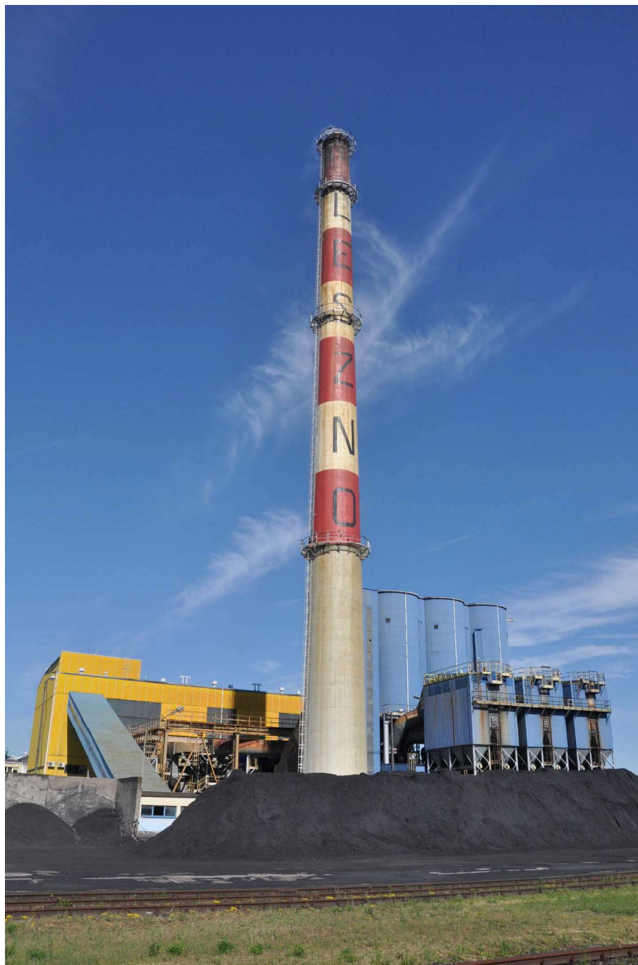
Fot. 1. Widok ogólny komina
