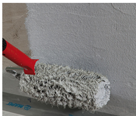
Nanoszenie warstwy Mapegum WPS wałkiem
