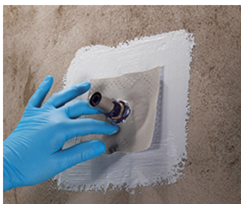
Montaż kawałka Mapeband PE 120 przy użyciu Mapegum WPS
