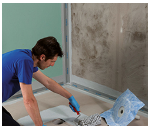
Montaż elementów Drain Vertical przy użyciu Mapegum WPS
