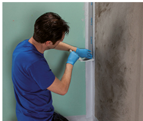
Przyklejanie taśmy Mapeband PE 120 na Mapegum WPS
