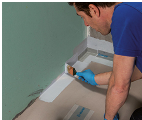
Przyklejanie taśmy Mapeband PE 120 na Mapegum WPS
