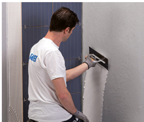
Montaż okładziny ściiennej przy użyciu zaprawy klejącej Ultramastic III
