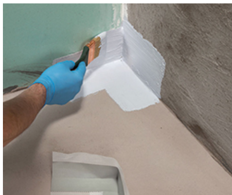
Przyklejanie narożnika Mapeband PE 120 na Mapegum WPS
