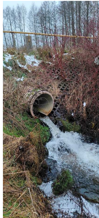
Fot.2 widok wylotu przepustu DN800 w rejonie przewidywanego Wylotu "W2"
