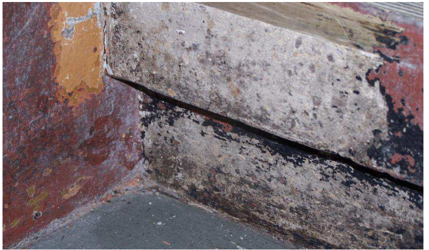
Fot. 24. Podstopnica wykonana z sztucznego kamienia, opracowana na gładko.
