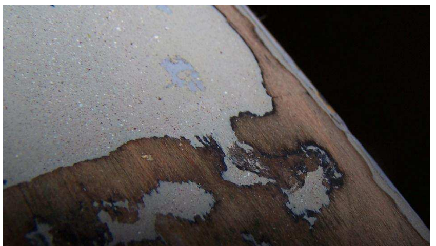
Fot.40. Drewniany pochwył balustrady malowany w kolorze czarnym.
