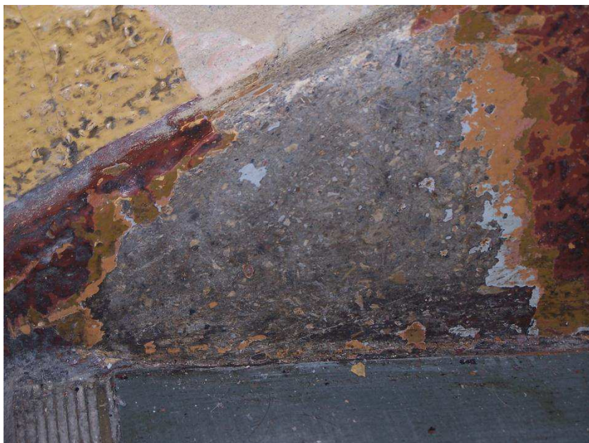
Fot. 23. Cokolik od strony ściany wykonany w sztucznym kamieniu, opracowany na gładko.
