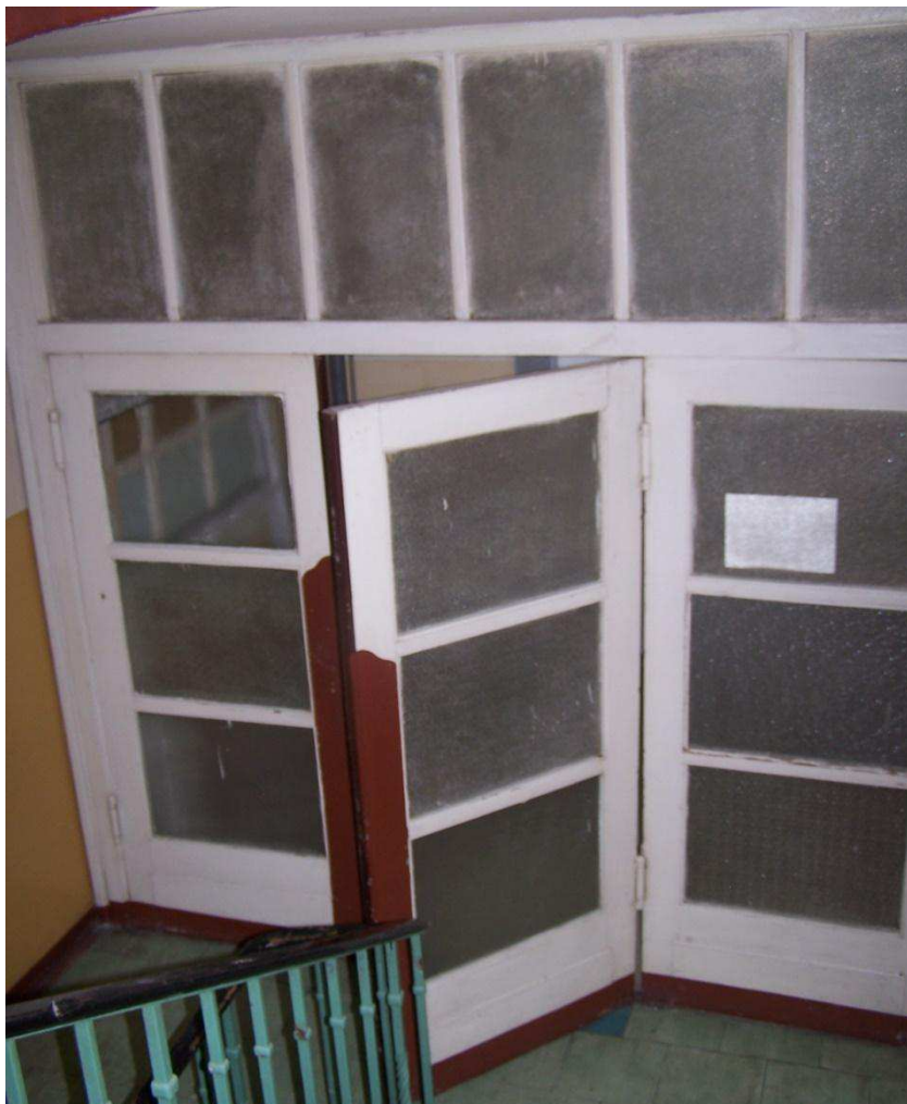
Fot. 22. Oryginalne drzwi prowadzące na korytarz na II piętrze.
