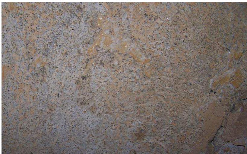
Fot. 4. Ściana na do wysokości lamperii NCS S1010-Y20R.
