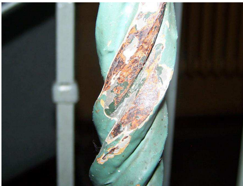
Fot. 29. Metalowa tralka spiralna w kolorze NCS S 7020-G.
