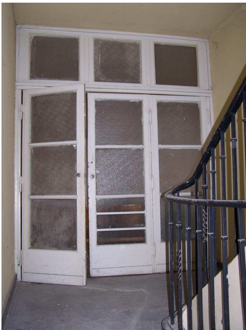
Fot. 42. Oryginalne drzwi wahadłowe prowadzące na korytarz III pietra, w kolorze NCS S 5010-B30G.
