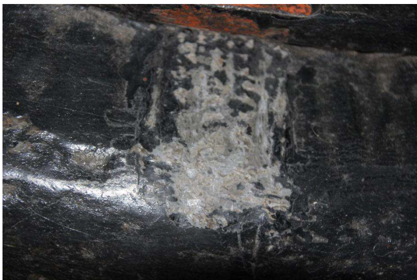
Fot. 30. Cokolik od strony balustrady wykonany w sztucznym kamieniu z ryflowaniem.
