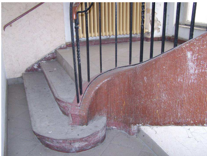
Fot. 12. Policzek schodów wykończony ozdobnym ryflowaniem.
