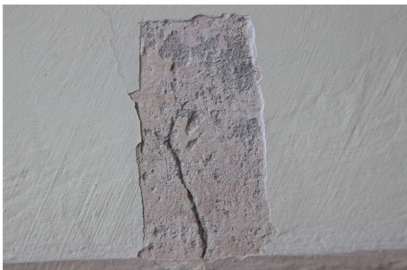
Fot. 3. Ściana ponad lamperią NCS S1010-Y20R.
