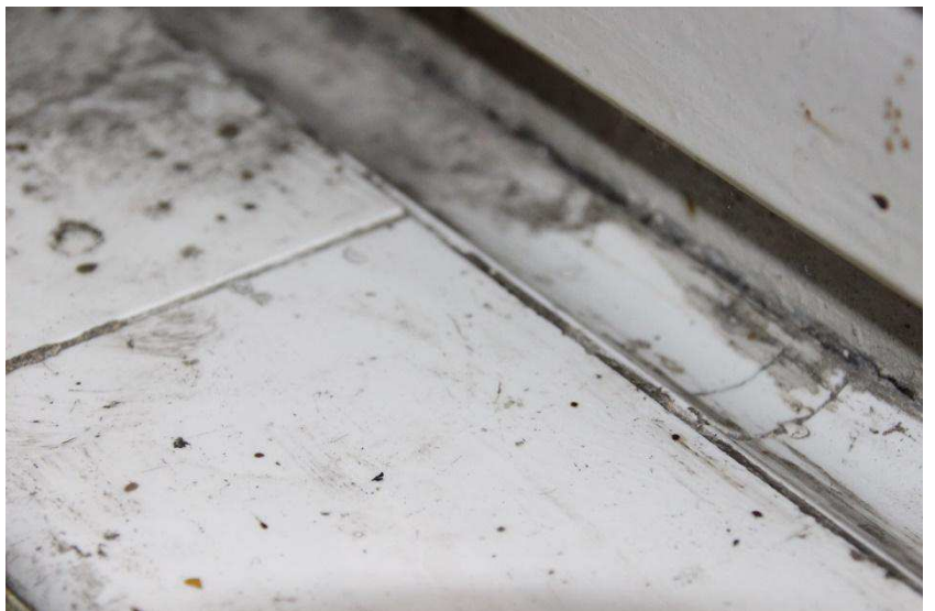
Fot. 9. Parapet z płytek ceramicznych oryginalny z płytką odpływową.
