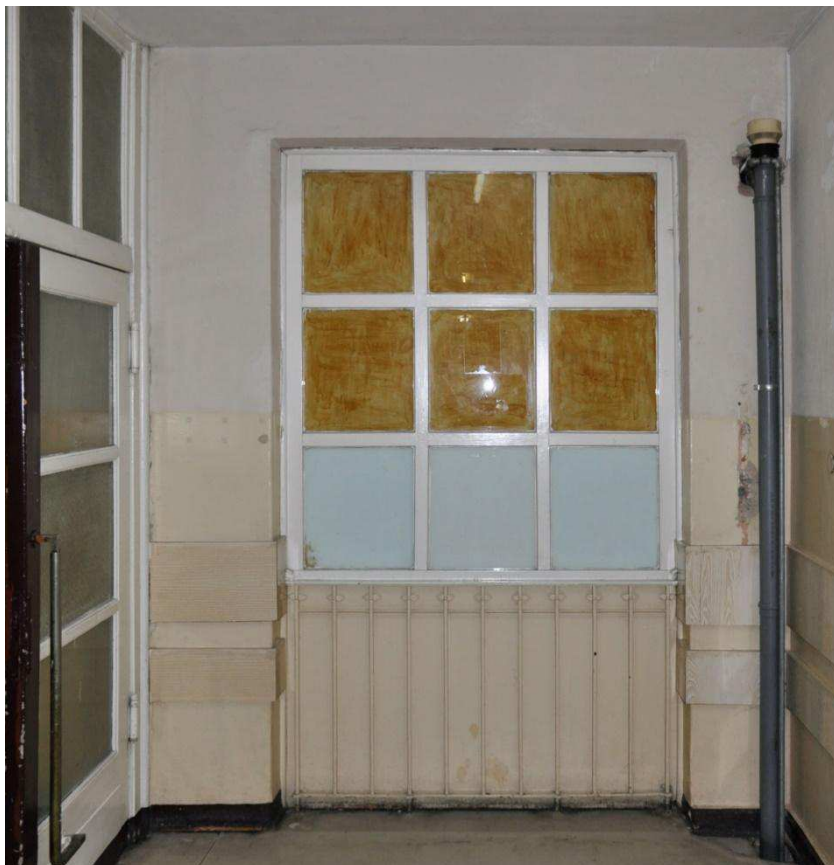
Fot. 57. Dawny balkonik z widokiem na przedsionek dużej sali konferencyjnej z projektorem. Stolarka okienna wtórna. Balustrada metalowa.
