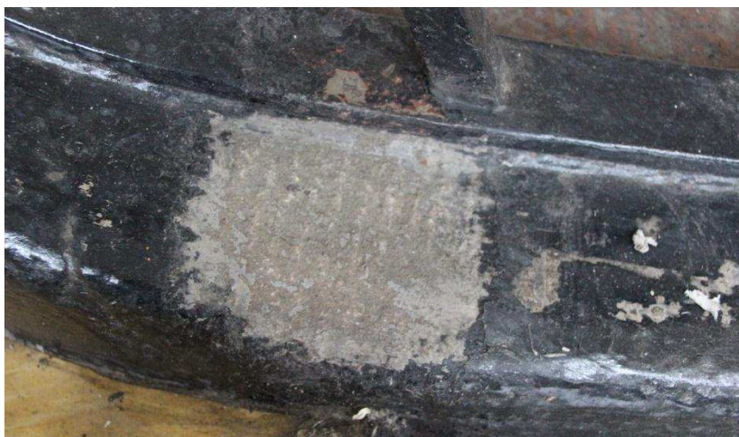
Fot. 6. Cokolik od strony balustrady wykonany w sztucznym kamieniu, ryflowany
