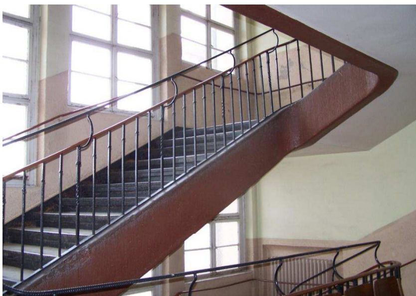
Fot. 2. Oryginalne schody z metalową balustradą. Cokół pod balustradą wraz z policzkiem ryflowany.
