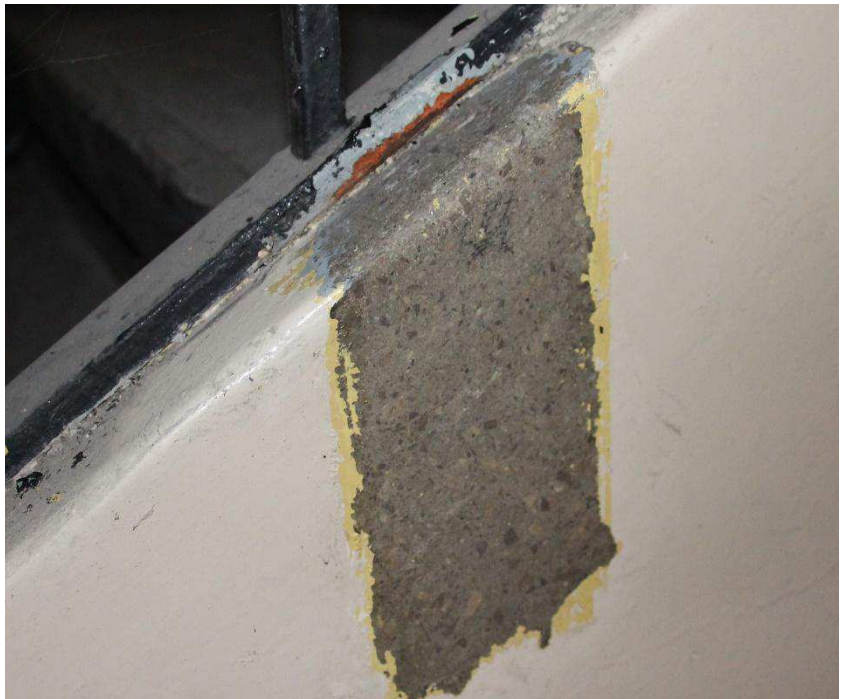
Fot. 39. Policzek schodów wykonany w sztucznym kamieniu, opracowany na gładko.
