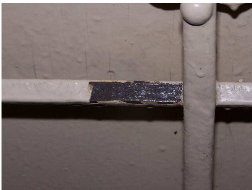
Fot. 58. Balustrada metalowa balkoniku w kolorze czarnym
