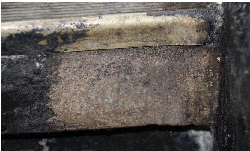
Fot. 13. Podstopnica wykonana z sztucznego kamienia, opracowana na gładko
