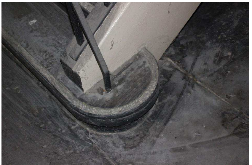
Fot. 36. Schody. Stopnice oraz posadzka wykończone współczesnymi płytkami PCV.
