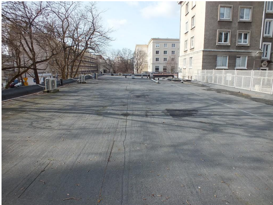
Zdj. 1. Widok dachu budynku przy ul. Nowolipie 22
