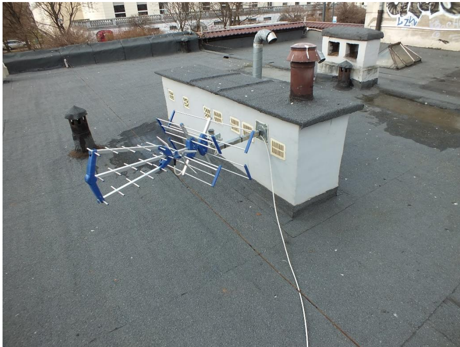
Zdj. 9. Antena satelitarna zamontowana do konstrukcji komina
