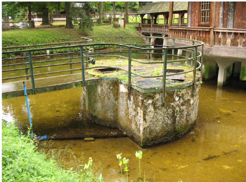
Fot.4 Widok na komorę ujęcia i rozdziału wody
