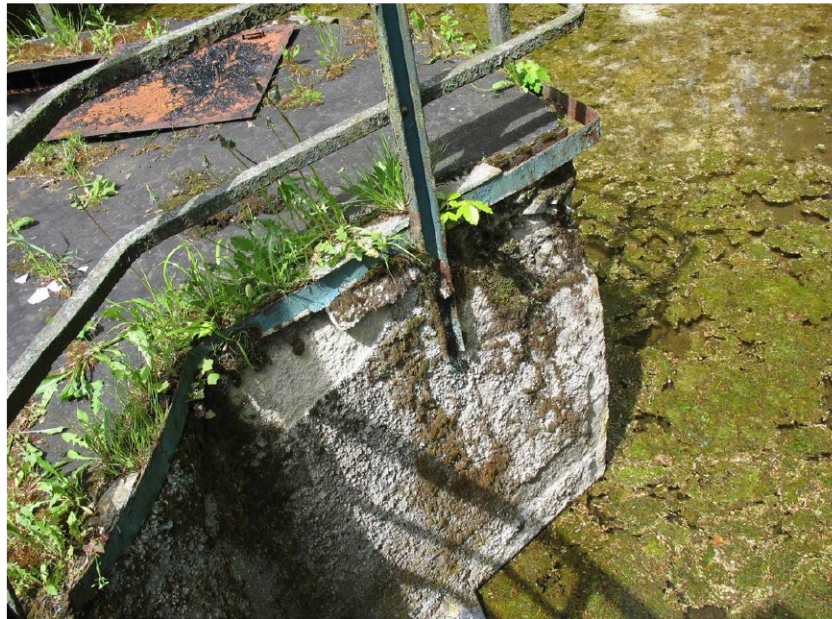
Fot.5 Widok szczegółu ściany komory ujęcia i rozdziału wody
