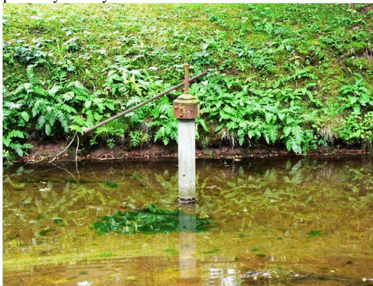
Rys. Zdjęcie odpowietrznika
