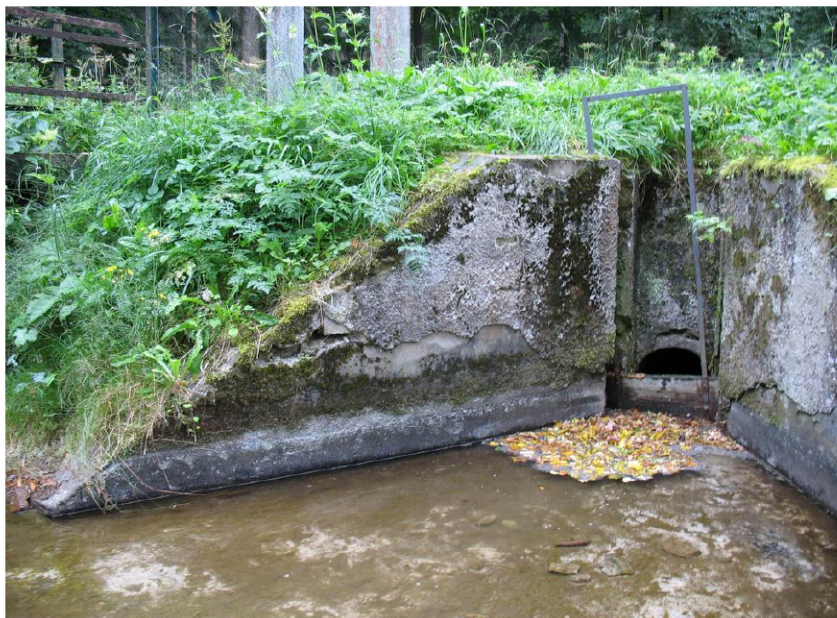
Fot.8 Widok na wylew i zastawkę przelewową wody ze stawu
