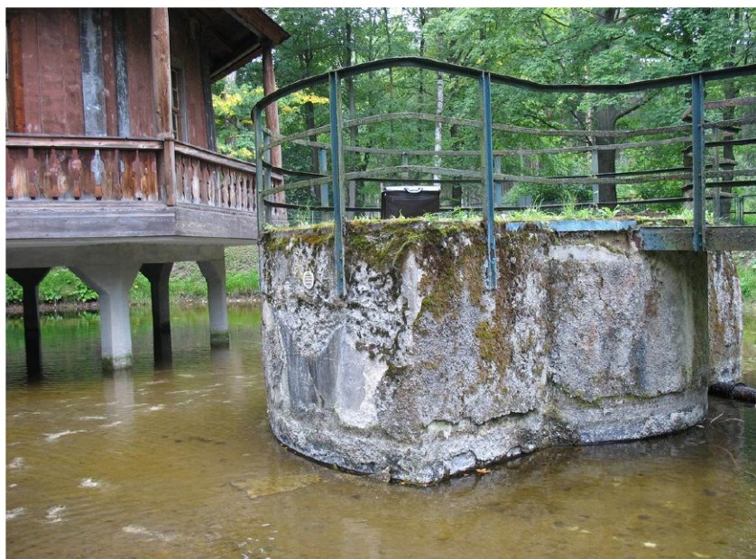
Fot.2 Widok na komorę ujęcia i rozdziału wody
