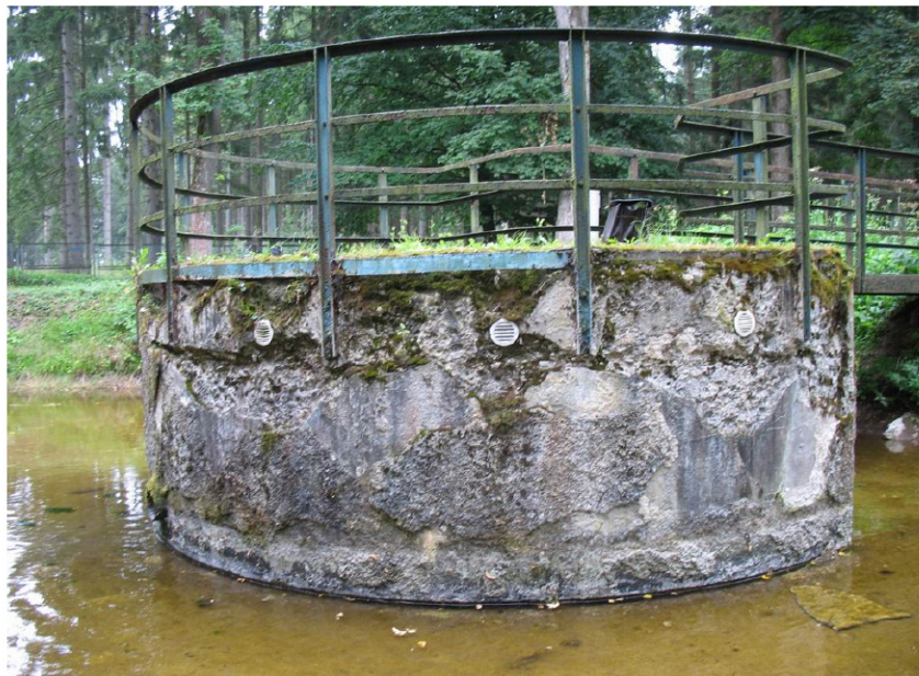
Fot.1 Widok na komorę ujęcia i rozdziału wody
