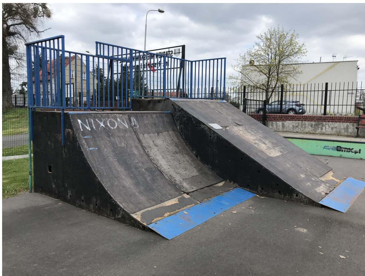
Fot. Istniejące wyposażenie skate parku (przeznaczone do demontażu w gestii Inwestora)
