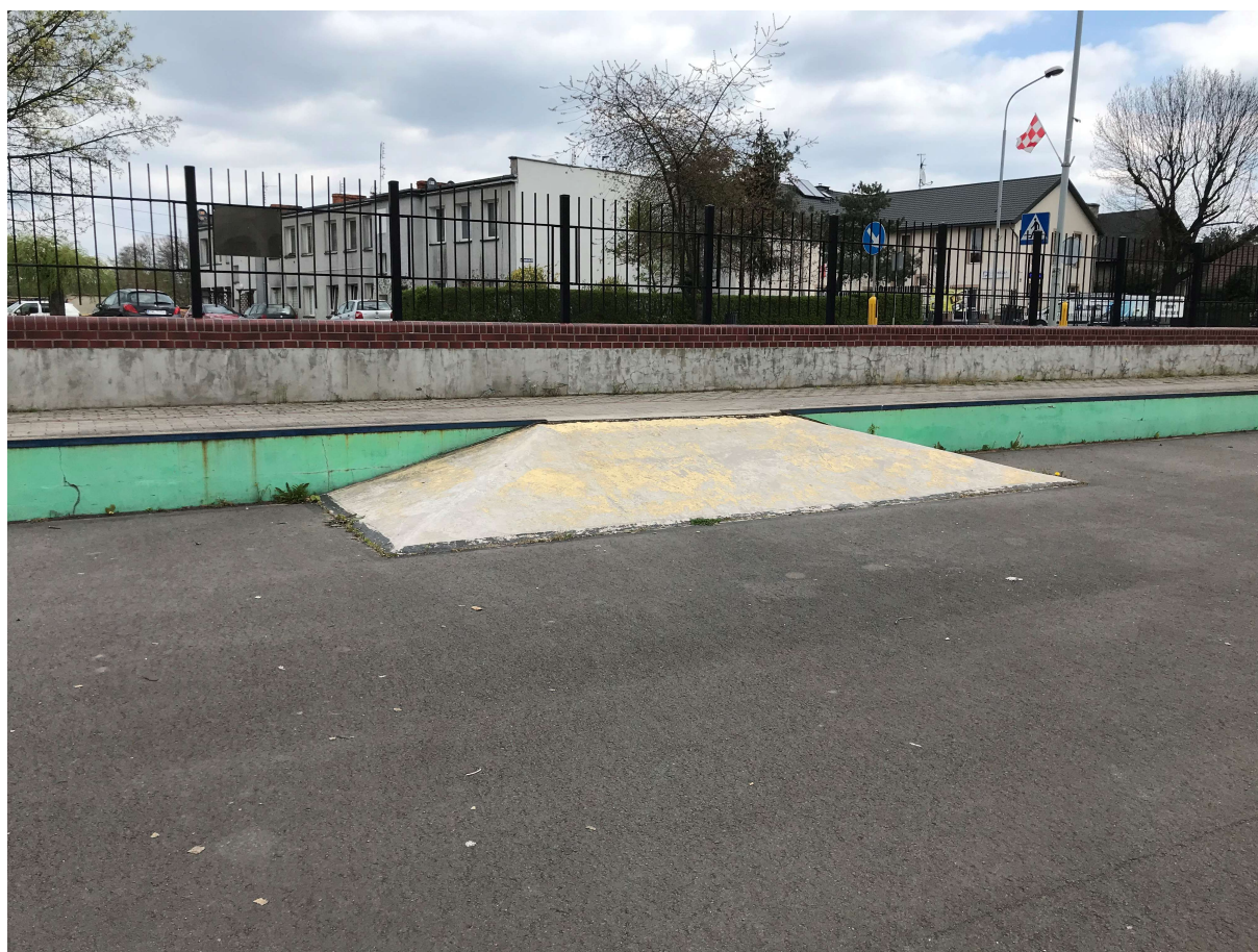
Fot. Rampa zjazdowa betonowa
