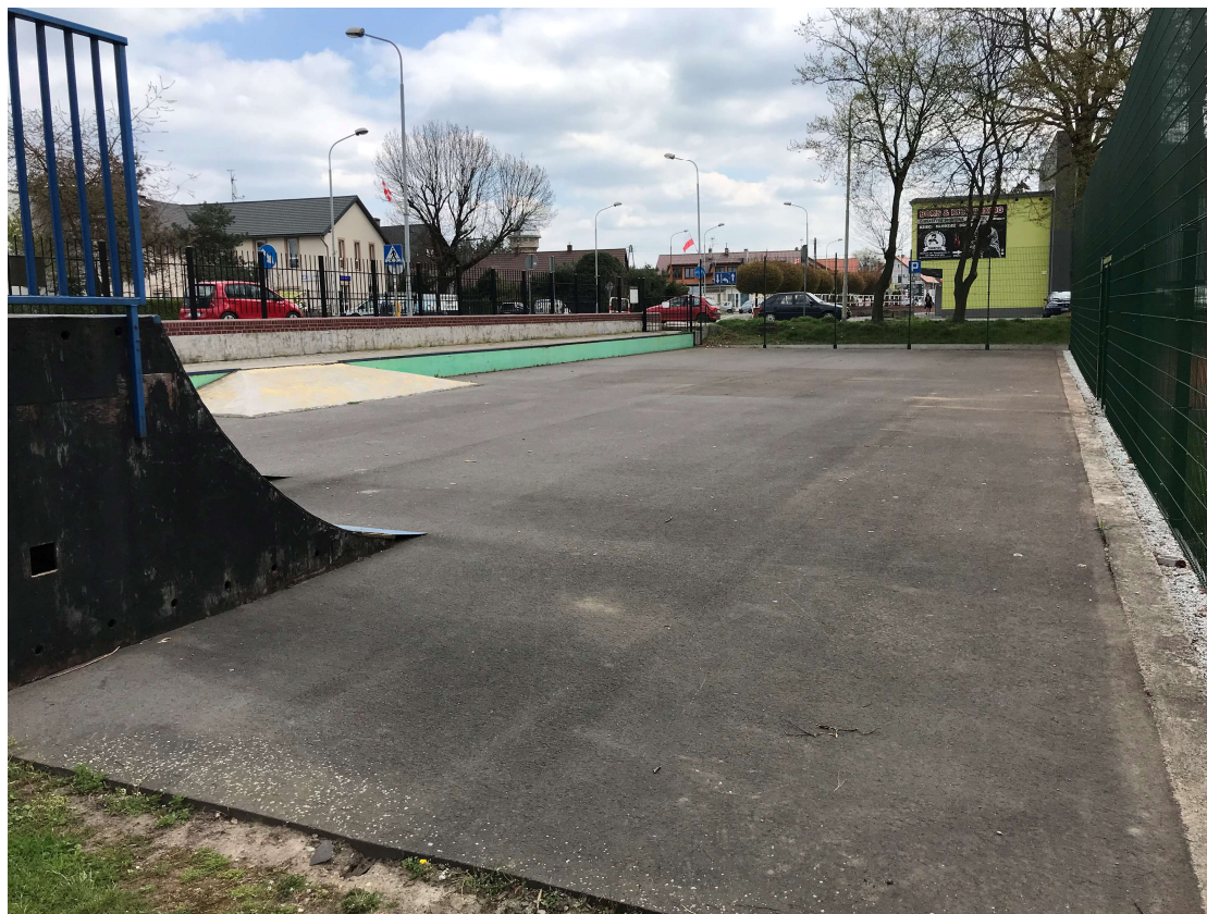
Fot. Widok na stronę północno- wschodnią
