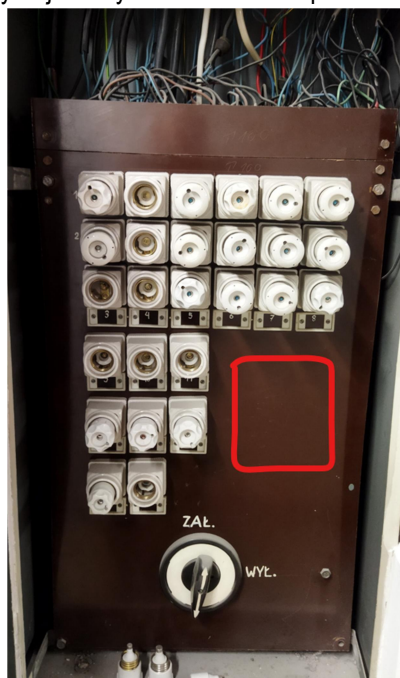
Proponowane miejsce montażu rozłącznika w rozdzielnicy T-100.
