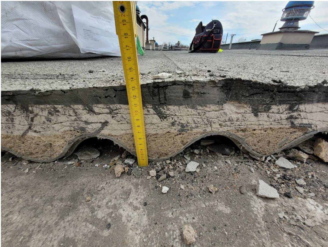
Rys. 17. Przekrój przez warstwy dachu.
