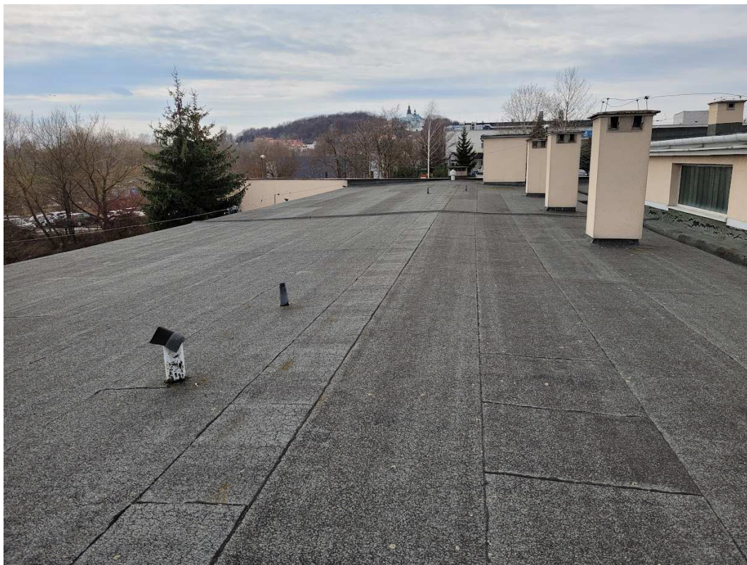
Rys. 15. Dach budynku kuchni.
