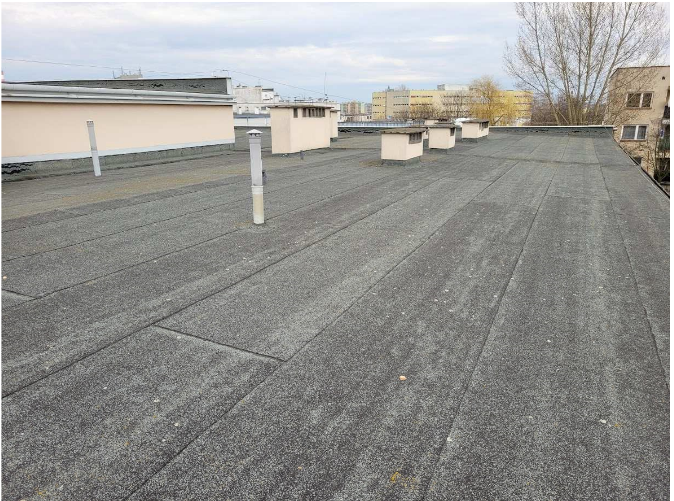
Rys. 14. Dach budynku pralni.
