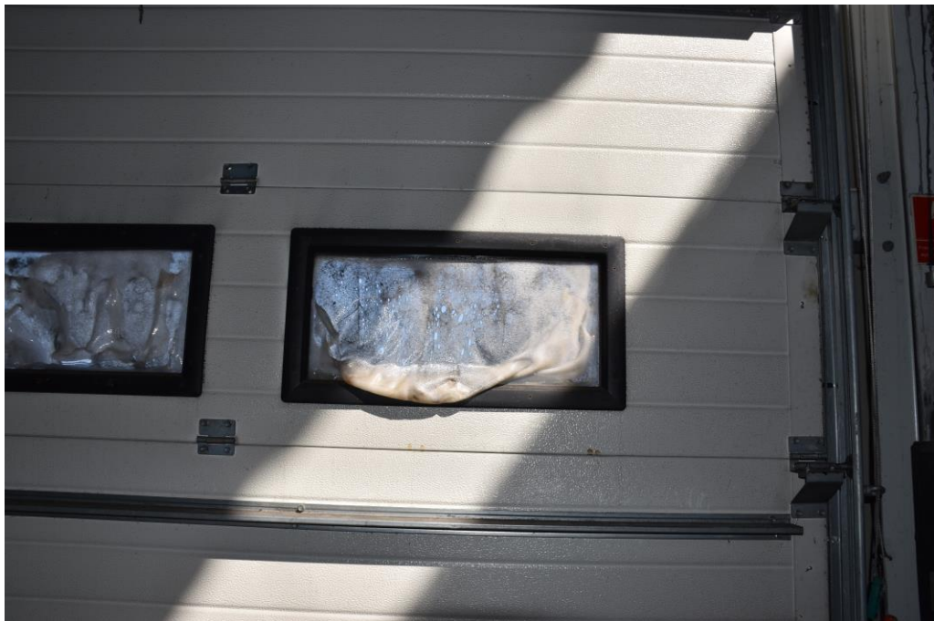
Rys.2e. Projektuje się wymianę lewej brama wjazdowej.
