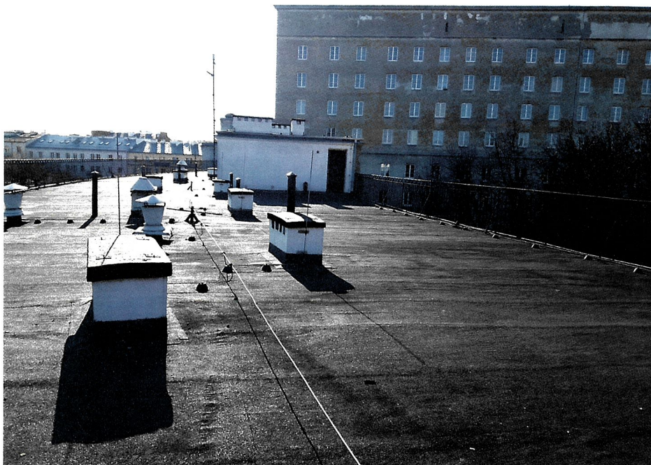
Zdj. 4. Istniejąca infrastruktura dachowa, m.in. mury, wentylatory, kominy, obróbki dachowe
