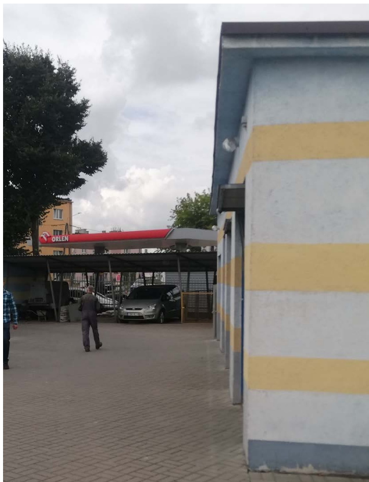
W głębi widok wiaty na agregat prądowłórczy
