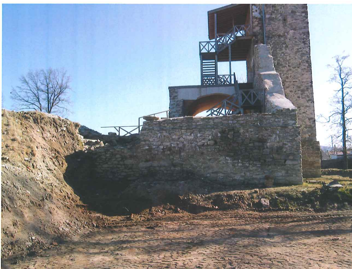
widok na zamek od północy po zakończeniu przesypywania nasypu
