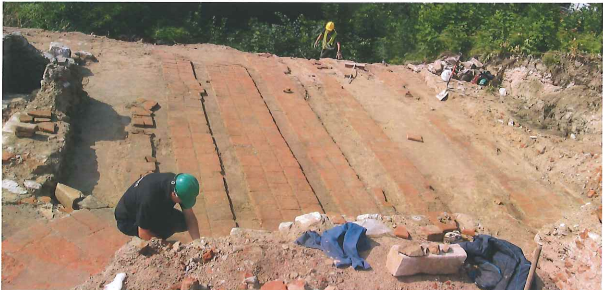
W trakcie prowadzenia prac porządkowych i odgruzowania odślonięto zachowane na sklepieniach piwnicznych posadzki ceglane, układane na zasypce piaskowej.
