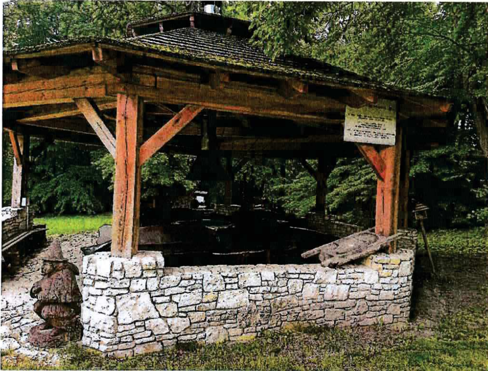
Fot. 1. Altana w pobliżu Dworu w Krzykawce, Widoczny zły stan gontów i roślinność porastającą na ich powierzchni. Pozostałe części drewniane w dobrym stanie, podobnie mur kamienny, na którym widoczne są zabrudzenia w partii przyziemnej.
