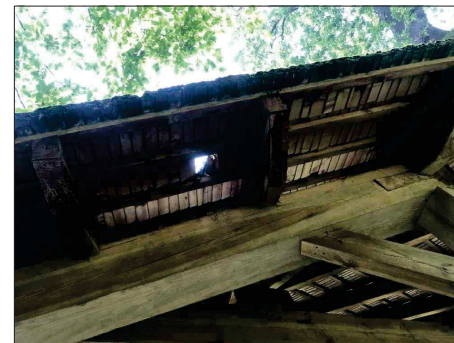
FOT. NR 5 - WIDOK NA DACH ALTANY OD WNETRZA ALTANY WIDOCZNY UBYTEK W POKRYCIU
