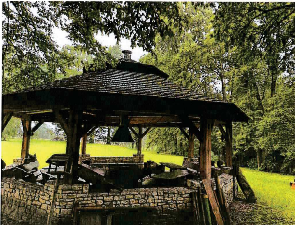
Fot. 2. Altana w pobliżu Dworu w Krzykawce, Widoczny zły stan gontów i roślinność porastającą na ich powierzchni. Altana znajduje się pod koronami drzew, będących źródłem zalegania materiału organicznego i zatrzymywania wilgoci.
