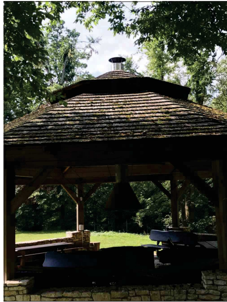
FOT. NR 1 - WIDOK ALTANY OD STRONY PÓLNOCNEJ
