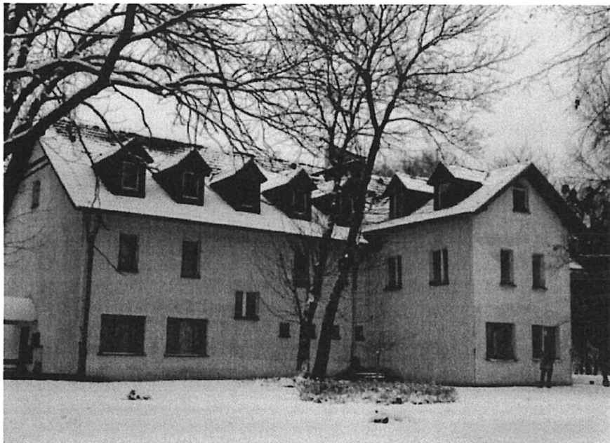
Fot. 1. Poglądowa fotografia budynku nr 10.
