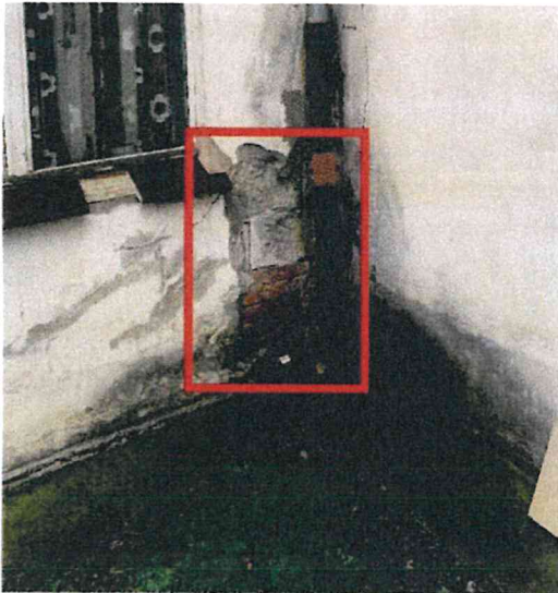
Fot. 6. Konstrukcja ścian nośnych potwierdzona na podstawie ubytków tynku oraz odkrywek.
