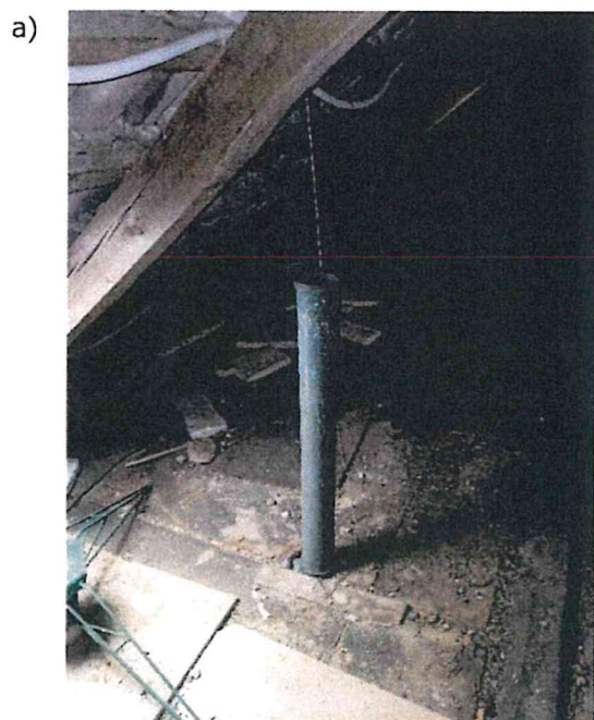
Fot. 19. Błędnie wyprowadzone kanały wentylacyjne oraz piony kanalizacyjne.
