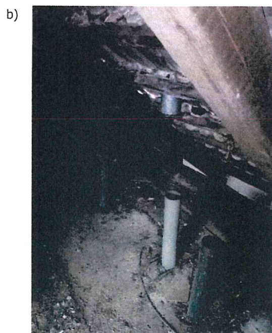
Fot. 19. Błędnie wyprowadzone kanały wentylacyjne oraz piony kanalizacyjne.
