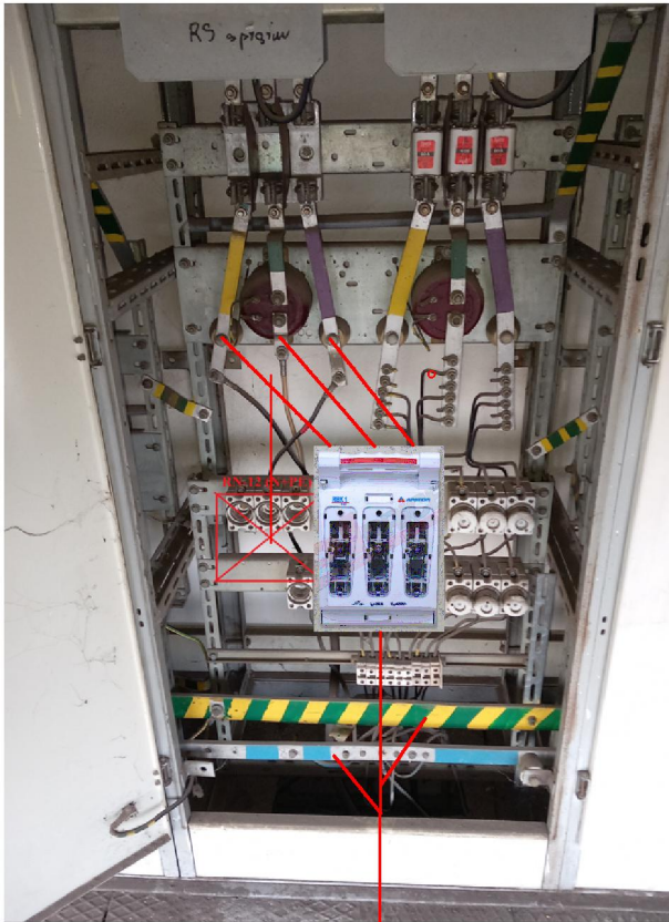
RBK1-250A z bezpiecznikami WTN1/gG 200A
