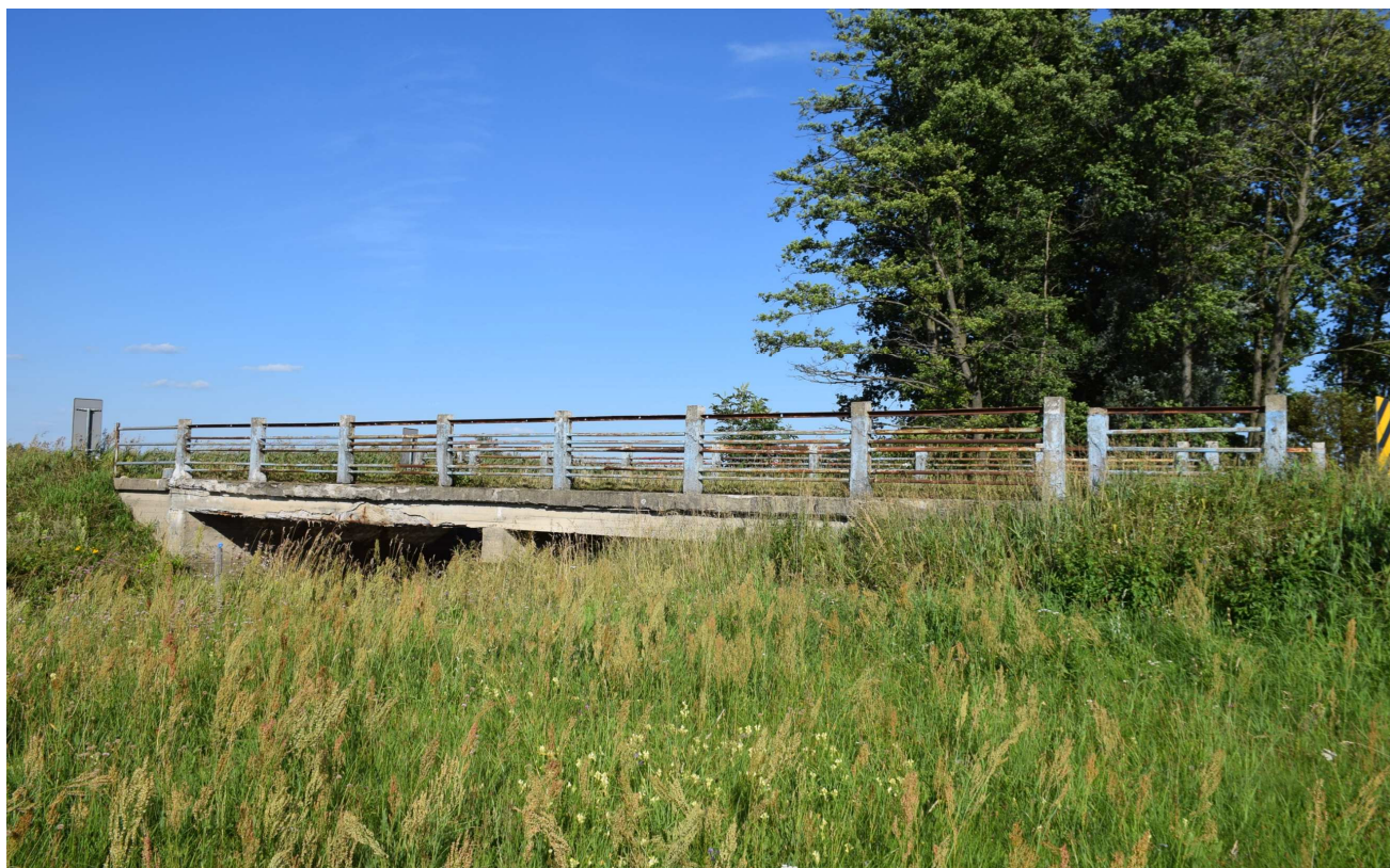
Widok ogólny obiektu mostowego
