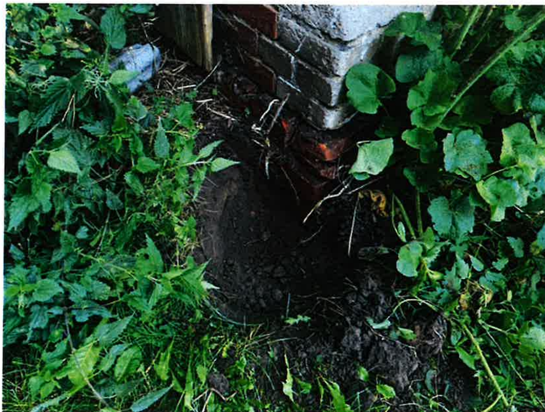
9.19 Odkrywka ściany piwnicznej w południowo-wschodnim narożniku budynku.
