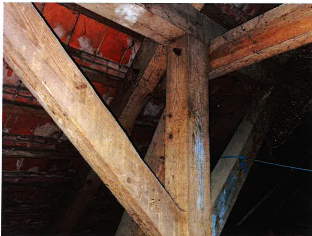
9.15 Węzeł drewnianej ramy pośredniej.
