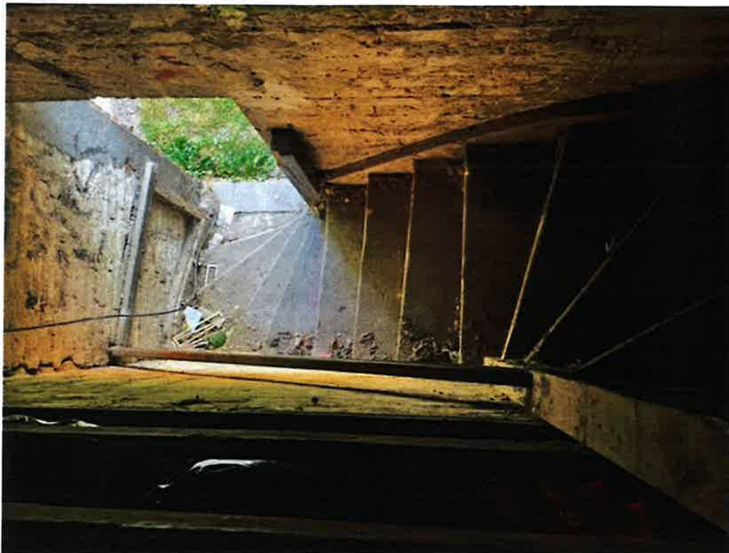
9.12 Schody drewniane na poddasze.
