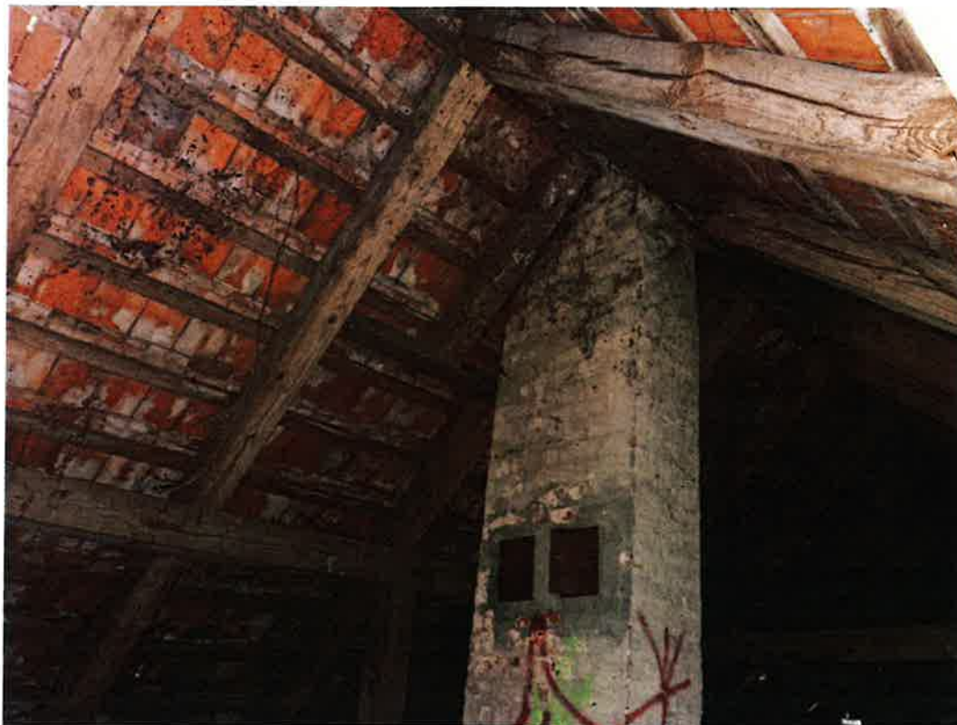
9.18 Komin murowany na poddaszu.
