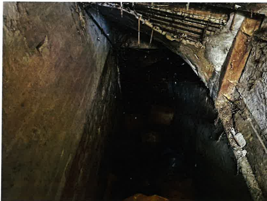
9.5 Zejście do piwnicy.
