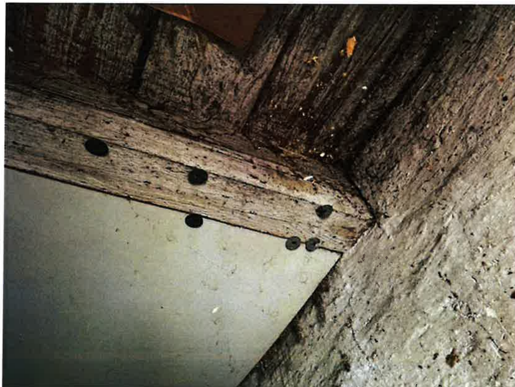
9.9 Konstrukcja stropu drewnianego nad parterem.
