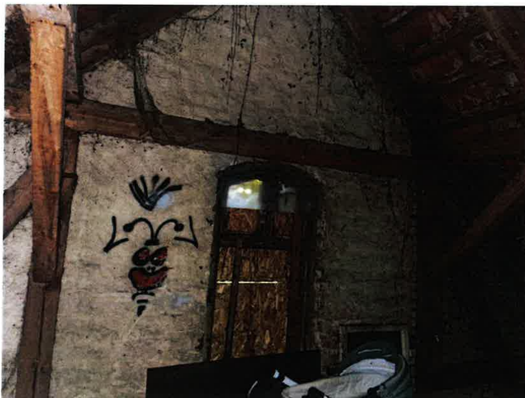
9.17 Południowa ściana szczytowa.
