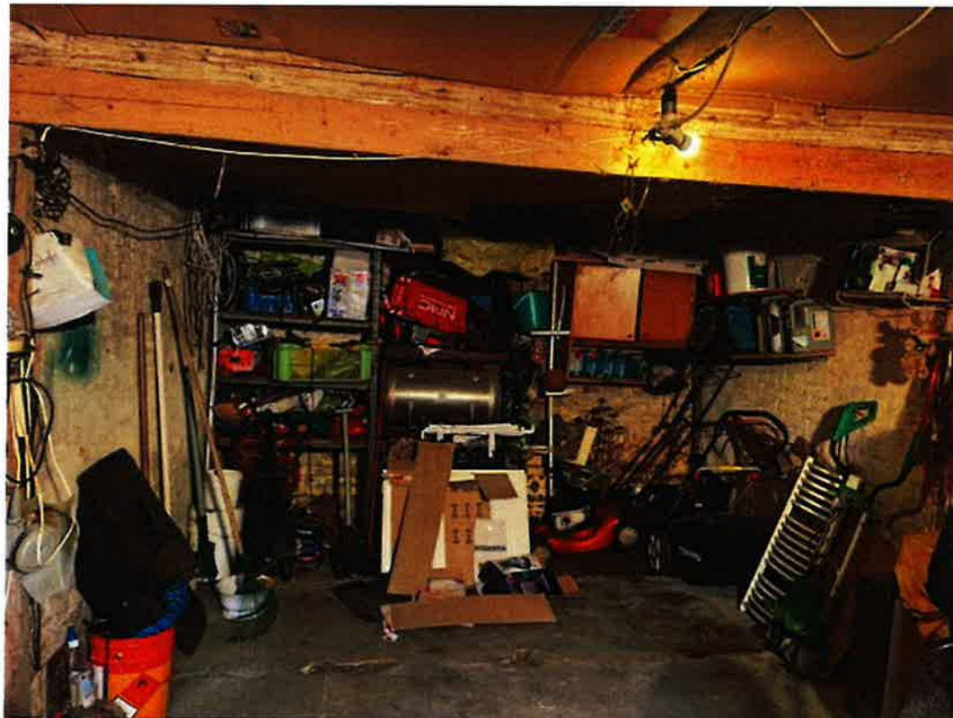
9.11 Podciąg drewniany w pomieszczeniu garażu.
