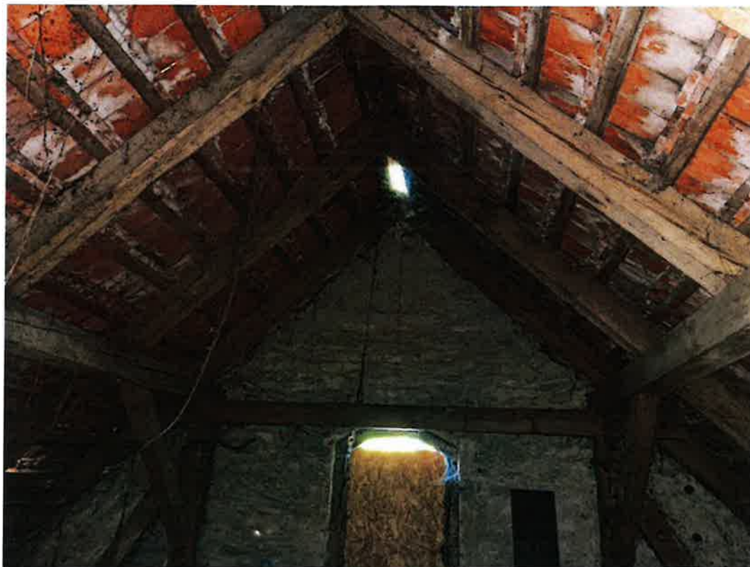
9.14 Konstrukcja więźby dachowej i północna ściana szczytowa.
