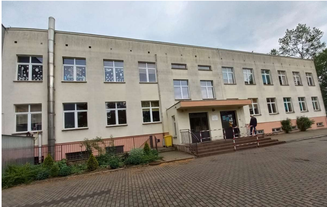
Zdj. 3. Elewacja południowa (część szkolna)
