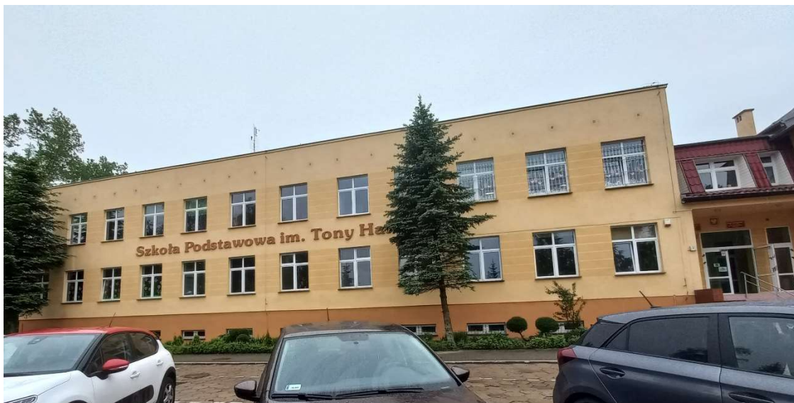
Zdj. 2. Elewacja północna ( frontowa – część szkolna)
