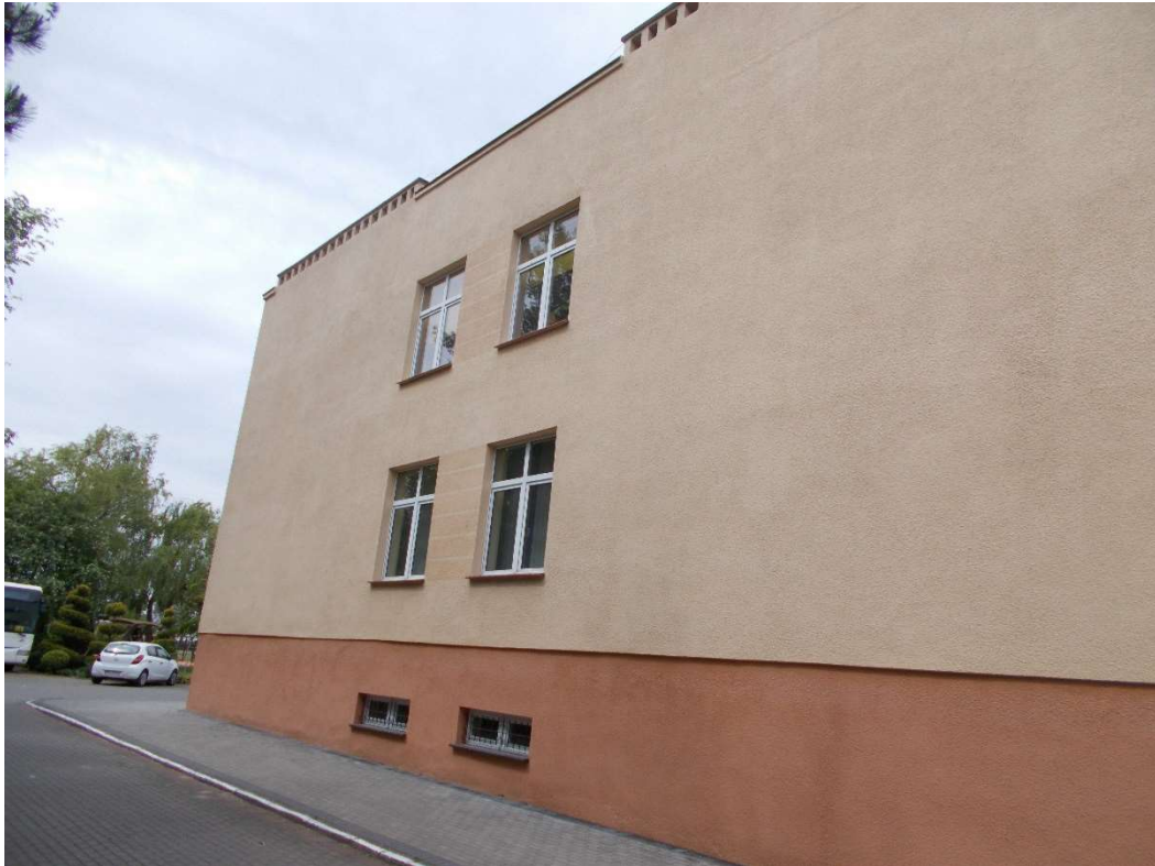
Zdj. 6. Elewacja wschodnio
