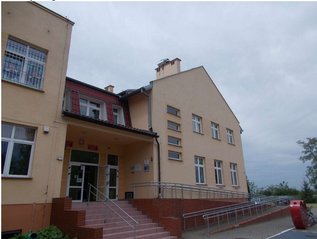
Zdj. 1. Elewacja północna ( frontowa – wejście główne i część przedszkolna)
