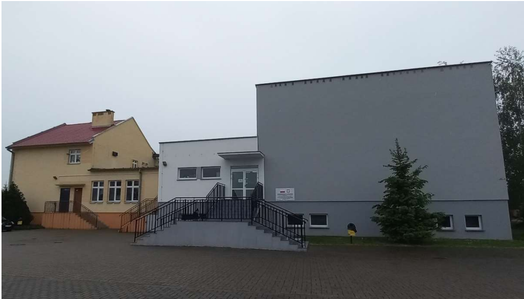
Zdj. 4. Elewacja zachodnia
