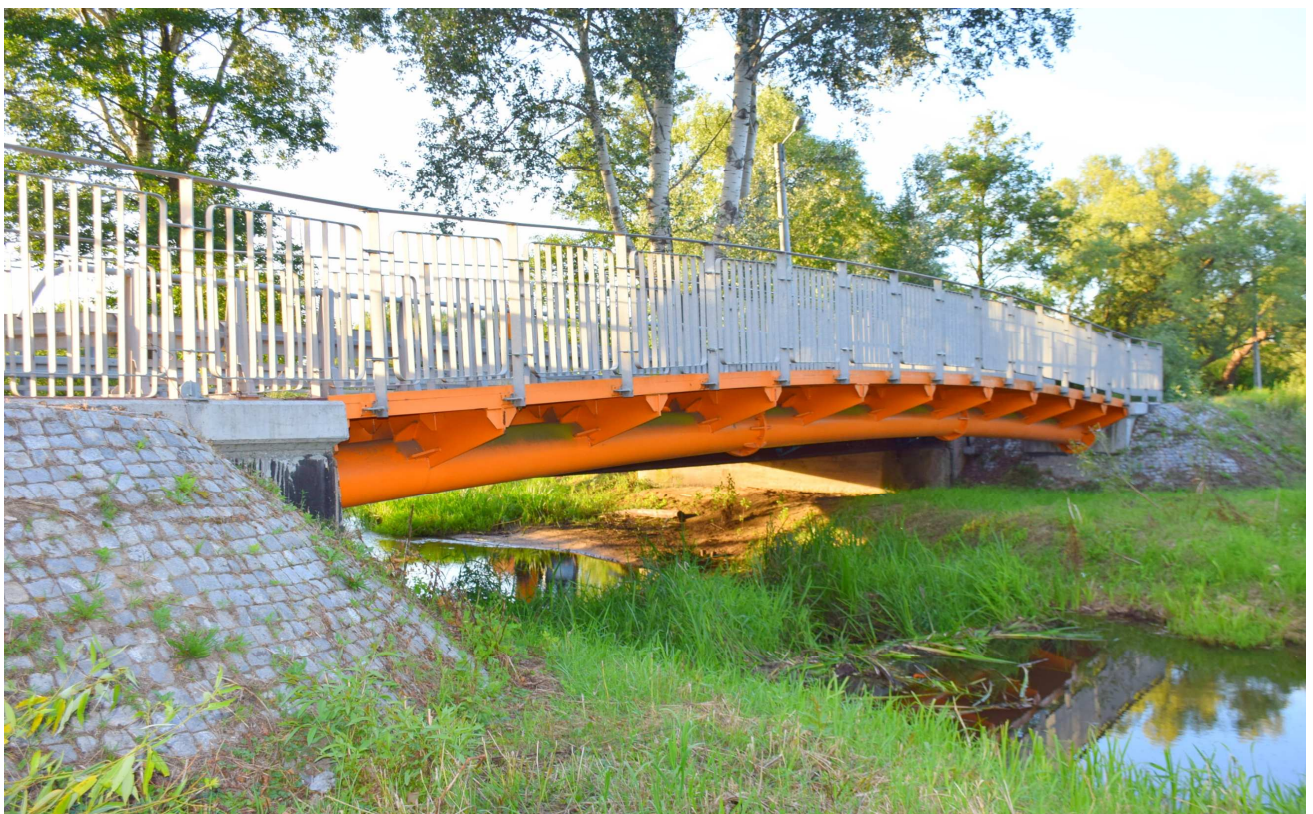
Widok ogólny obiektu mostowego
