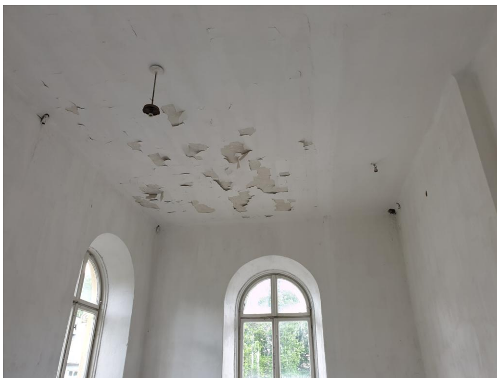
Fot.31,32.Łazienki borowinowe .Stan zachowania historycznej stolarki okiennej - czerwiec 2021
