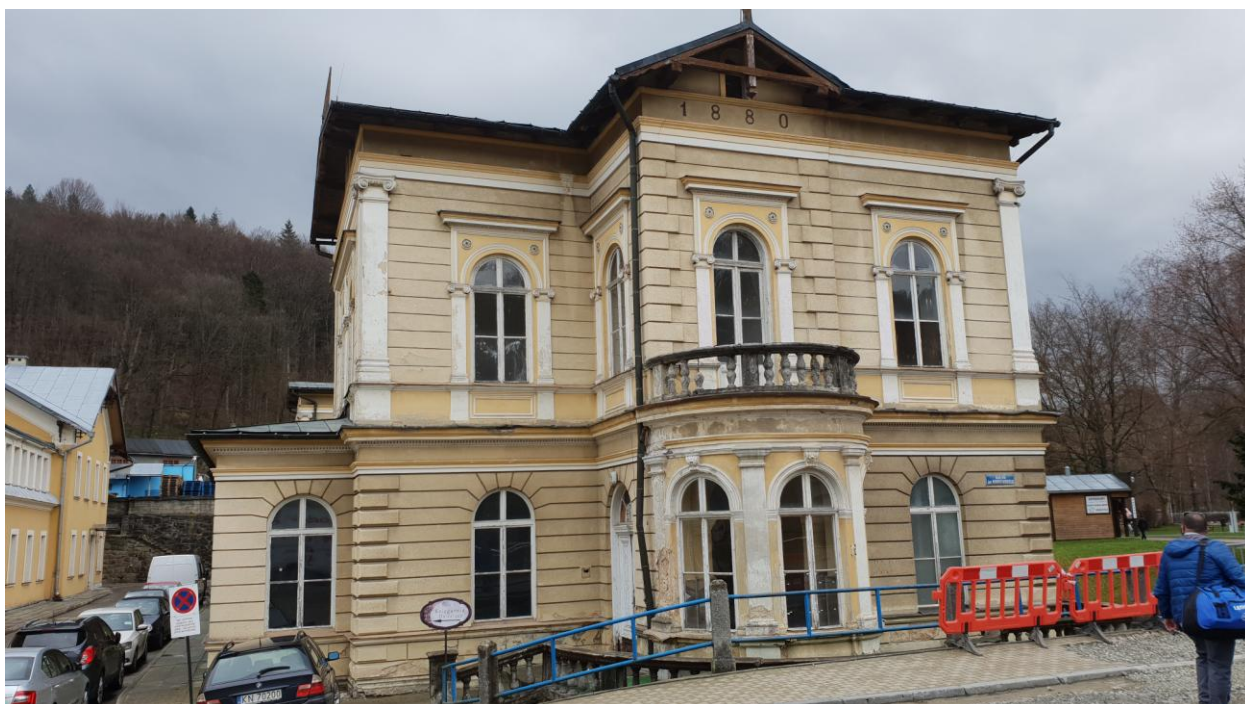
Fot.18 łaźienki borowinowe .Stan zachowania elewacji - czerwiec 2021
