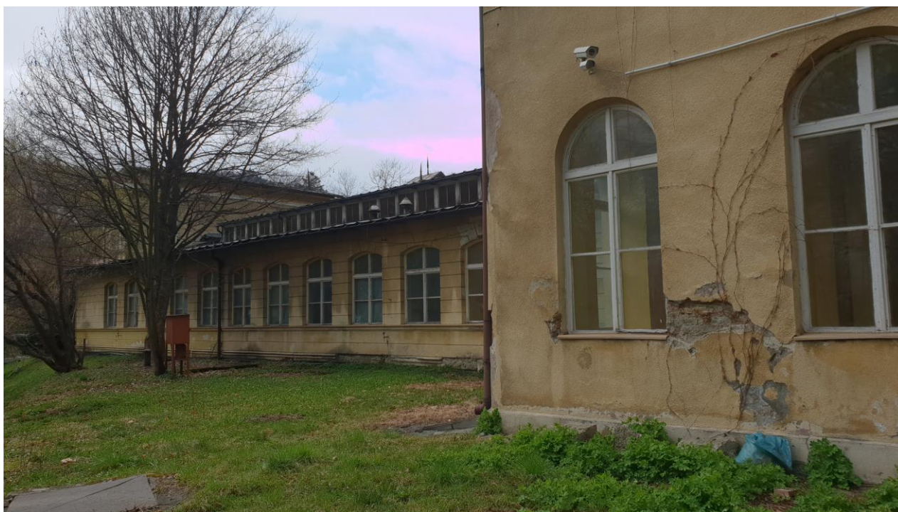
Fot.17 łaźienki borowinowe .Stan zachowania elewacji - czerwiec 2021.
