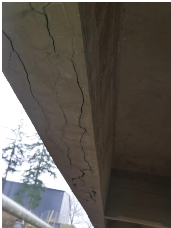
Fot. 23. Belka skrajna od strony południowego zachodu (analogicznie pozostałe belki skrajne).
