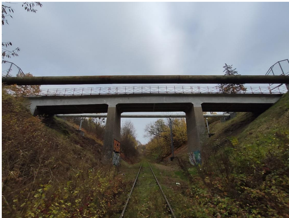
Fot. 37. Przestrzeń pod obiektowa.
