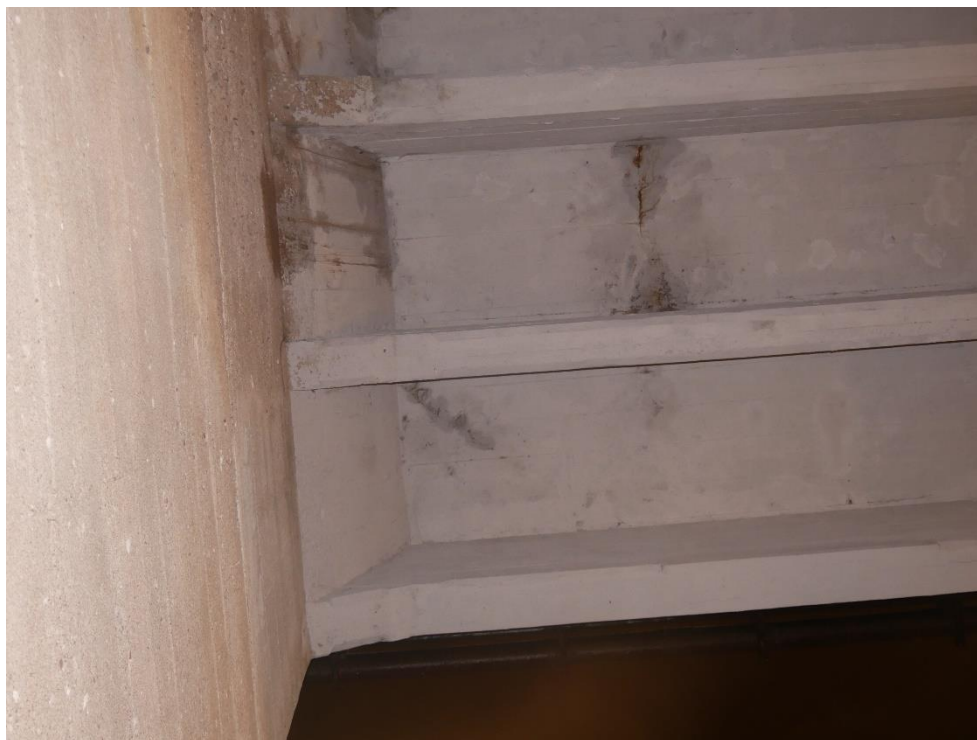
Fot. 28. Poprzecznicą nadpodporowa (nad filarem).
