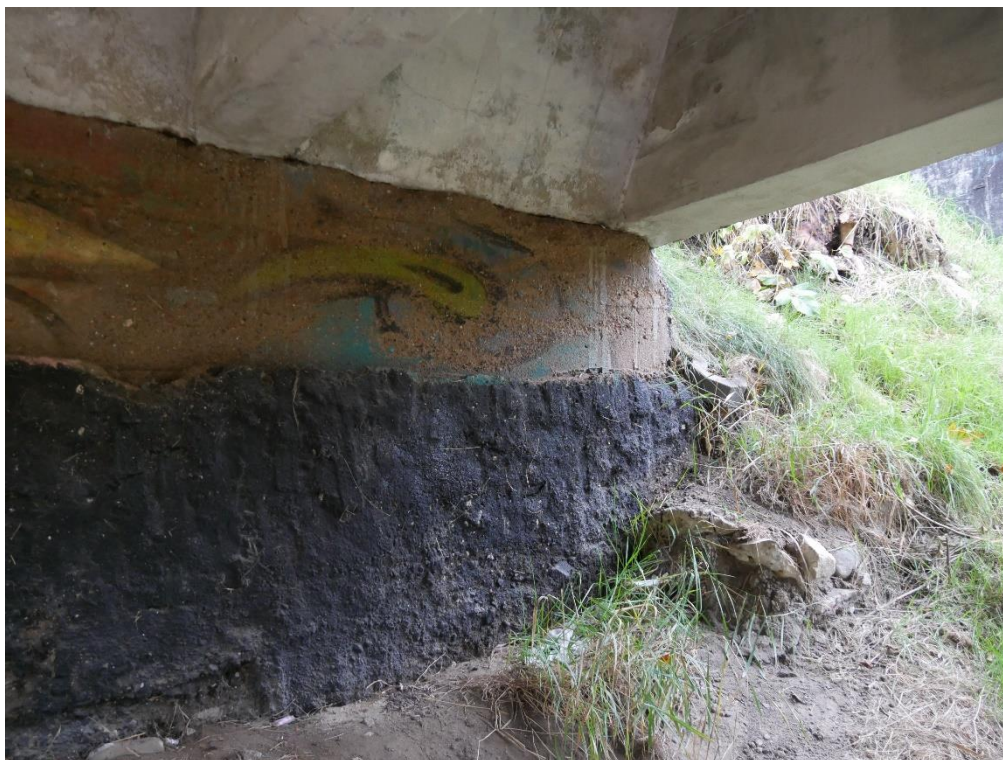
Fot. 5. Widok przyczółka od strony południowej.
