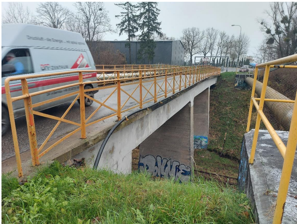
Fot. 17. Balustrada stalowa.
