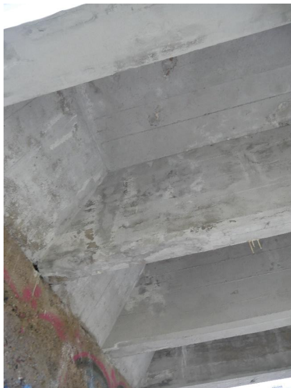
Fot. 29. Poprzecznica nadpodporowa (nad przyczółkiem).
