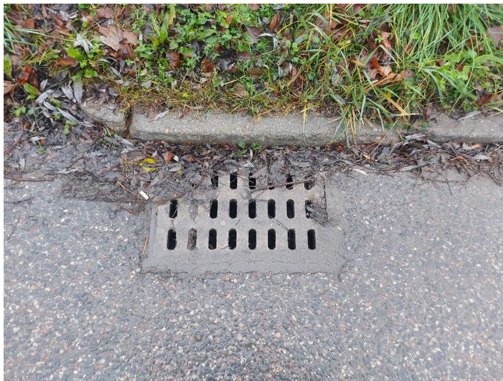
Fot. 14. Wpust drogowy na dojeździe.
