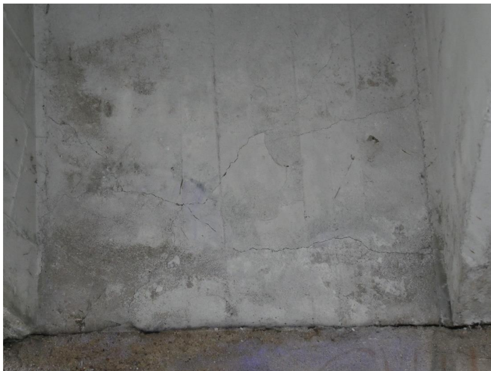
Fot. 24. Poprzecznicą nadporowa (nad przyczółkiem).
