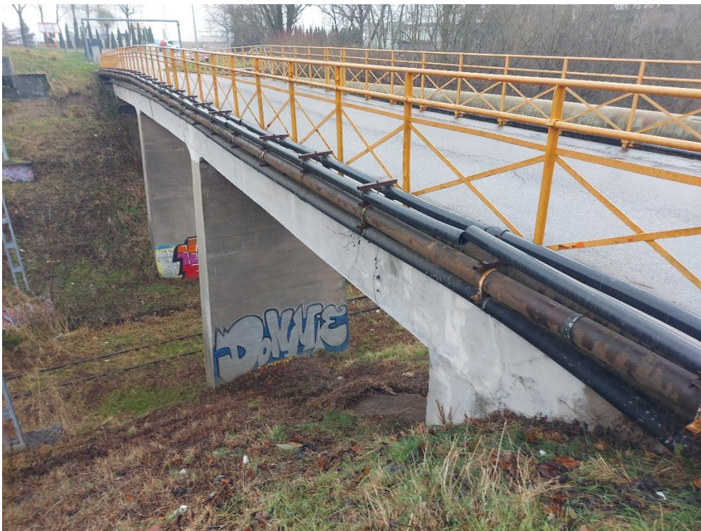
Fot. 2. Widok na wiadukt z boku od strony południowo-zachodniej.
