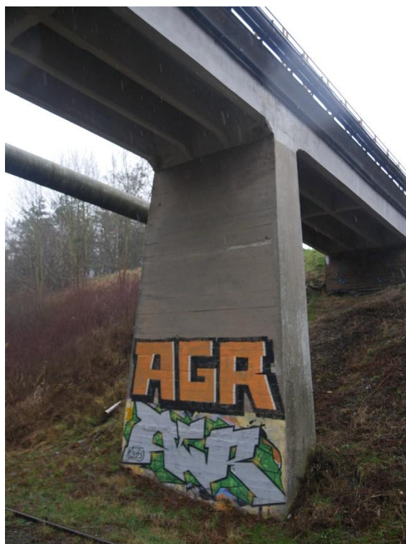
Fot. 6. Widok filara od strony północnej.
