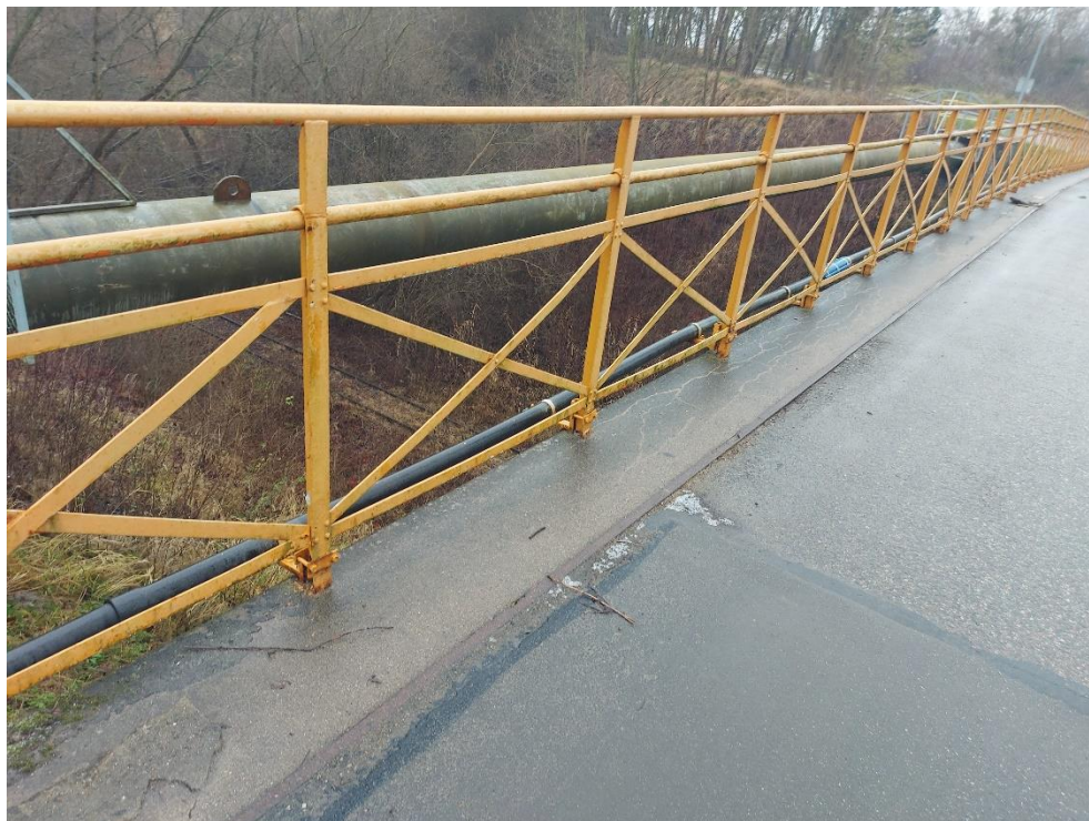
Fot. 15. Balustrada stalowa.
