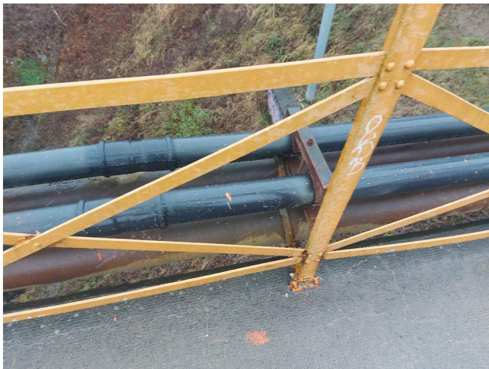
Fot. 16. Balustrada stalowa.
