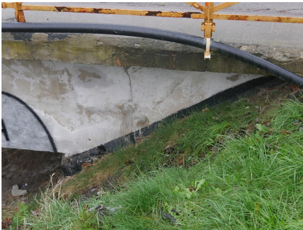
Fot. 22. Skrzydło od strony południowo zachodniej, balustrada.
