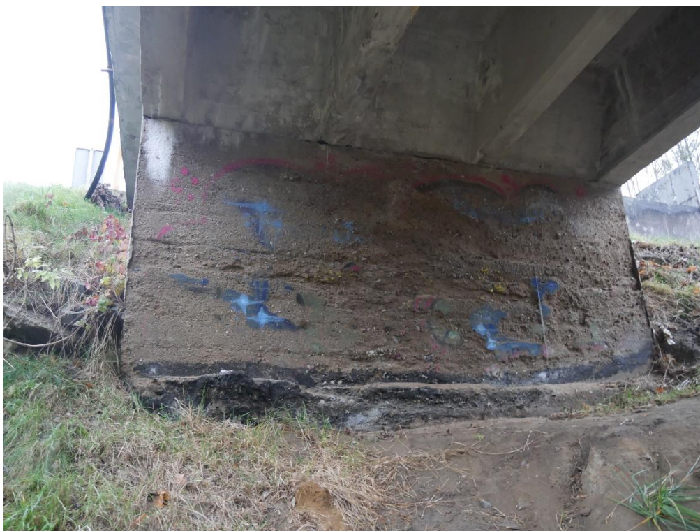
Fot. 4. Widok przyczółka od strony północnej.
