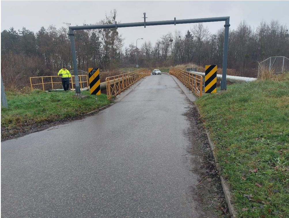
Fot. 1. Widok na wiadukt – w stronę północną.
