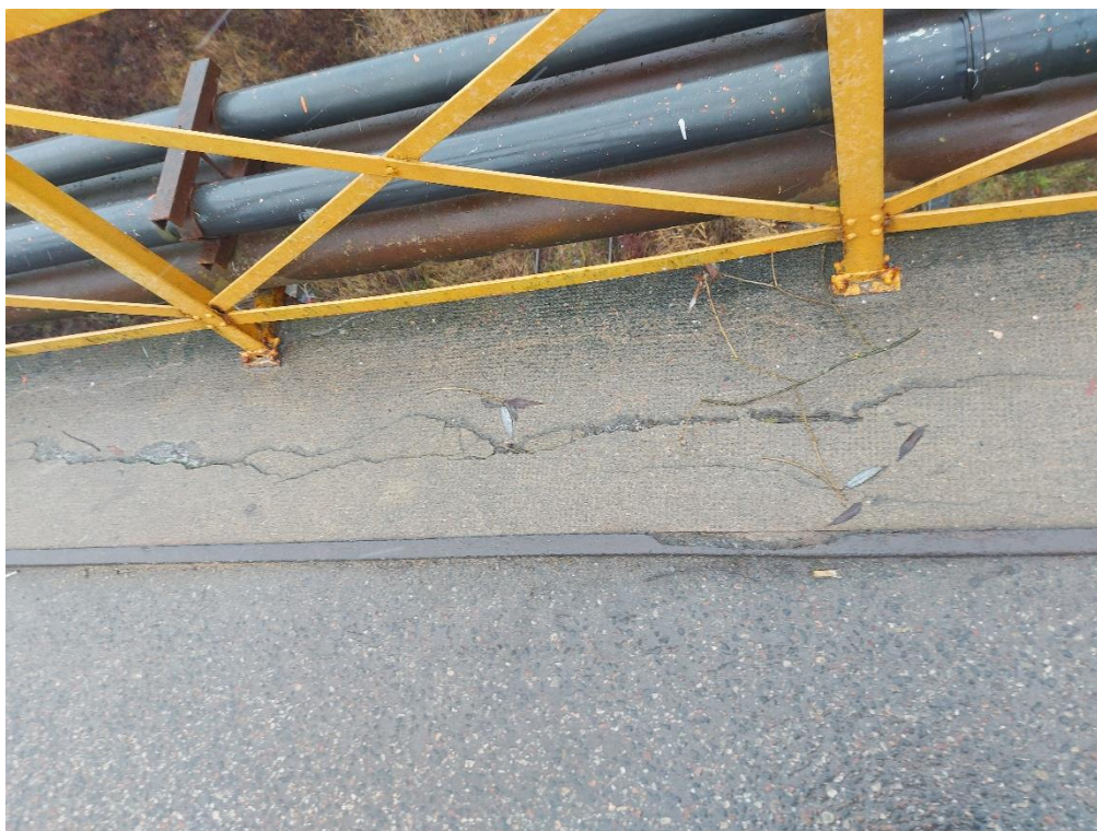
Fot. 12. Kapa chodnikowa po stronie wschodniej.
