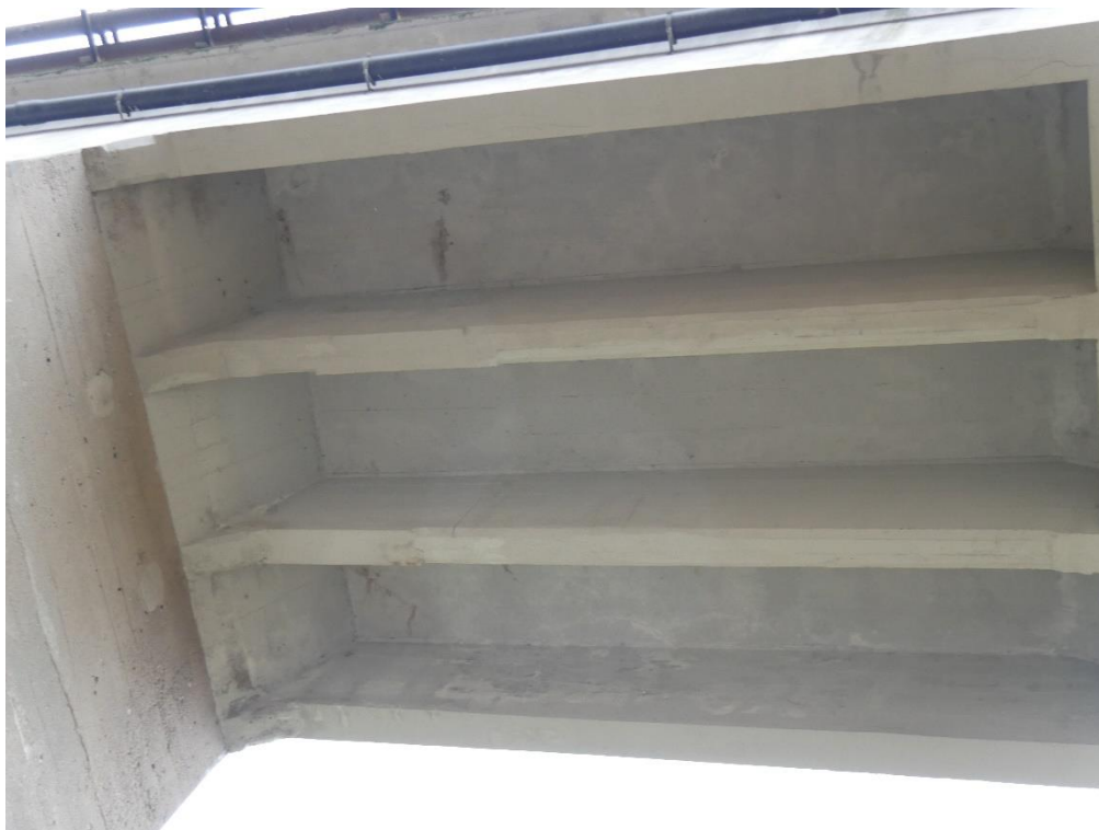
Fot. 3. Widok spodu ustroju nośnego.
