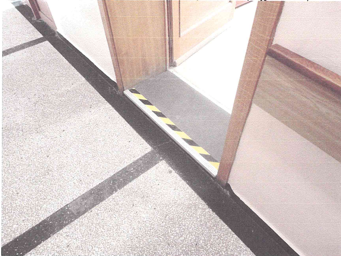
Nr 3 – Likwidacja progów w drzwiach wejściowych do pomieszczeń (księgowość nr 1)
