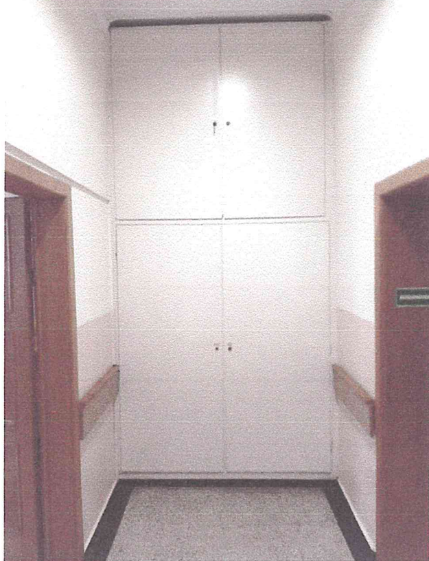
Nr 8 – Wymiana drzwi drewnianych do zabudowy meblowej – korytarz II piętro
