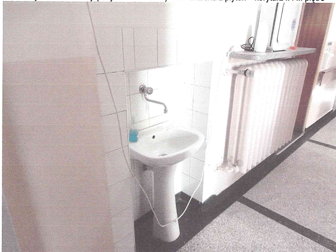
Nr 2 – Wymiana armatury (umywalka i bateria) oraz fartucha z płytek – korytarz II i III piętro
