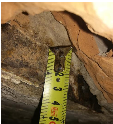
Nr16. Pomiar stalowych płaskowników zbrojących płytę ceramiczną stropu Kleina- płaskowniki 25x1,5mm.
