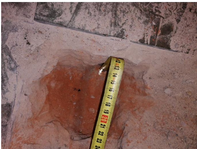
Nr7. Odkrywka warstw stropowych stropu nad piwnica- ODKRYWKA NR2- odwiercono łączną grubość warstw posadzkowych nad płytą ceramiczną stropu Kleina – około 13cm.
