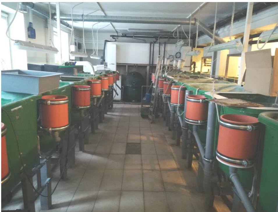
Nr3. Istniejące zbiorniki na stalowych nóżkach do hodowli ryb- ciężar zbiornika z wodą około 600kg.
