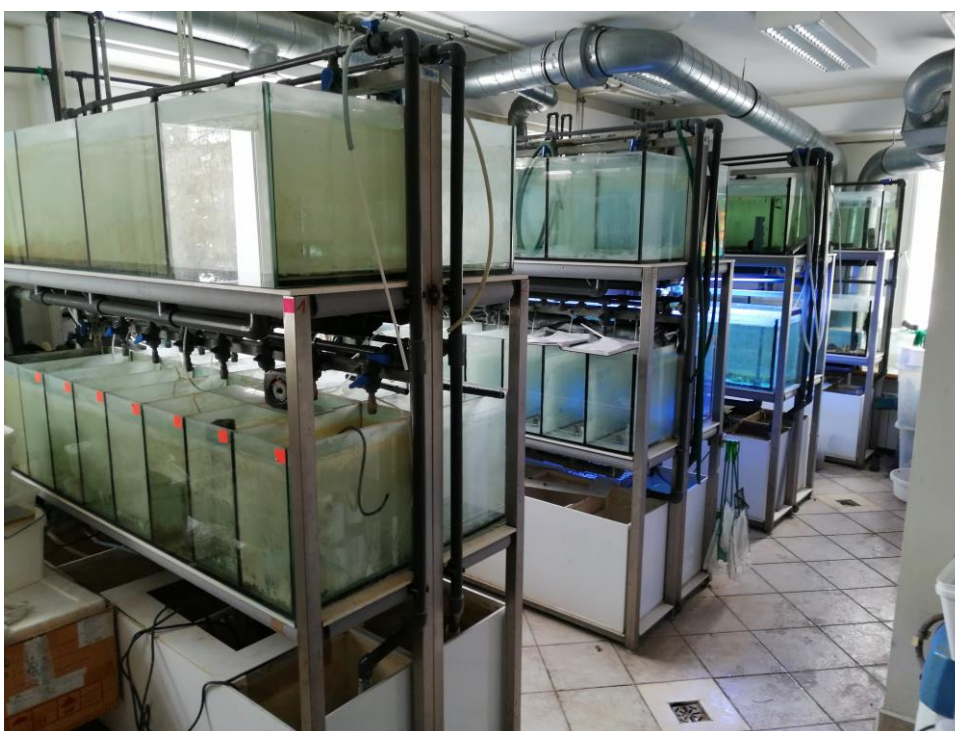
Nr4. Istniejące regały z akwariami szklanymi- ciężar pojedynczego zestawu około 1800kg.
