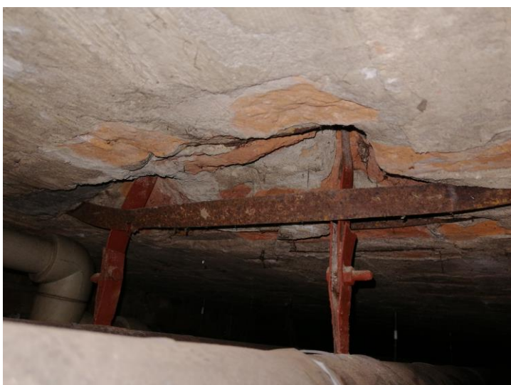
Nr19-20. Widok punktowych podwieszeń do płyty ceramicznej nad częścią korytarzową piwnicy- podwieszenia co około 2m.
