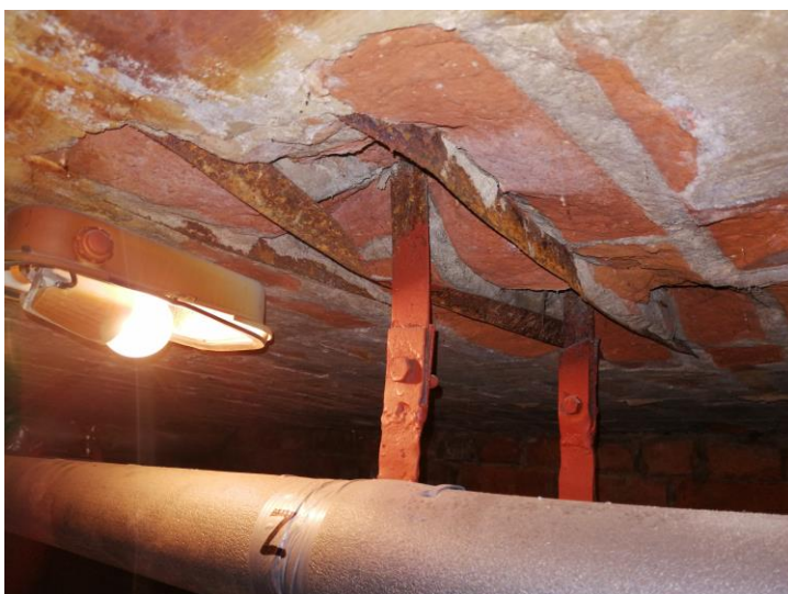
Nr17-18. Widok stalowych płaskowników zbrojących płytę ceramiczną stropu Kleina- silna korozja doprowadzająca do degradacji przekroju.
