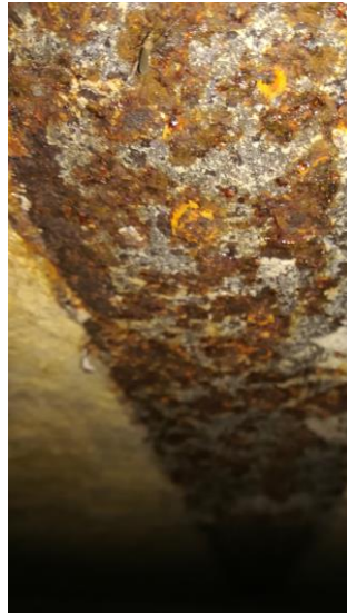
Nr13-14. Widok stalowych belek stropu Kleina nie osłoniętych od spodu tynkiem cementowym. Bardzo silna korozja elementu na całej długości o charakterze łuszczącym.
