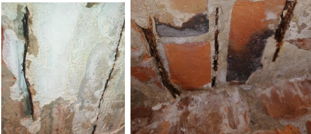
Nr17-18. Widok stalowych płaskowników zbrojących płytę ceramiczną stropu Kleina- silna korozja doprowadzająca do degradacji przekroju.
