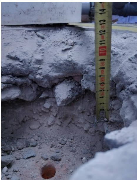
Nr10. Odkrywka warstw stropowych stropu nad piwnica- ODKRYWKA NR5- odwiercono łączną grubość warstw posadzkowych nad płytą ceramiczną stropu Kleina – 21cm, na zdjęciu widoczny pomiar od góry stopki belki stalowej do warstwy płytek -13cm.
