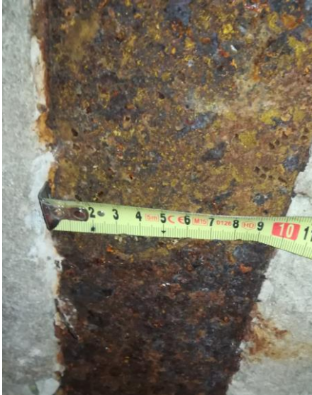
Nr13-14. Widok stalowych belek stropu Kleina nie osłoniętych od spodu tynkiem cementowym. Bardzo silna korozja elementu na całej długości o charakterze łuszczącym.
