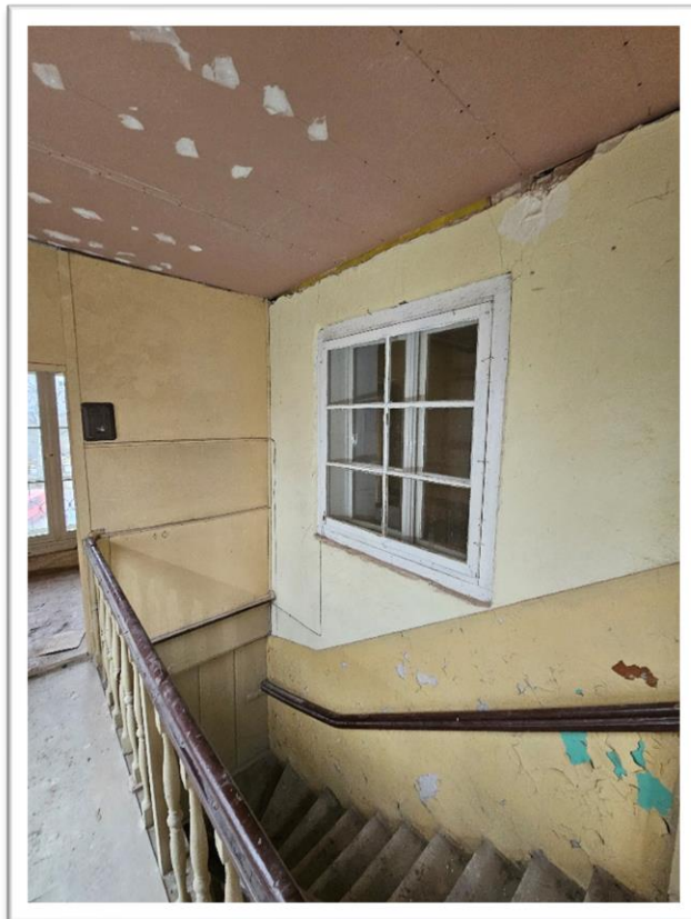
Fotografia 42 Stan istniejący (inventaryzacja pom. 12 piętro) – Komunikacja (proj. pom. 1.17) – widok stanu po adaptacji pomieszczeń na mieszkanie (przedpokój).
