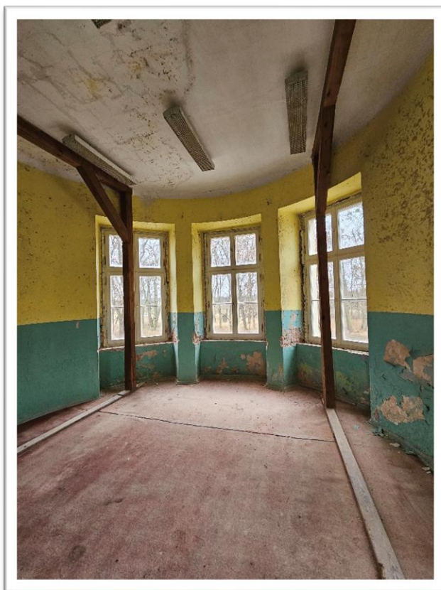
Fotografia 23 Stan istniejący (inventaryzacja pom. 10 parter) – Sala ślubów (proj. pom. 1.14) – widok stanu po adaptacji pomieszczeń na mieszkanie/klasę widoczne wyparcie stropu.
