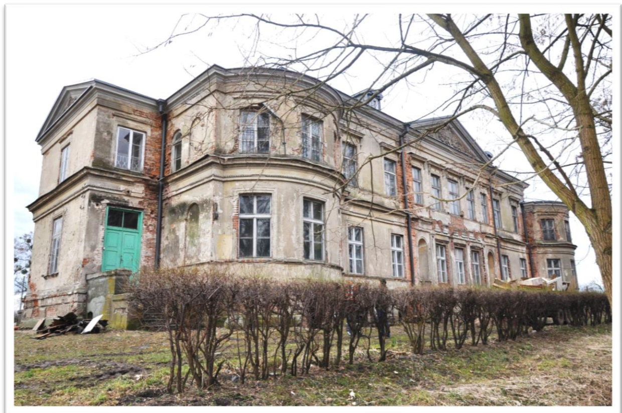
Fotografia .4Widok elewacji tylnej2022 rok.
