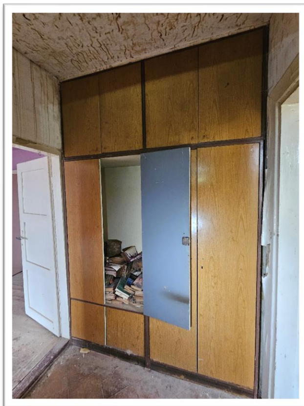
Fotografia 19 Stan istniejący (inventaryzacja pom. 14 parter) – Sala życzeń (proj. pom. 1.13) – widok stanu po adaptacji pomieszczeń na mieszkanie (korytarz).
