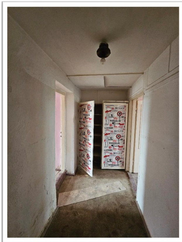
Fotografia 32 Stan istniejący (inventaryzacja pom. 09 parter) – Sala bankietowa (proj. pom. 1.15) – widok stanu po adaptacji pomieszczeń na mieszkanie (przedpokój).
