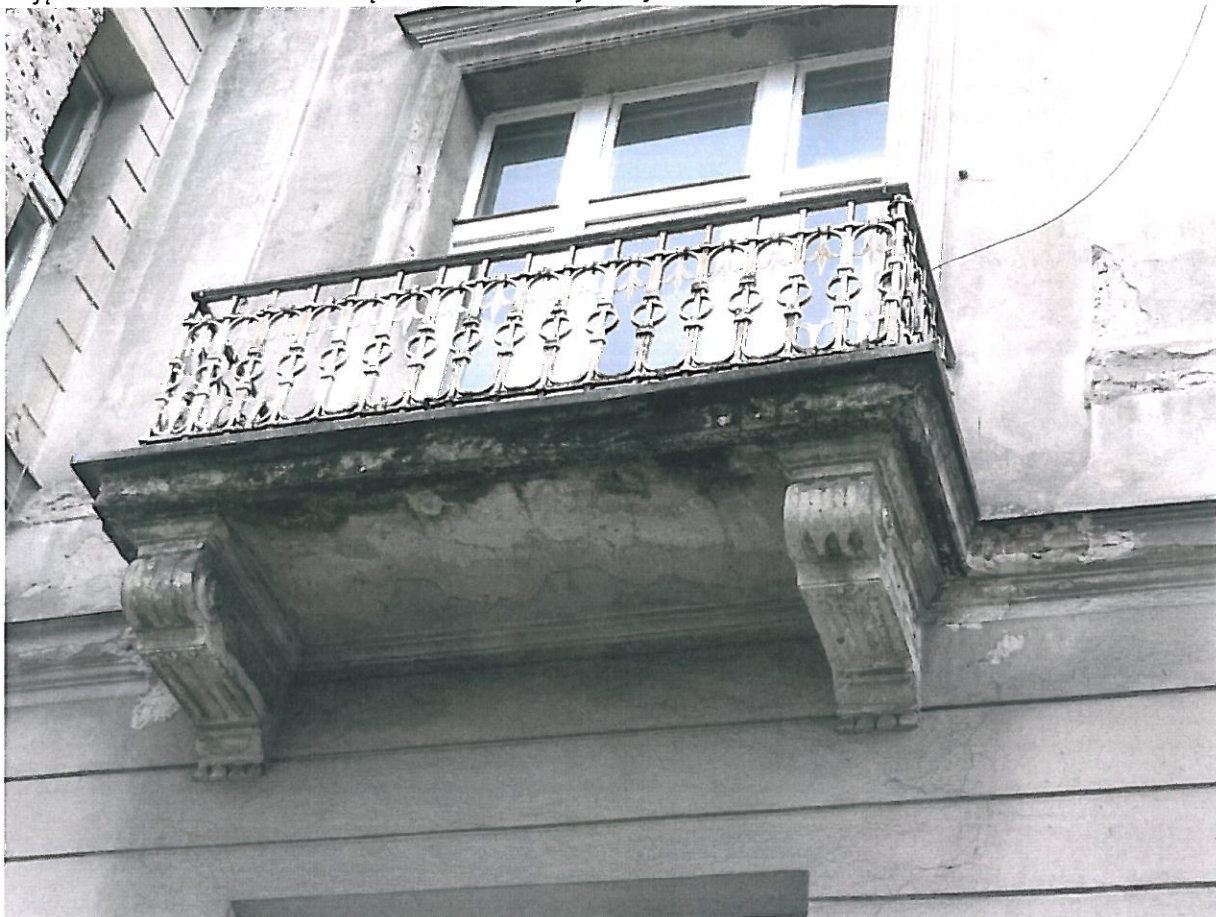
Zdjęcie 03. Uszkodzenia w obrębie balkonów i wykuszy
