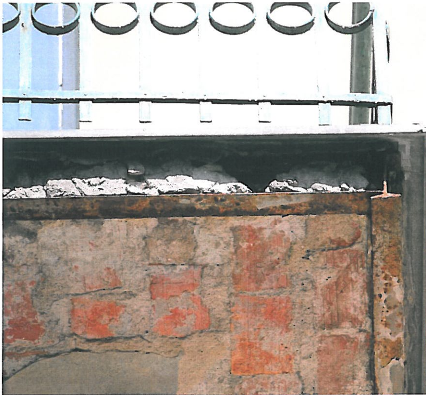
Fot. 23 – Balkon nr 7 – deformacja węzła, korozja belek
