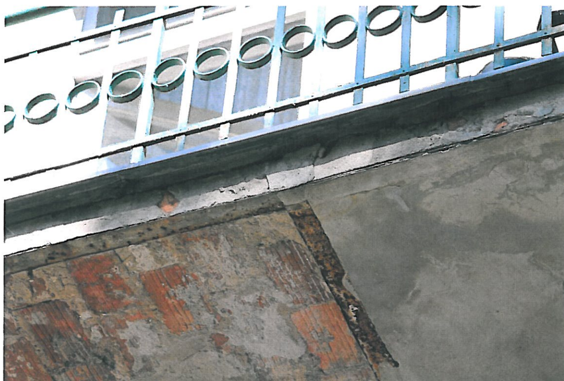
Fot. 12 – Balkon 2 – węzeł środkowy – korozja belek
