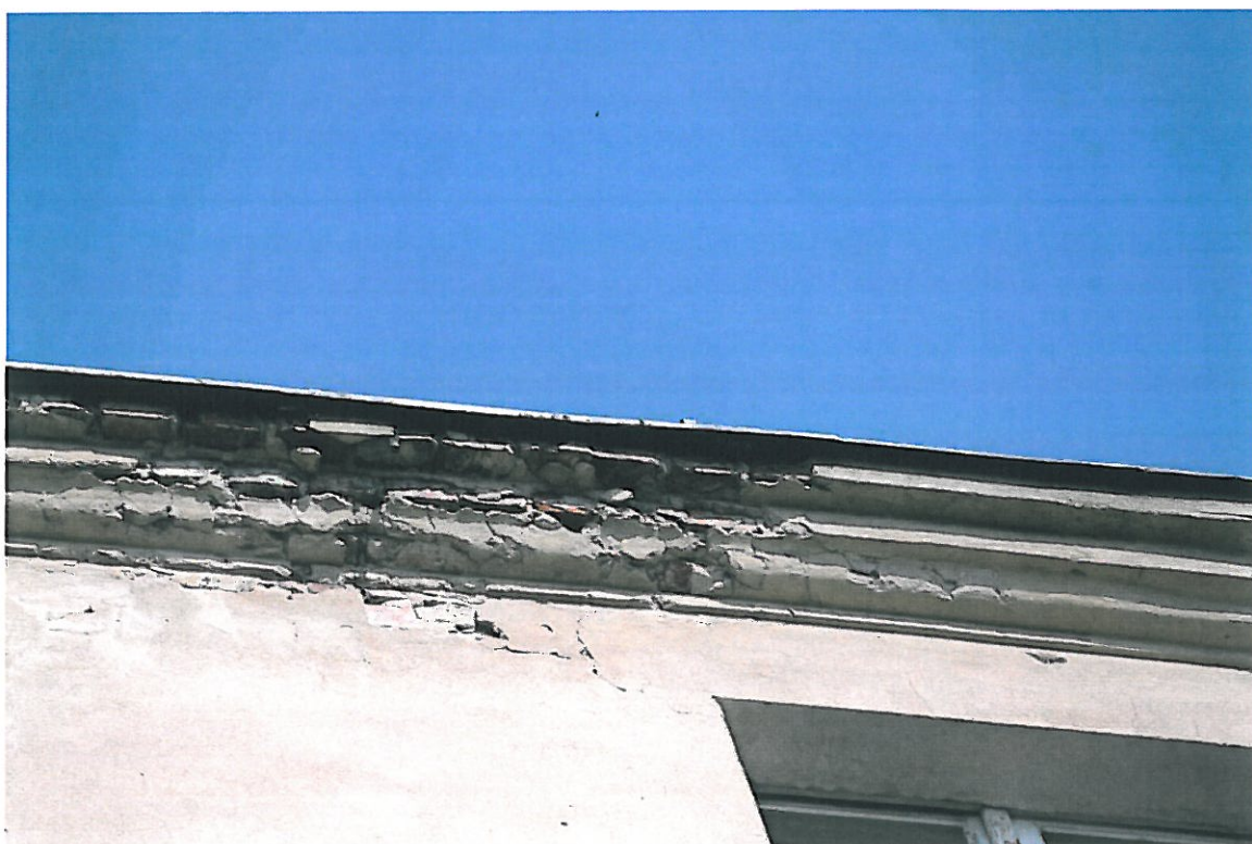
Fot. 28 – Elewacja tylna – uszkodzenia gzymsu
