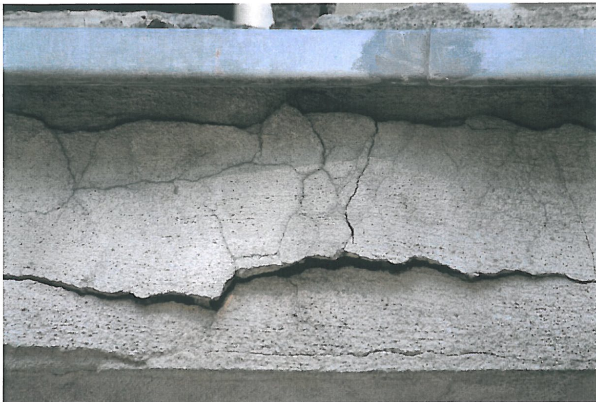
Fot. 9 – Balkon 1 – spękane oszpaldowanie i tynk belki wzdłużnej
