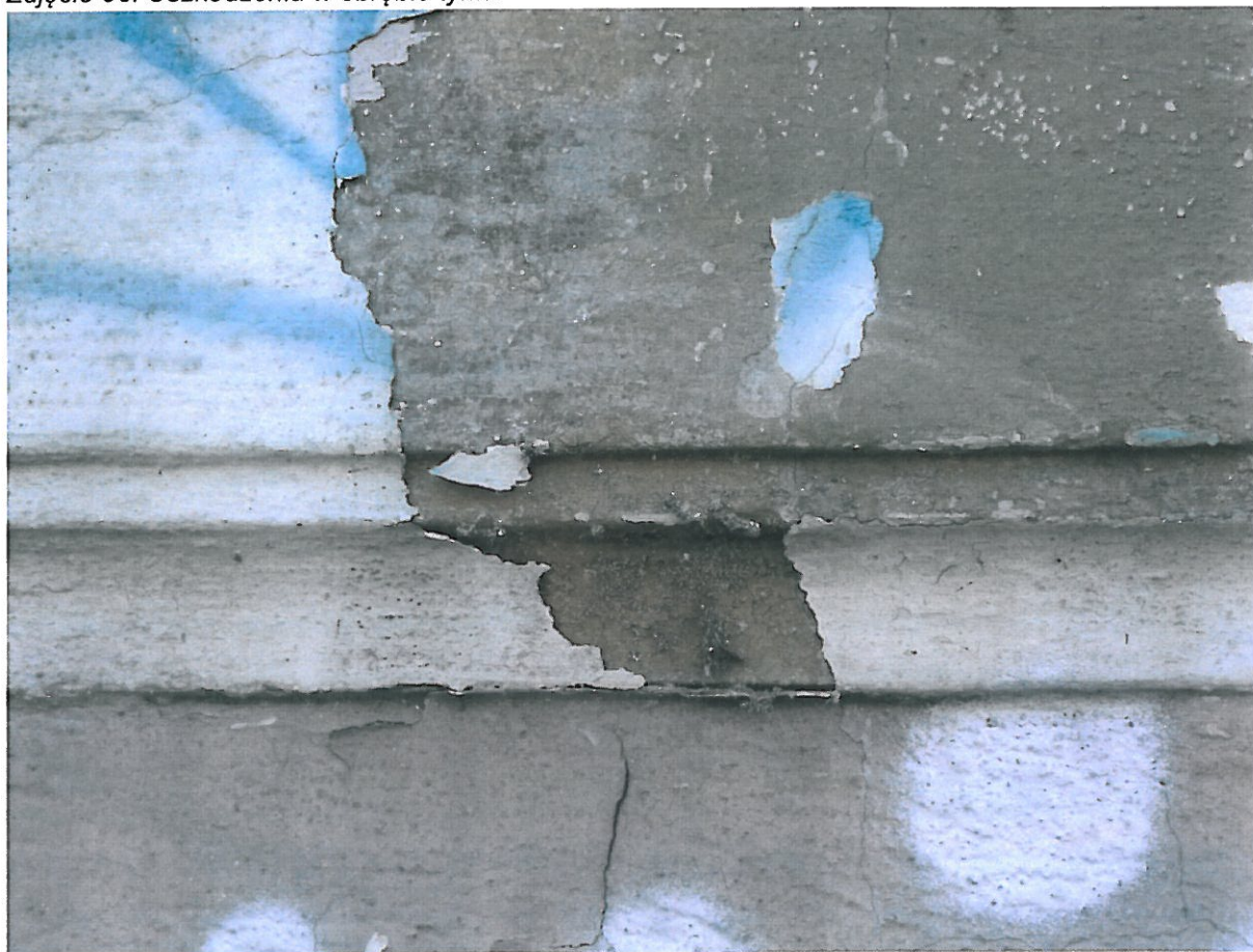
Zdjęcie 06. Uszkodzenia w obrębie tynku
