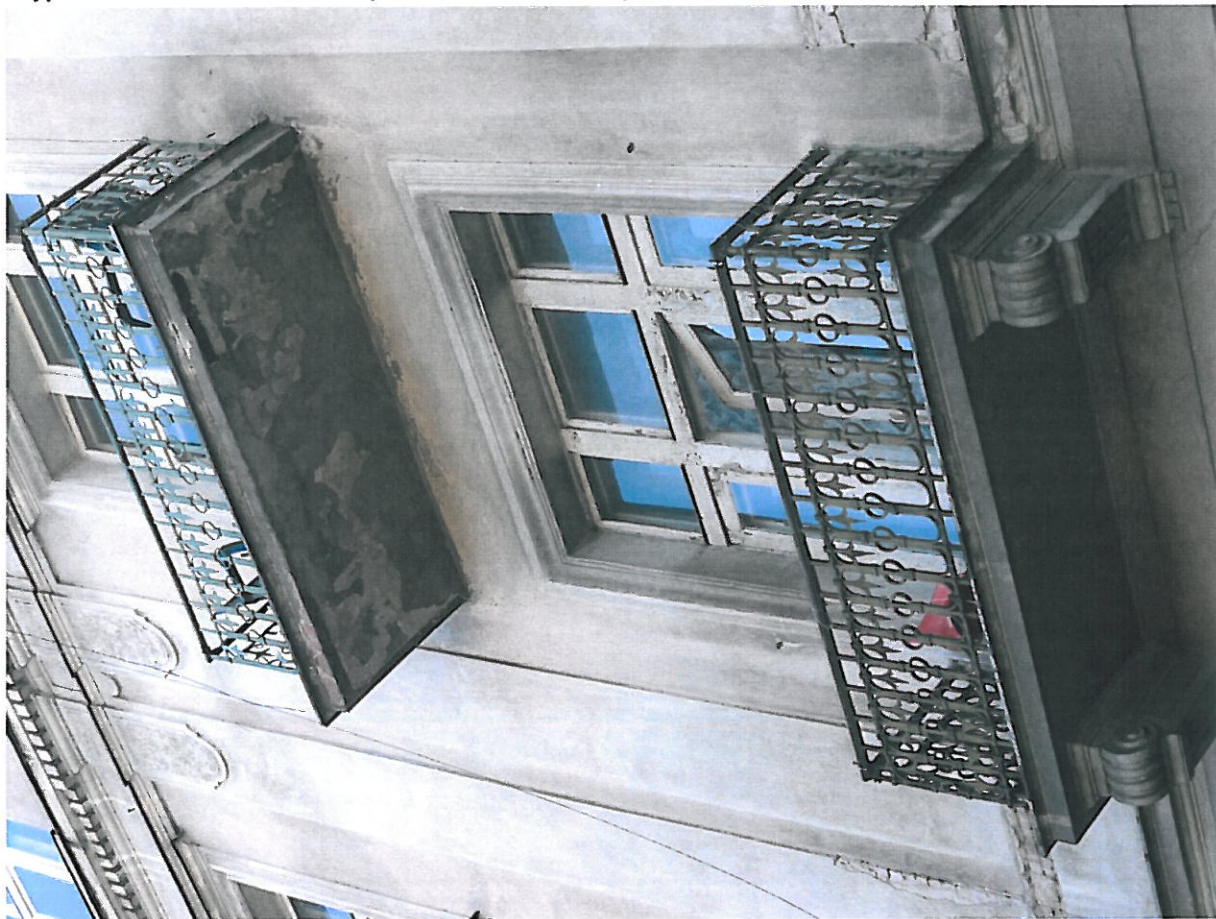
Zdjęcie 02. Uszkodzenia w obrębie balkonów elewacji frontowej
