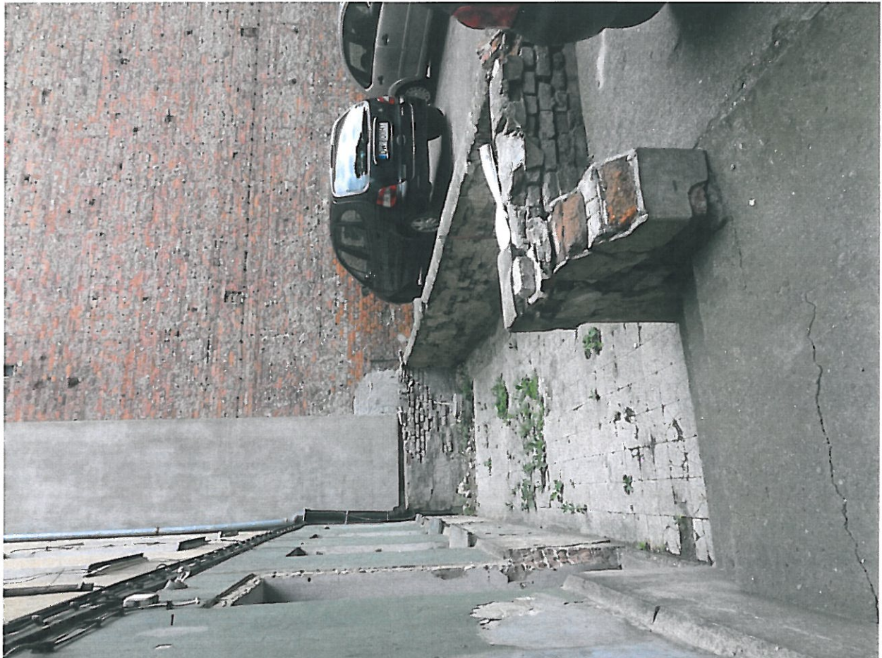
Zdjęcie 09 i 10. Uszkodzenia w obrębie murku oporowego i posadzki przy tylnej elewacji
