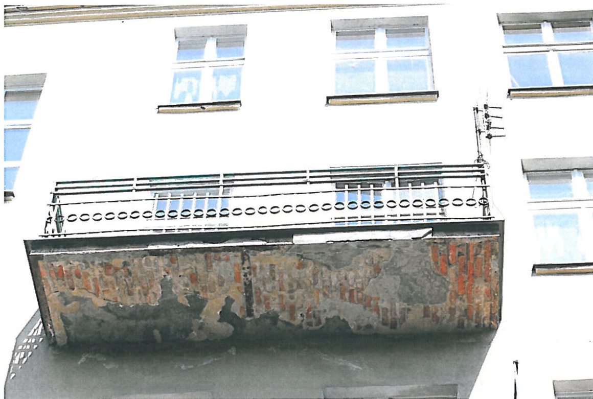
Fot. 15 – Balkon nr 4 – widok – płyta ciężka Kleina
