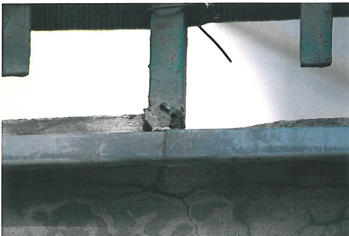
Fot. 8 – Detal mocowania balustrady – widoczna silna korozja
