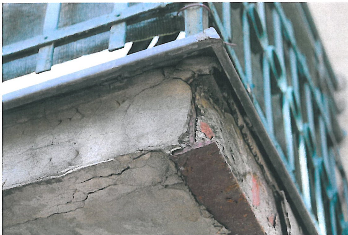
Fot. 7 – Detal oparcia belki z drugiej strony – zdeformowana belka wspornika
