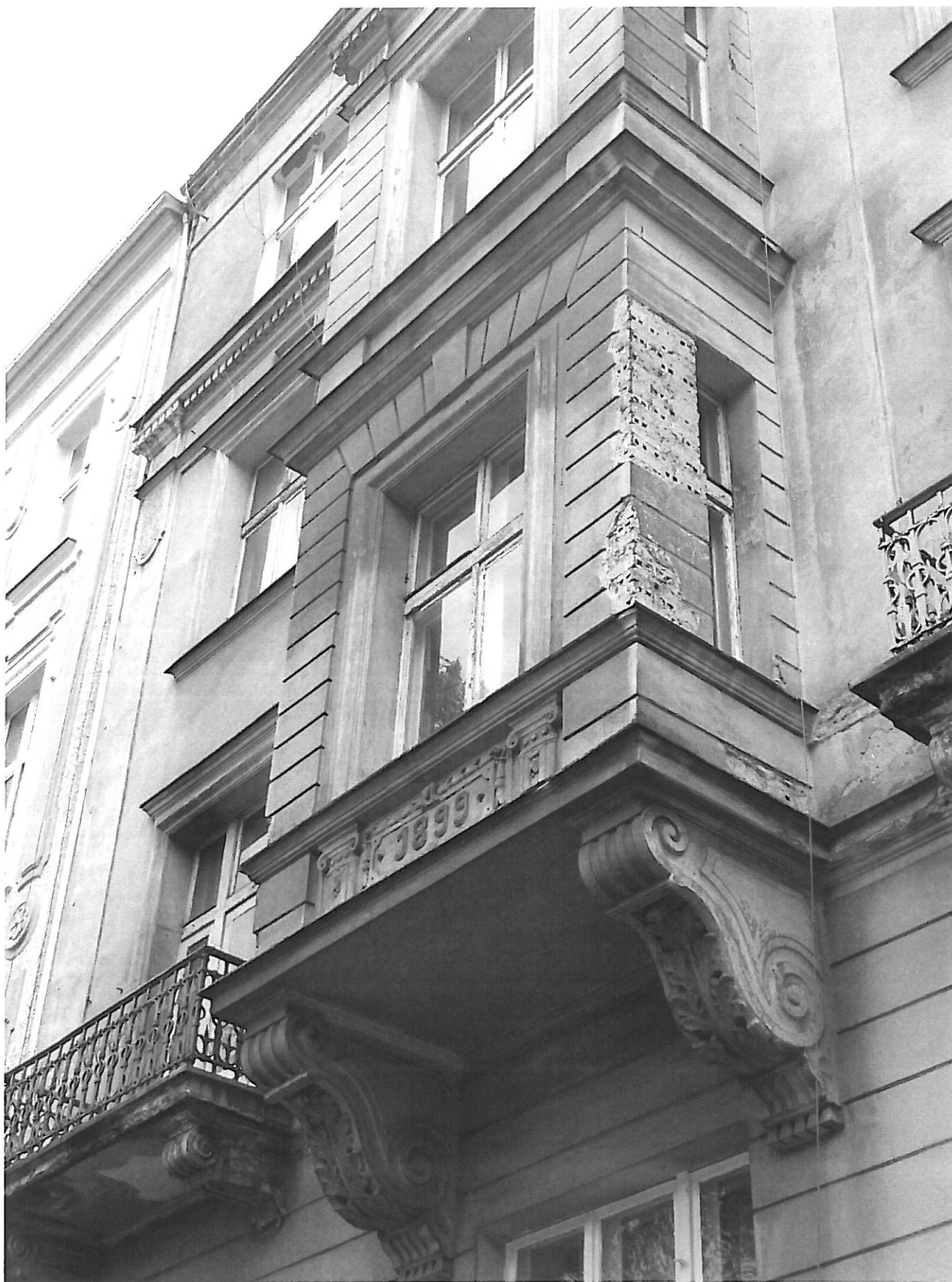
Zdjęcie 04. Uszkodzenia w obrębie balkonów i wykuszy elewacji frontowej
