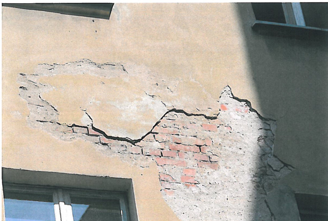
Fot. 27 – Elewacja tylna – odpadanie tynku
