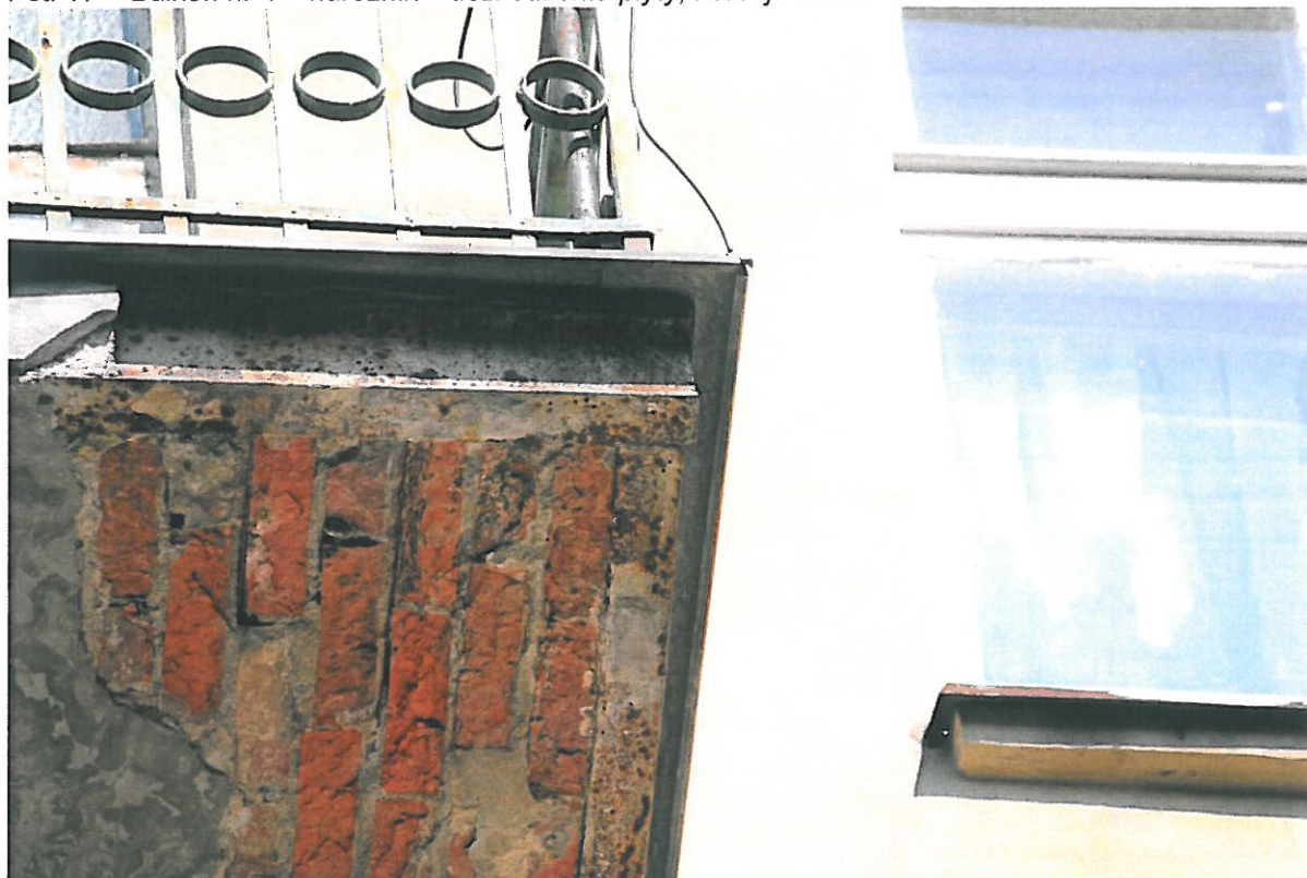
Fot. 17 – Balkon nr 4 – narożnik – uszkodzenia płyty, korozja belek
