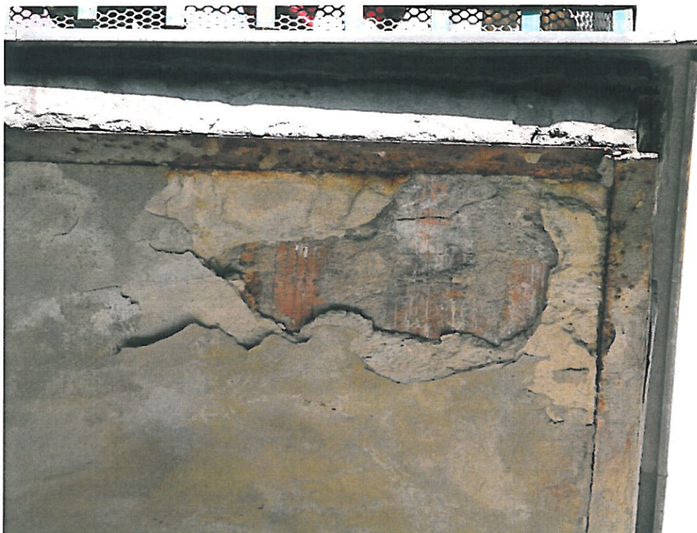
Fot. 14 – Balkon nr 3 – deformacja węzła
