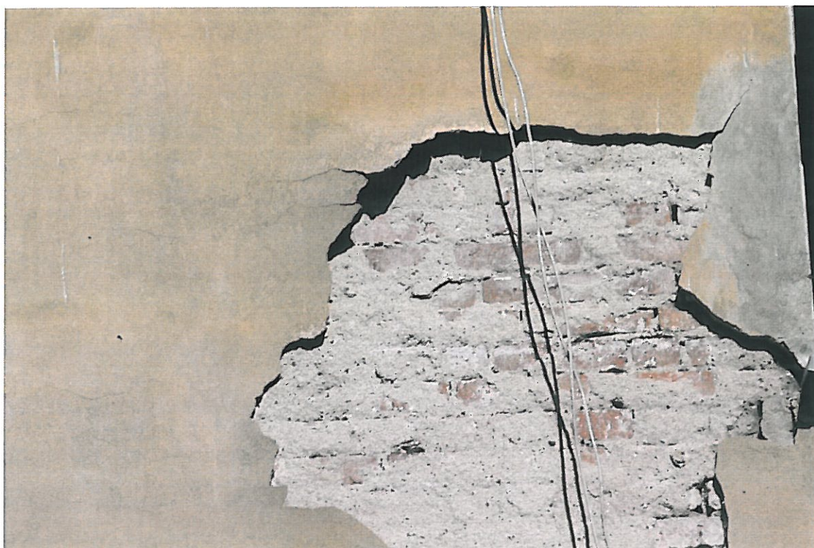
Fot. 26 – Odpadanie tynku na elewacji tylnej – przy sąsiedzie
