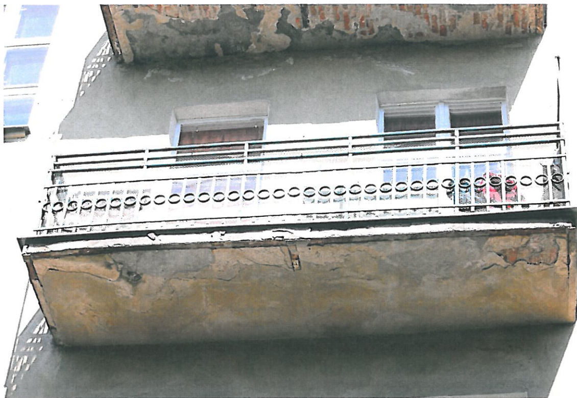
Fot. 13 – Balkon nr 3 – widok – deformacja belki wzdłużnej i balustrady
