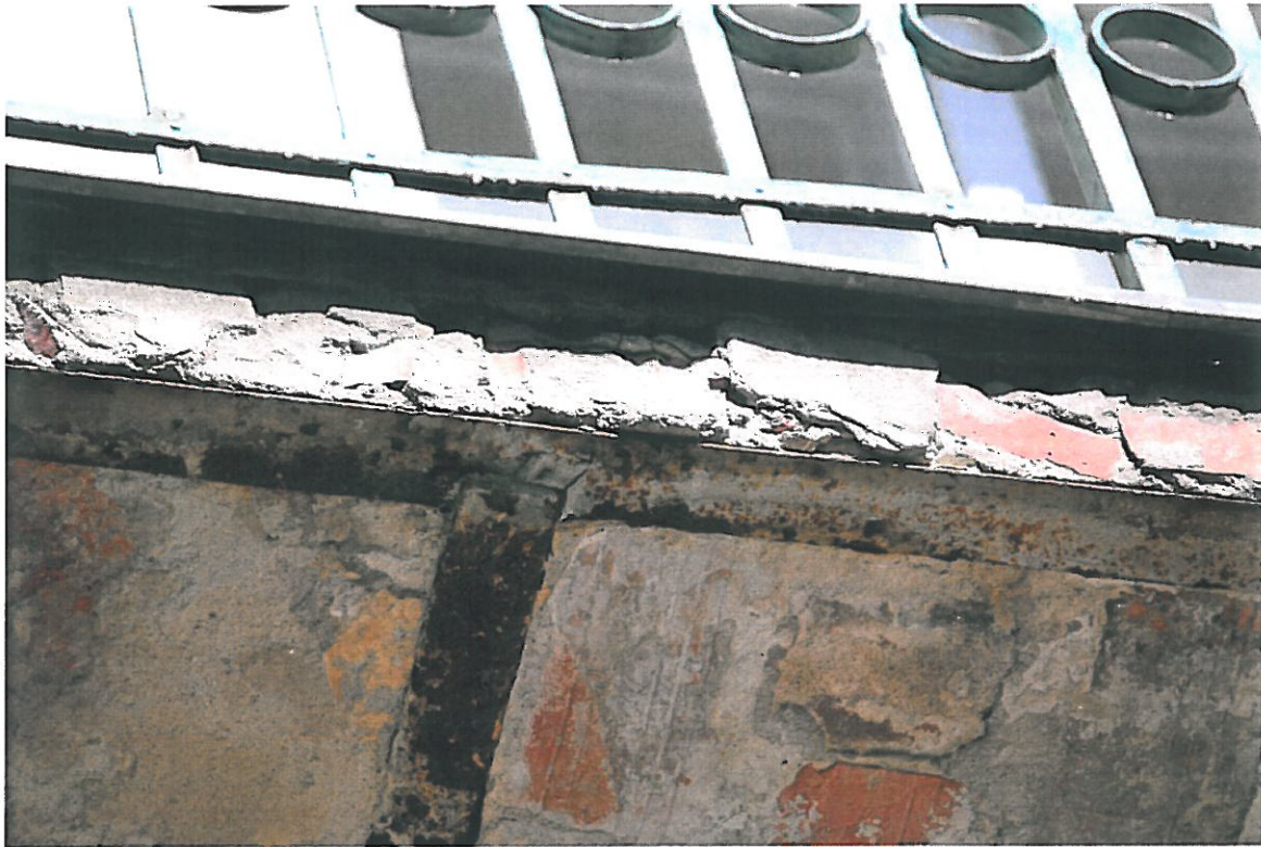
Fot. 21 – Balkon nr 6 - Węzeł środkowy, oparcie belki wzdłużnej na wsporniku środkowym
