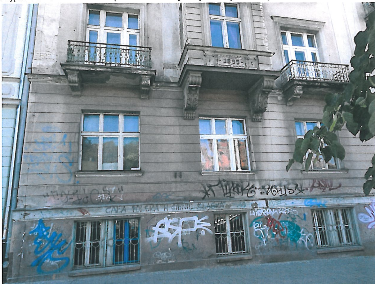
Zdjęcie 06. Uszkodzenia w obrębie tynku
