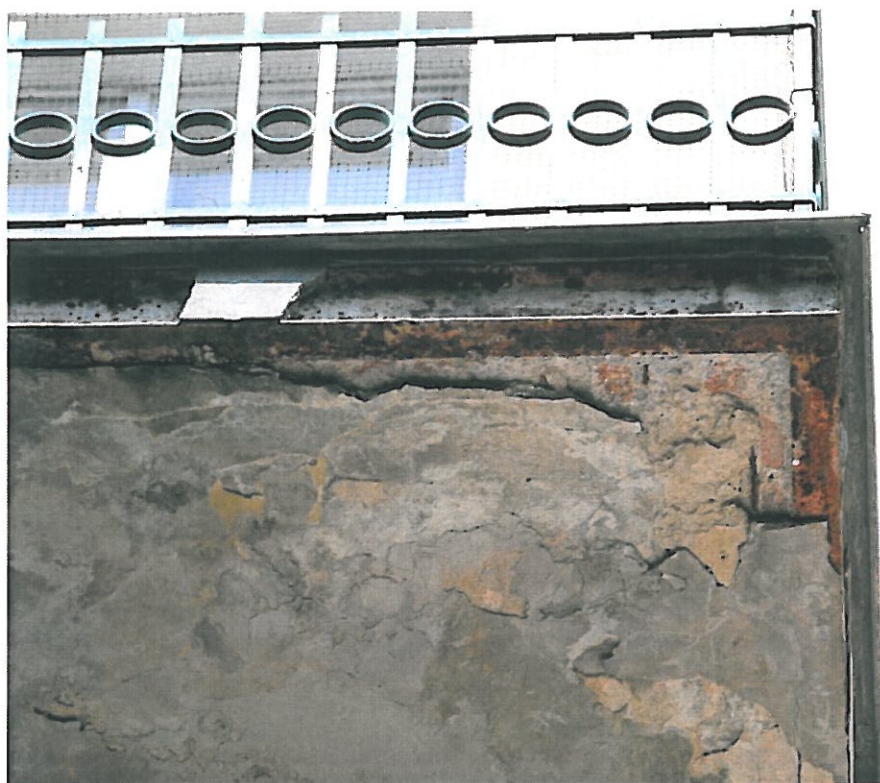
Fot. 25 – Balkon nr 8 – korozja belek, odpadanie tynku
