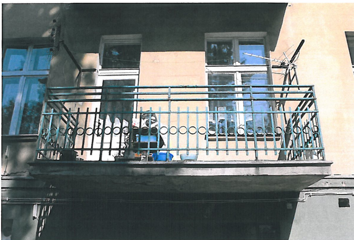
Fot. 18 – Balkon nr 5 – widok ogólny, widoczne wygięcie
