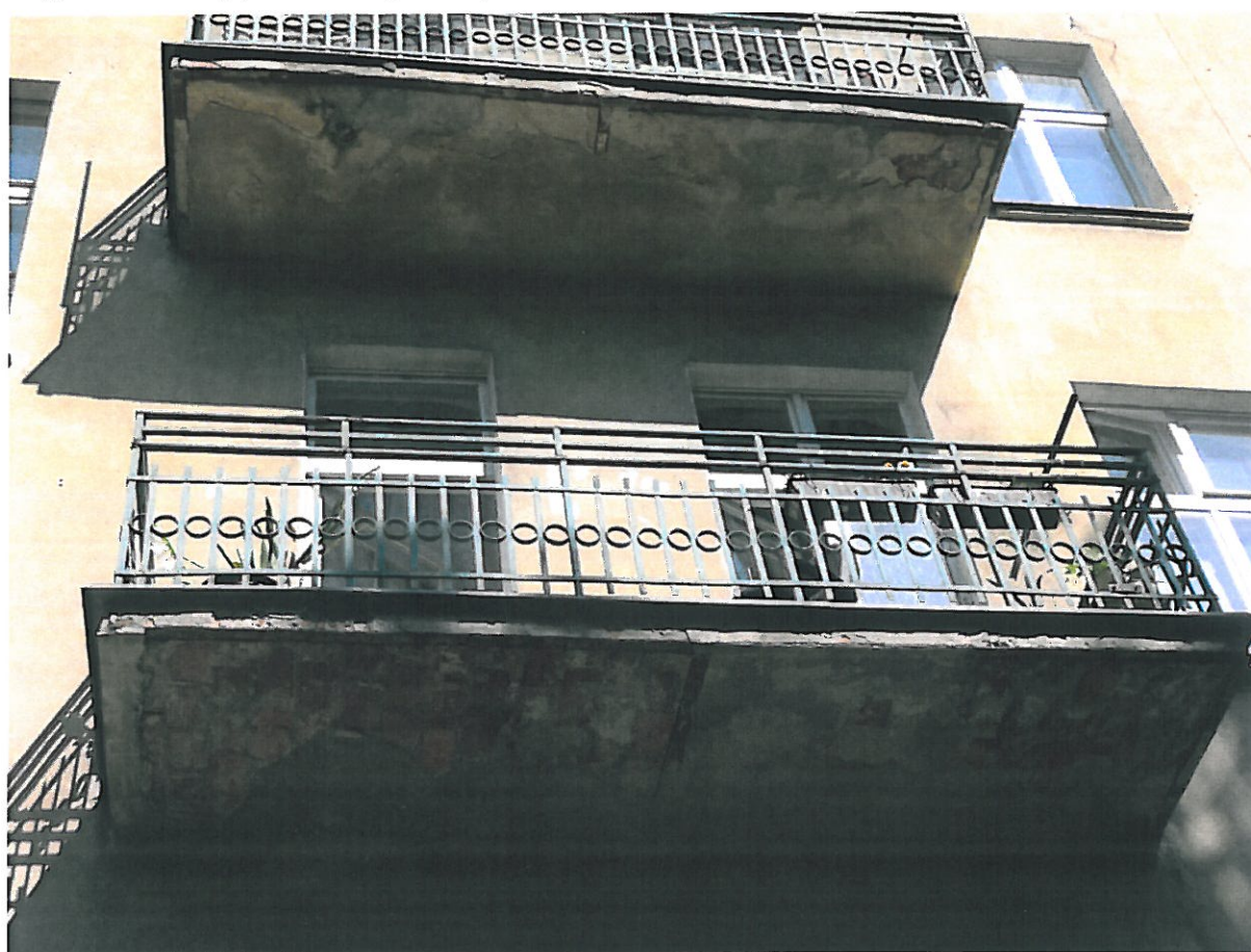
Zdjęcie 17. Stan płyt balkonowych na tylnej elewacji.
