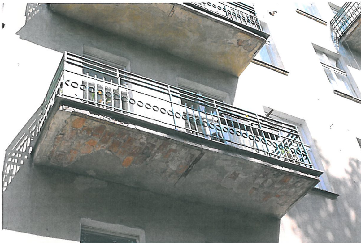
Fot. 10 – Balkon 2 – deformacja liniowa belki wzdłużnej - widok
