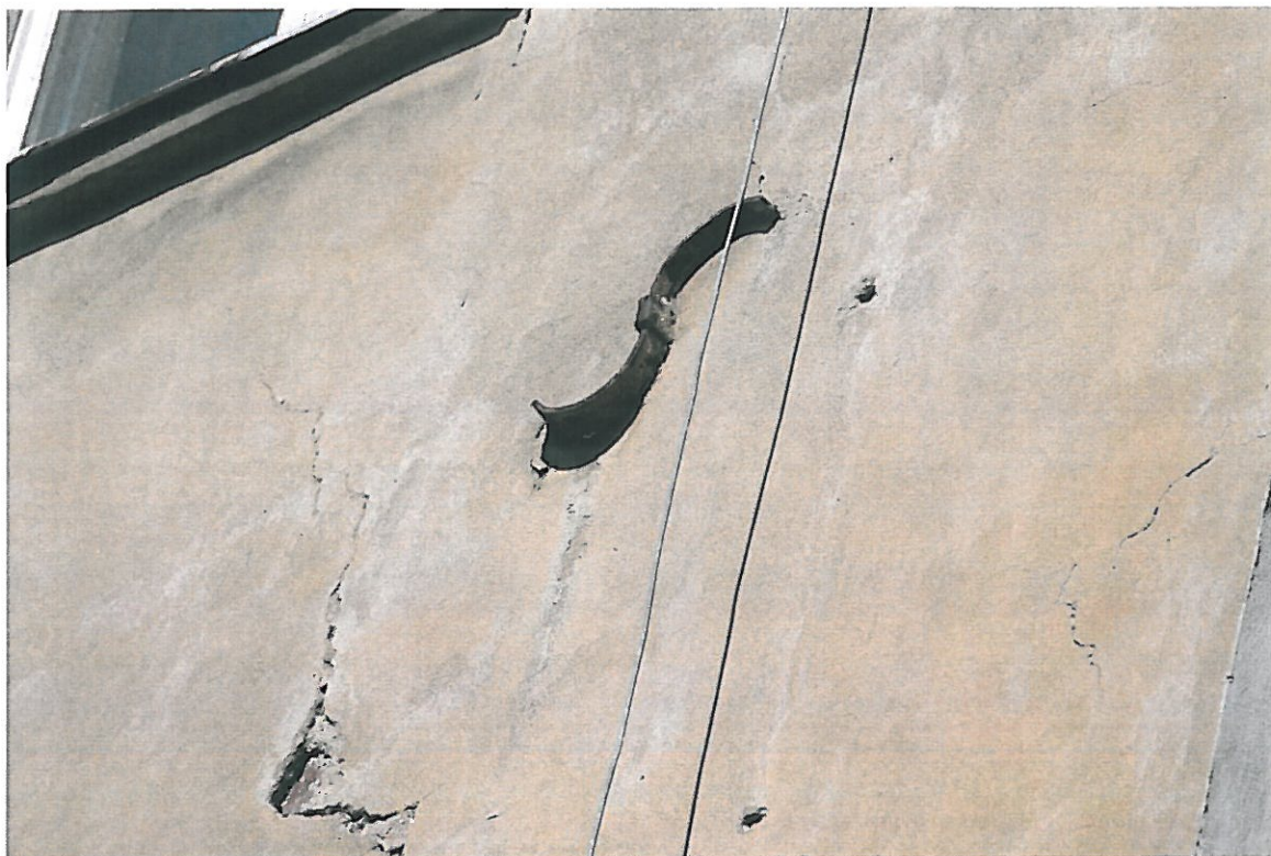
Fot. 29 – Elewacja tylna – Kotew do stropu, zarysowanie muru
