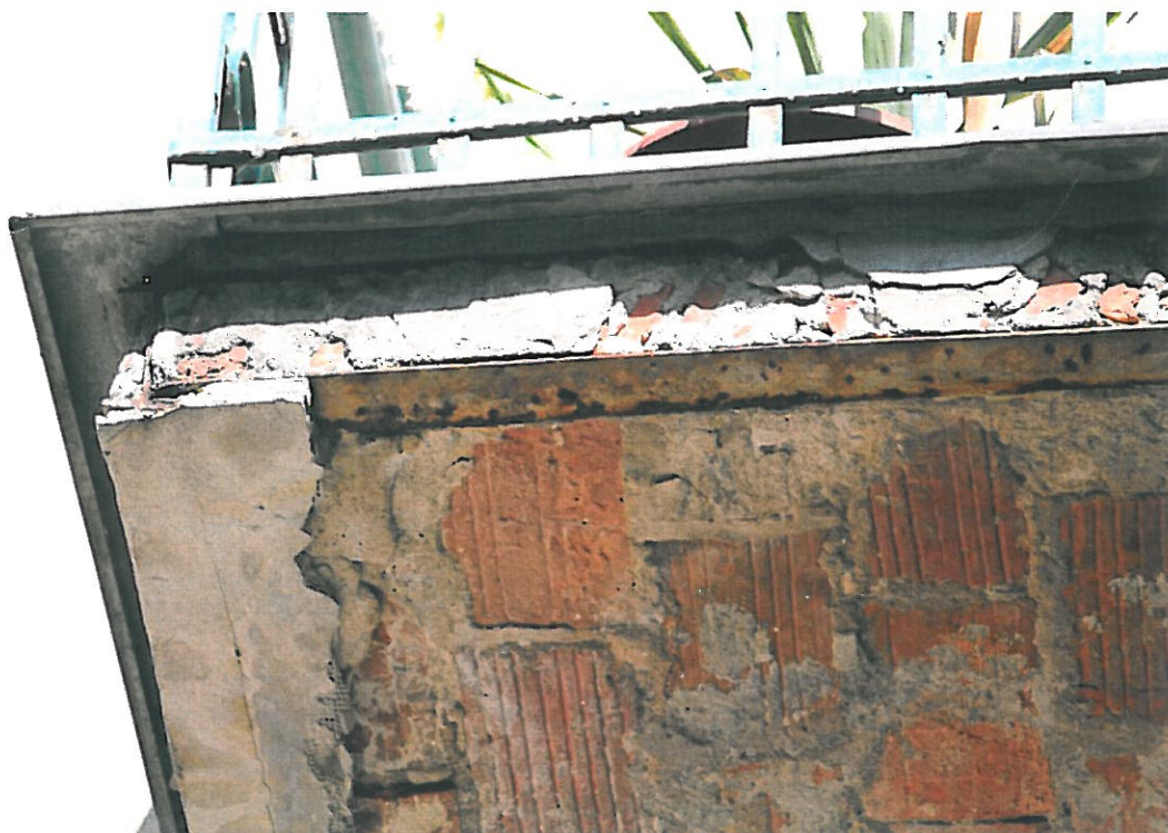
Fot. 11 - Balkon nr 2 – obrót belki wspornikowej, korozja, uszkodzenia płyty Kleina
