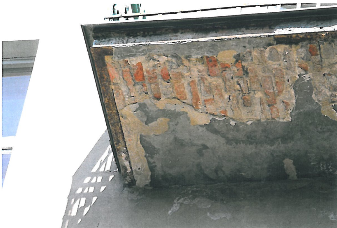
Fot. 16 – Balkon nr 4 – korozja belek stalowych
