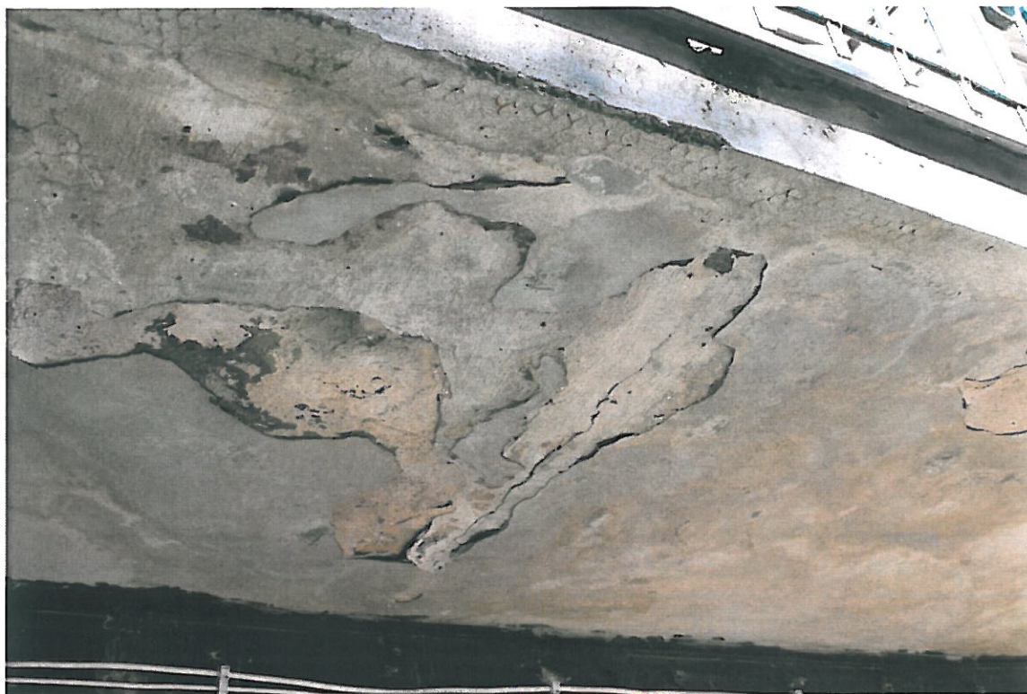
Fot. 19 – Balkon nr 5 – spuchnięty i odpadający tynk od spodu
