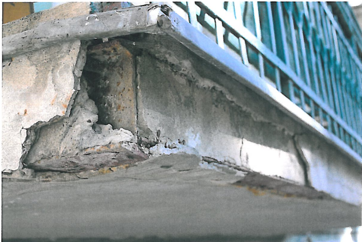
Fot. 6 – Balkon nr 1 – narożnik – deformacja wspornika, oparcie belki podłużnej na belce wspornikowej
