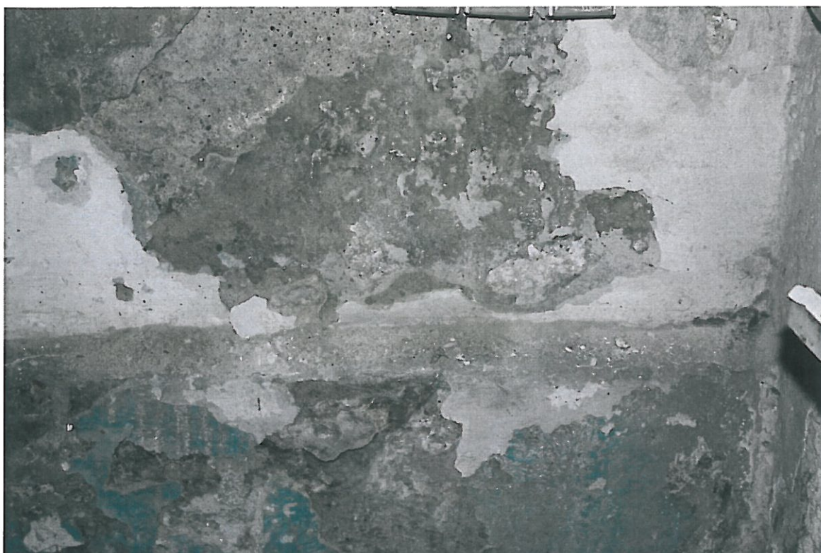
Fot. 41 – Kotłownia – zamoczone ściany, ubytki tynków
