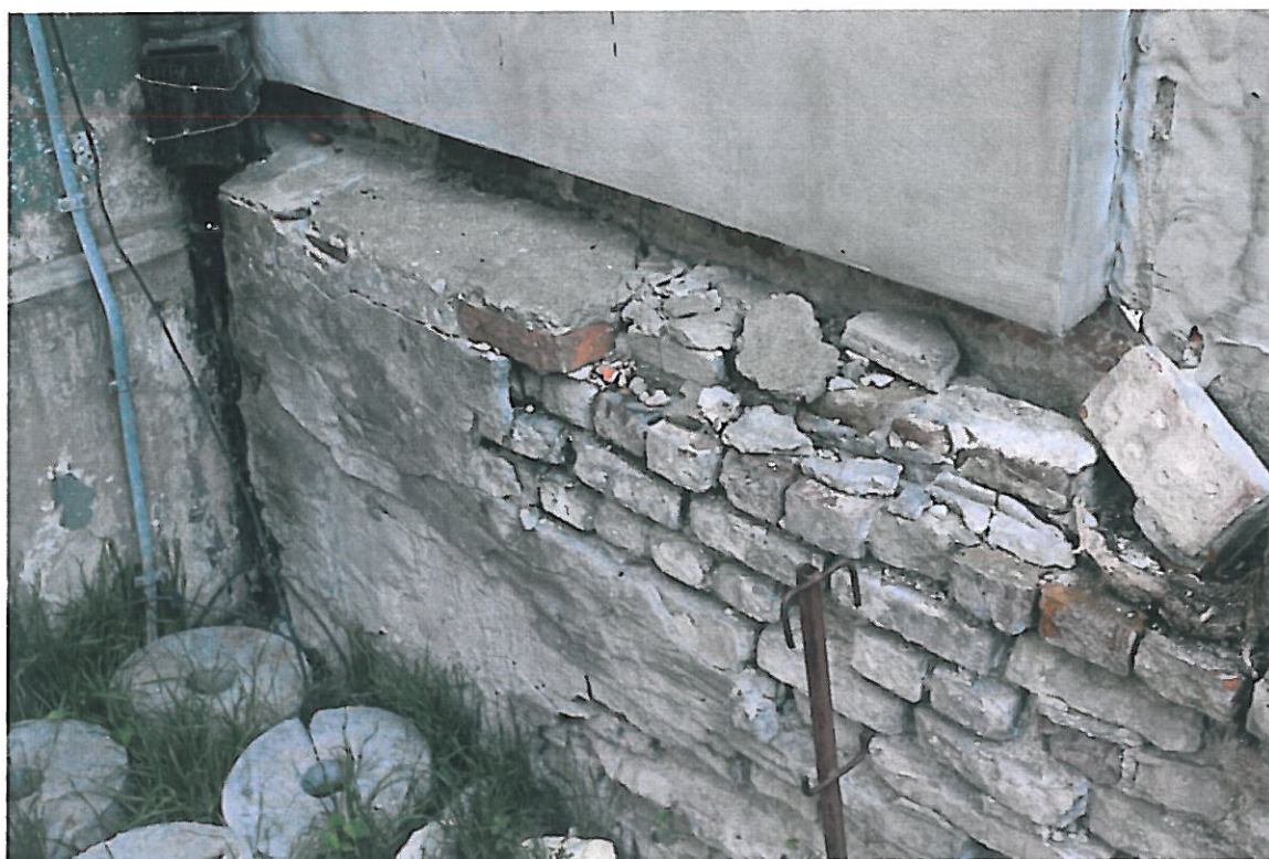
Fot. 34 – Obniżenie terenu – murek na styku ze ścianą szczytową sąsiada
