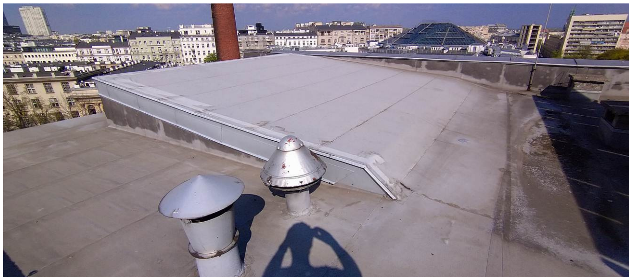
Nadbudówka maszynowni windy przy wschodnim skraju budynku.
