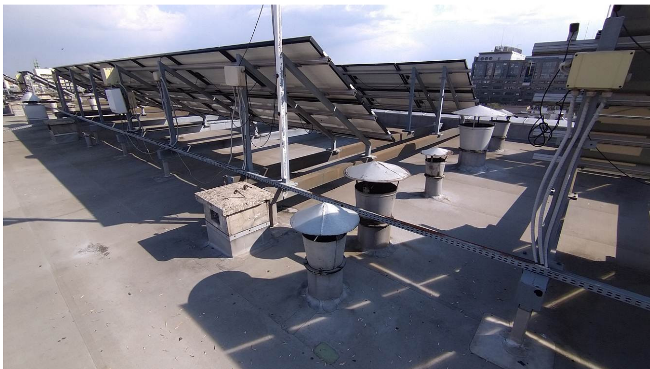
Panele fotowoltaiczne i wyrzutnie wentylacji mechanicznej.
