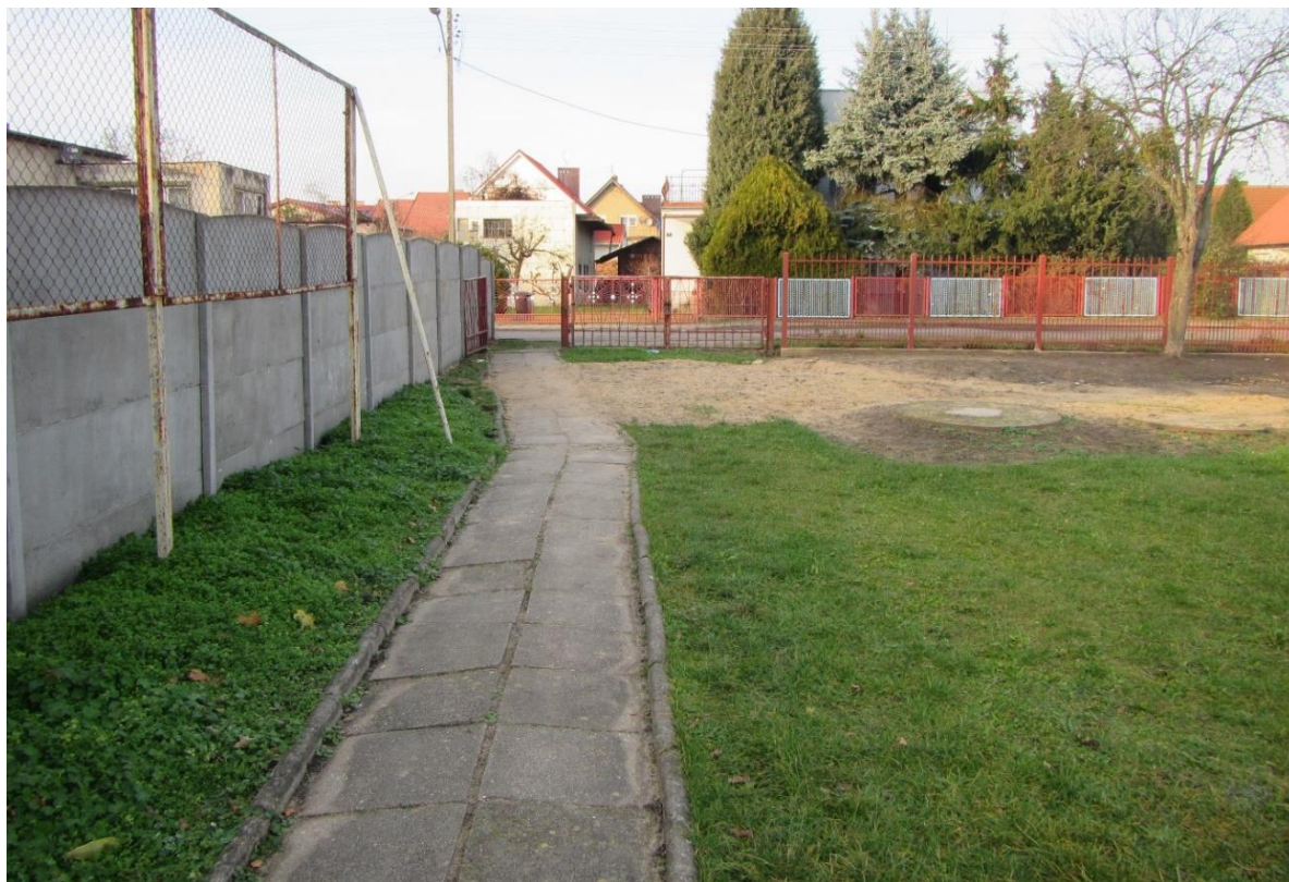
Istniejący wjazd techniczny, nawierzchnia utwardzona z płyt chodnikowych
