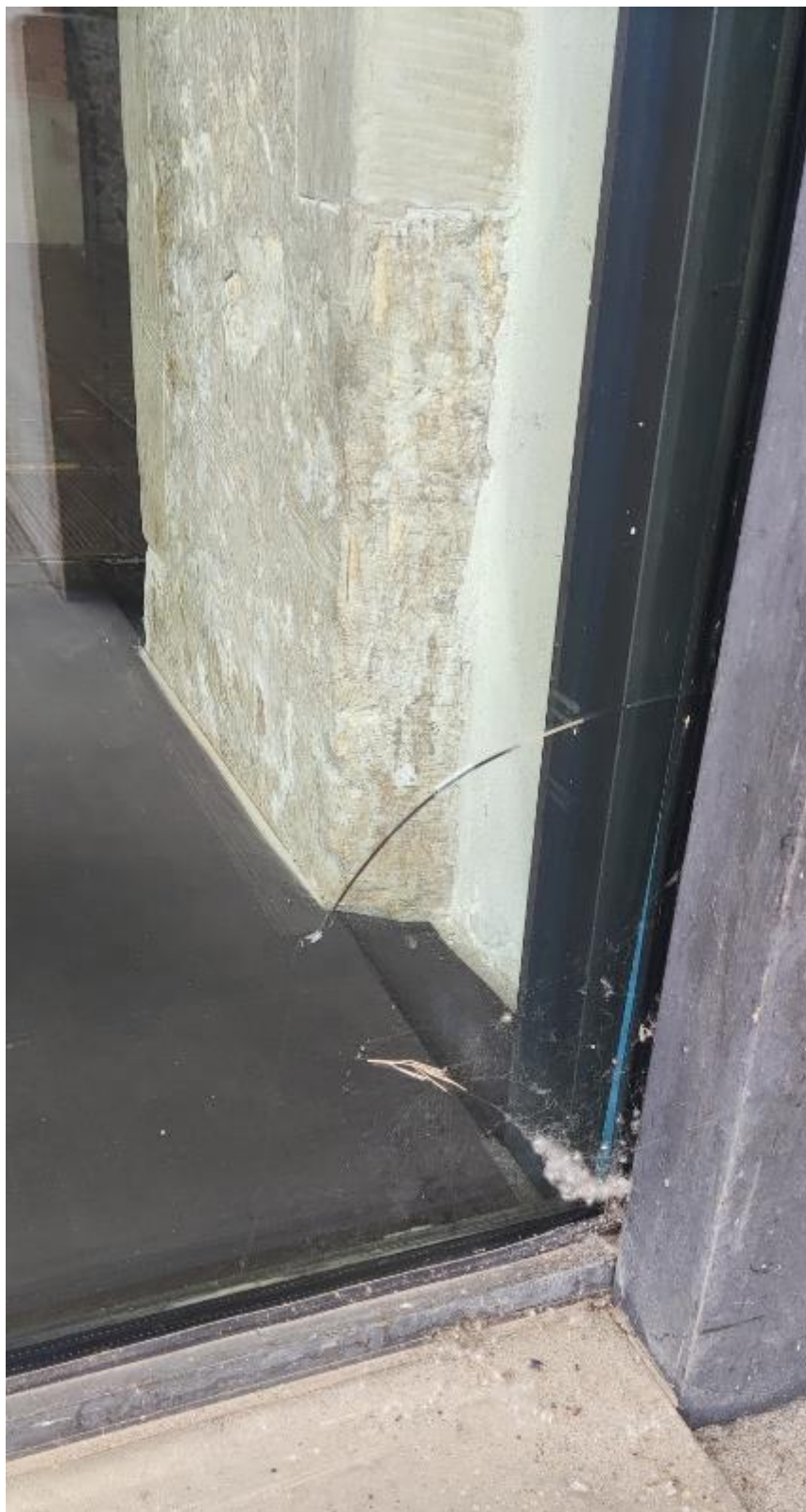
fot. 2arkada A16, szyba G-A16-6 - pęknięcie
