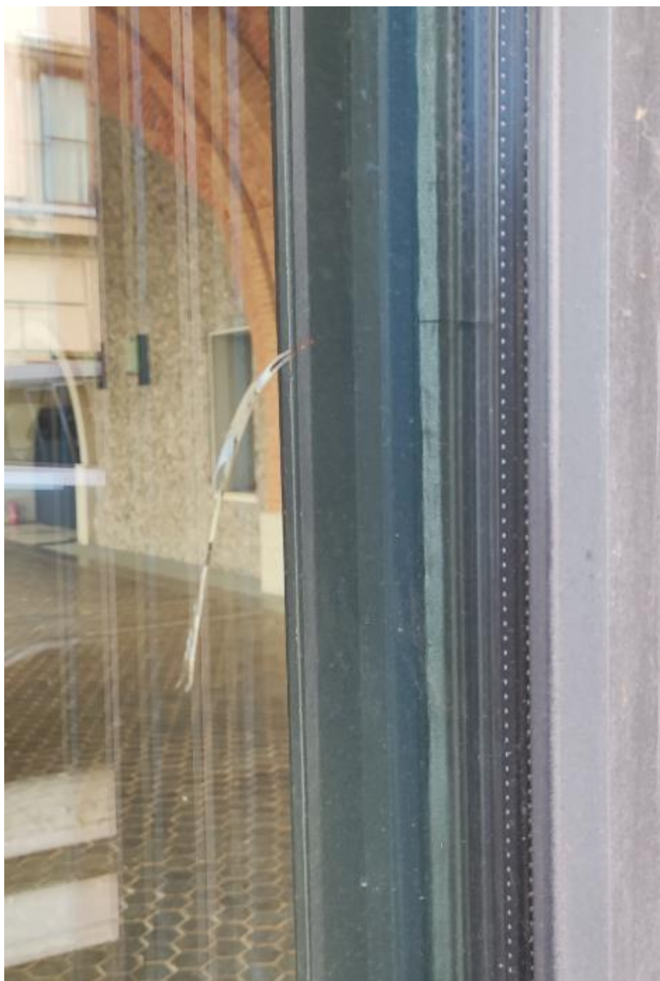
fot. 5 arkada A17, szyba G1.1-A17 pęknięcie
