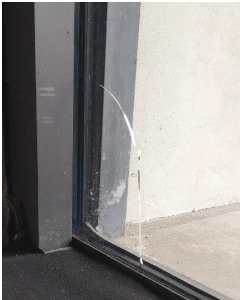
fot. 3arkada A16, szyba G-A16-6 - pęknięcie
