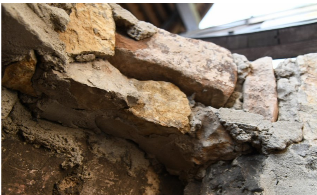
Fot. 118 Chęciny – Zamek Królewski Wieża zachodnia, łuk nad wejściem Stan przed konserwacją Fot. Marek Mazurek 2024
