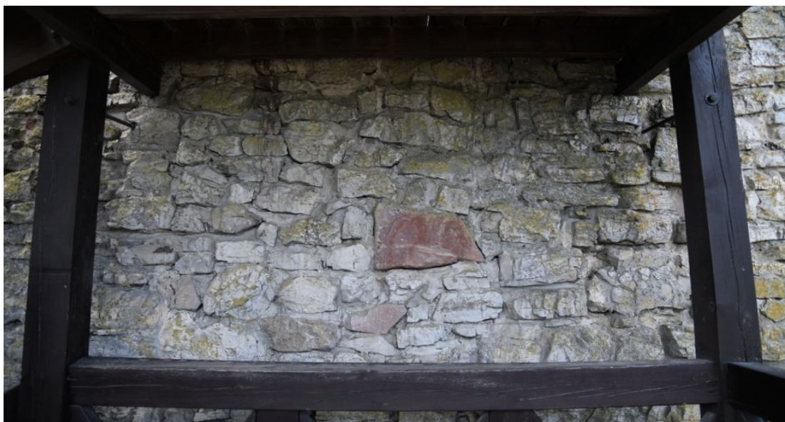
Fot. 75 Chęciny – Zamek Królewski Mur obwodowy zachodni, wewnętrzny Stan przed konserwacją Fot. Marek Mazurek 2024
