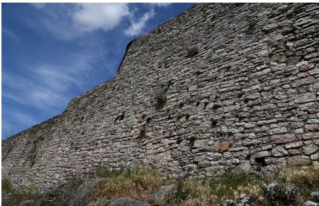
Fot. 9 Chęciny – Zamek Królewski Mur obwodowy południowy, zewnętrzny Stan przed konserwacją Fot. Marek Mazurek 2024
