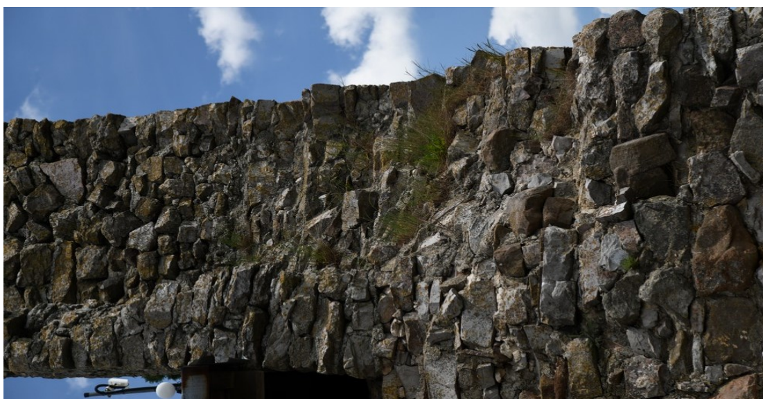
Fot. 98 Chęciny – Zamek Królewski Skarbiec, wejście Stan przed konserwacją Fot. Marek Mazurek 2024
