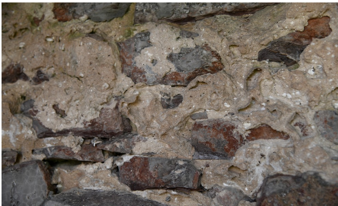
Fot. 80 Chęciny – Zamek Królewski Mur obwodowy zachodni, wewnętrzny Stan przed konserwacją Fot. Marek Mazurek 2024
