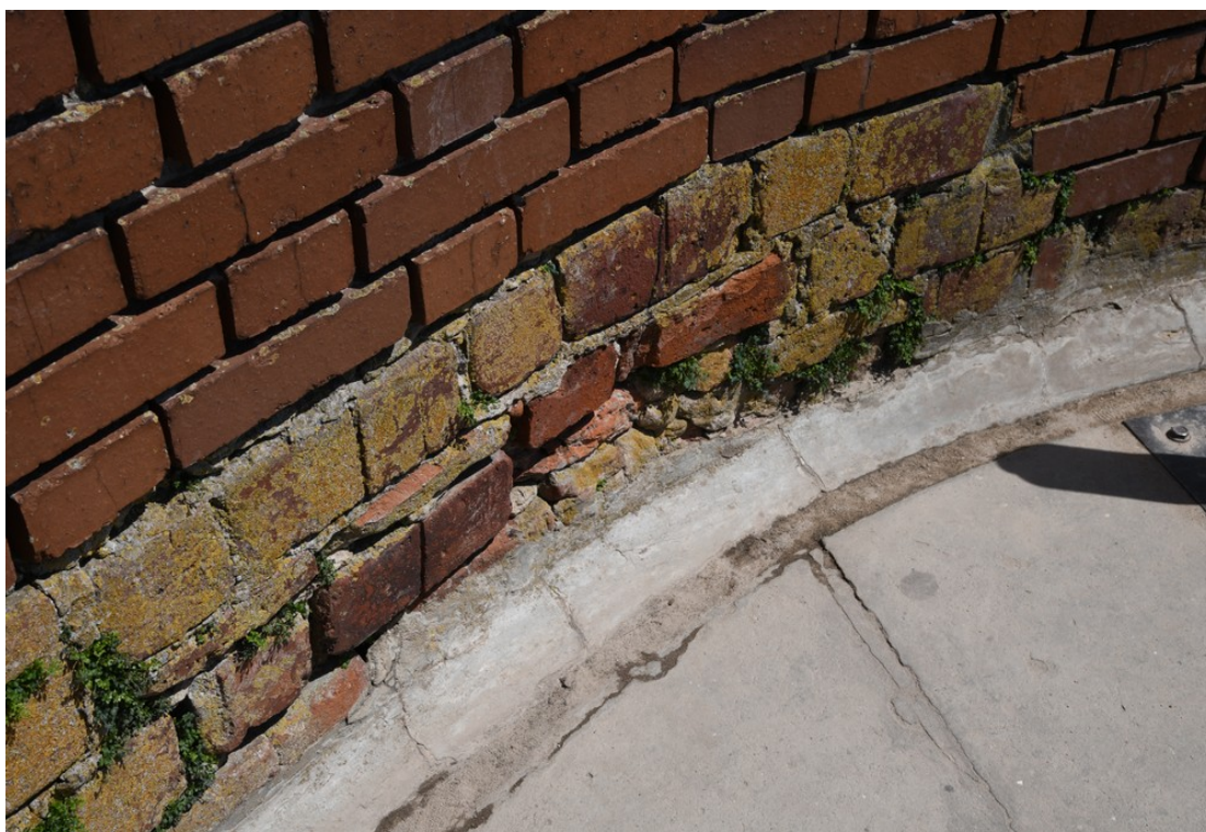
Fot. 159 Chęciny – Zamek Królewski Wieża wschodnia, podest górny Stan przed konserwacją Fot. Marek Mazurek 2024
