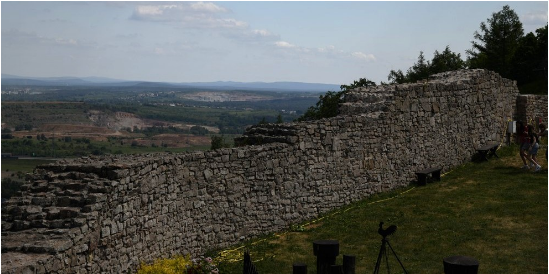
Fot. 55 Chęciny – Zamek Królewski Mur obwodowy północny, wewnętrzny Stan przed konserwacją Fot. Marek Mazurek 2024
