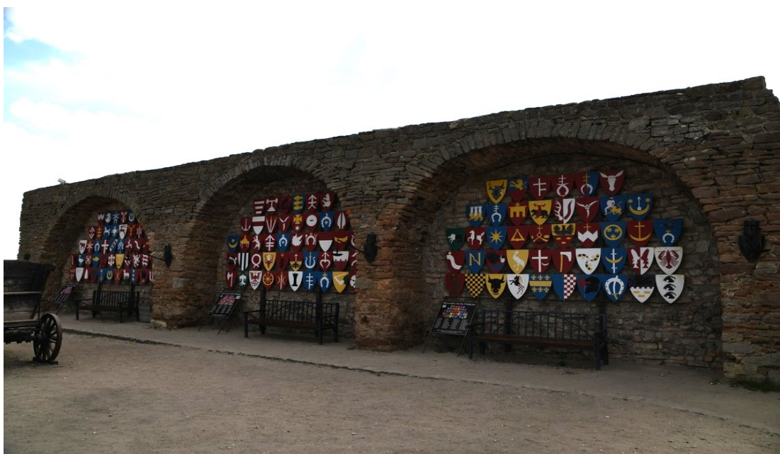
Fot. 93 Chęciny – Zamek Królewski Arkady Stan przed konserwacją Fot. Marek Mazurek 2024
