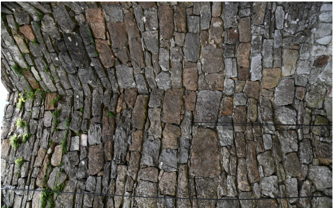
Fot. 24 Chęciny – Zamek Królewski Mur obwodowy południowy, wewnętrzny Stan przed konserwacją Fot. Marek Mazurek 2024
