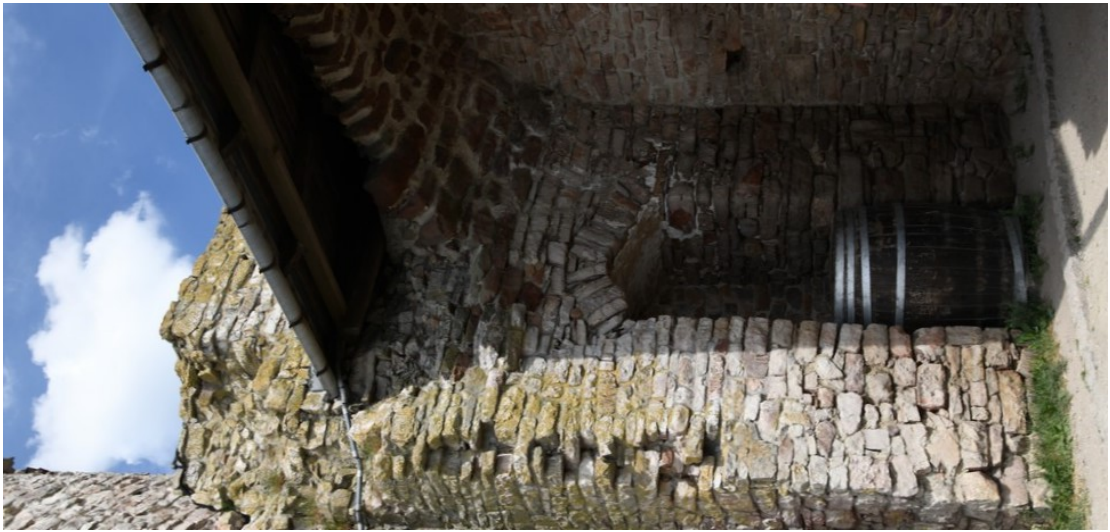
Fot. 99 Chęciny – Zamek Królewski Skarbiec, wejście Stan przed konserwacją Fot. Marek Mazurek 2024
