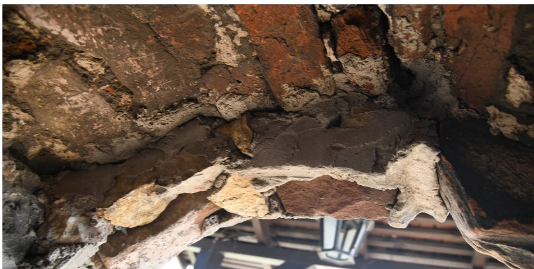
Fot. 117 Chęciny – Zamek Królewski Wieża zachodnia, łuk nad wejściem Stan przed konserwacją Fot. Marek Mazurek 2024
