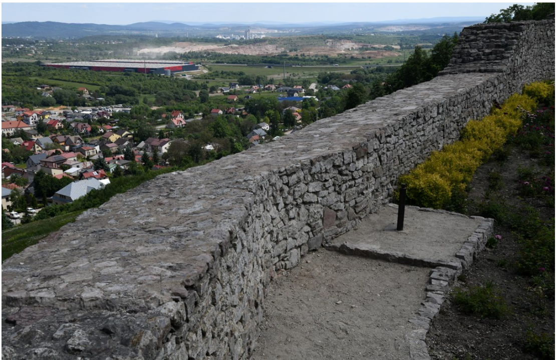
Fot. 56 Chęciny – Zamek Królewski Mur obwodowy północny, wewnętrzny Stan przed konserwacją Fot. Marek Mazurek 2024
