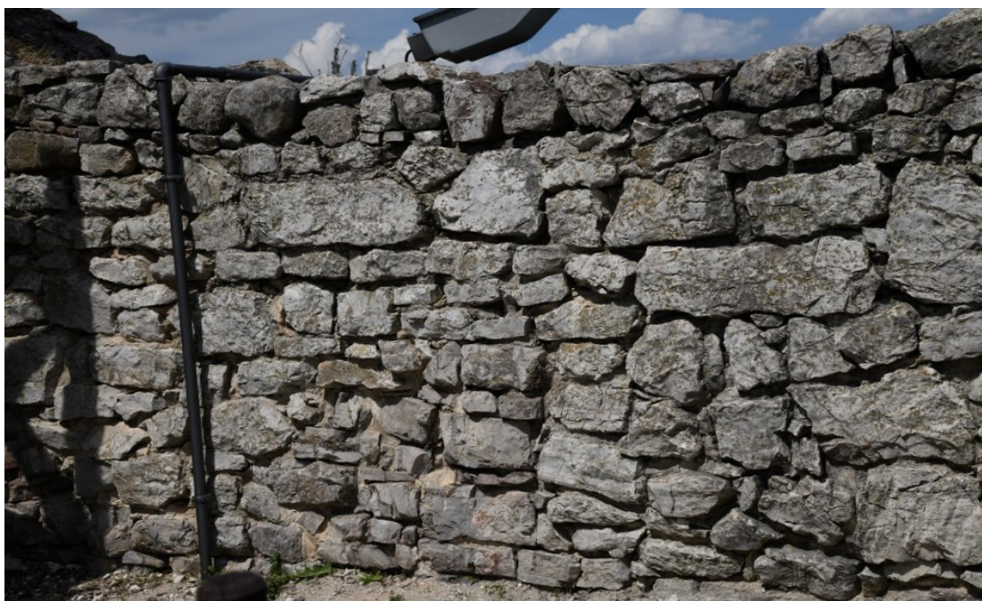
Fot. 66 Chęciny – Zamek Królewski Mur obwodowy północny, wewnętrzny Stan przed konserwacją Fot. Marek Mazurek 2024
