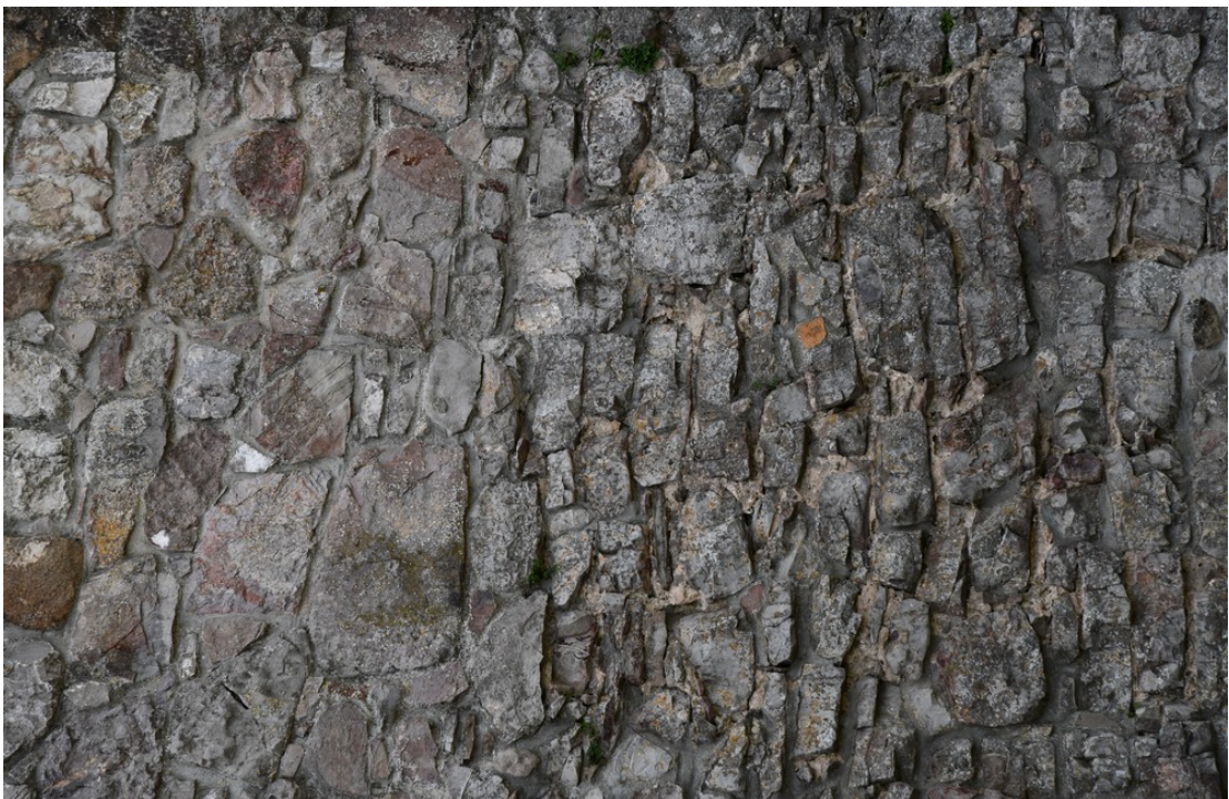
Fot. 22 Chęciny – Zamek Królewski Mur obwodowy południowy, wewnętrzny Stan przed konserwacją Fot. Marek Mazurek 2024
