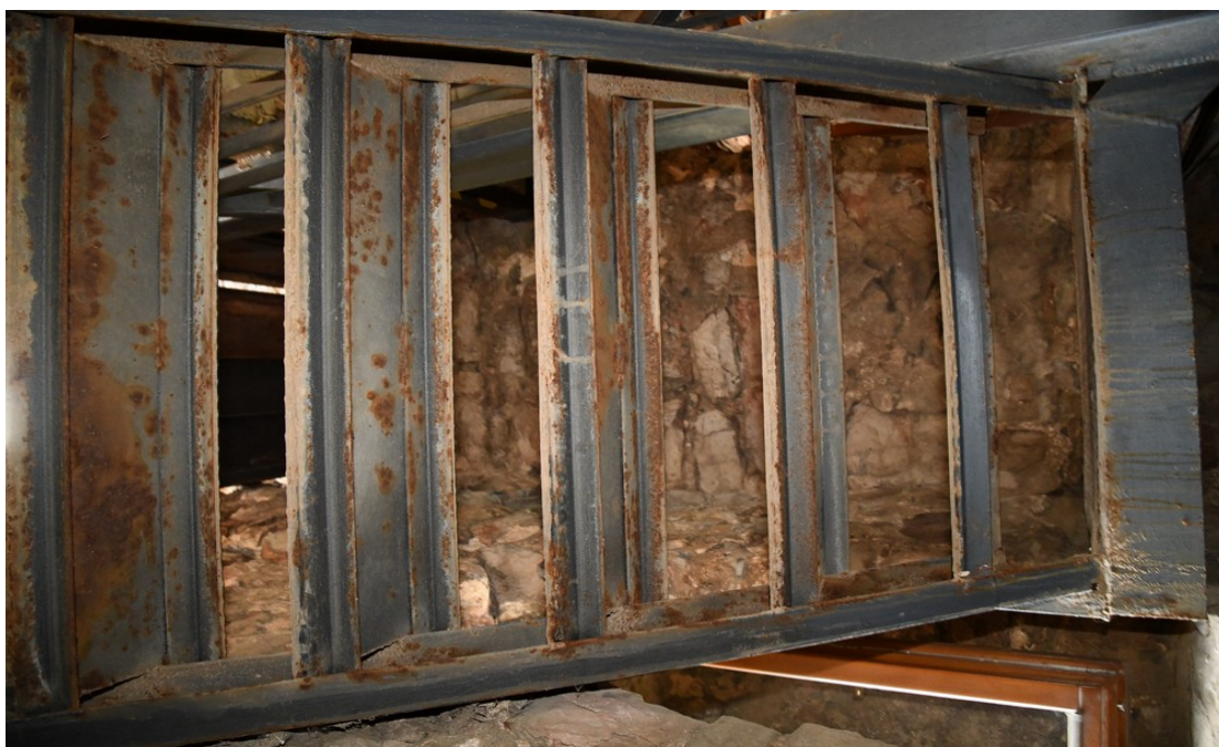
Fot. 129 Chęciny – Zamek Królewski Wieża zachodnia, stalowe schody Stan przed konserwacją Fot. Marek Mazurek 2024
