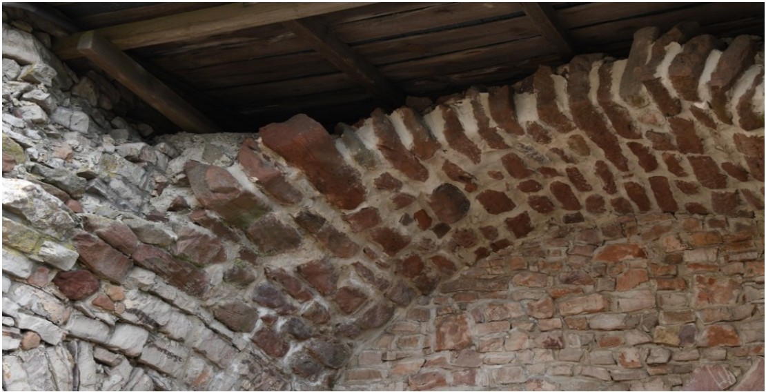
Fot. 101 Chęciny – Zamek Królewski Skarbiec, wejście Stan przed konserwacją Fot. Marek Mazurek 2024
