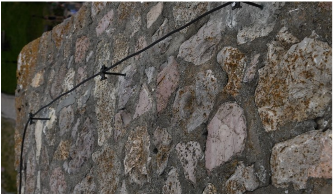
Fot. 120 Chęciny – Zamek Królewski Wieża zachodnia, korona Stan przed konserwacją Fot. Marek Mazurek 2024
