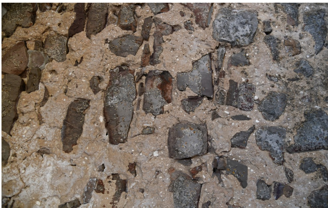
Fot. 79 Chęciny – Zamek Królewski Mur obwodowy zachodni, wewnętrzny Stan przed konserwacją Fot. Marek Mazurek 2024
