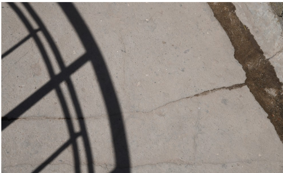
Fot. 160 Chęciny – Zamek Królewski Wieża wschodnia, podest górny Stan przed konserwacją Fot. Marek Mazurek 2024
