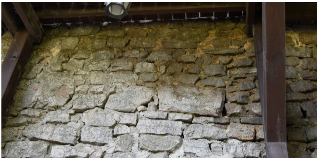
Fot. 76 Chęciny – Zamek Królewski Mur obwodowy zachodni, wewnętrzny Stan przed konserwacją Fot. Marek Mazurek 2024
