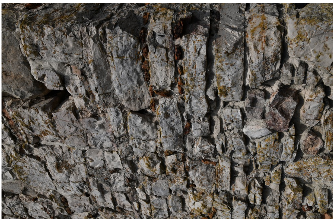
Fot. 65 Chęciny – Zamek Królewski Mur obwodowy północny, wewnętrzny Stan przed konserwacją Fot. Marek Mazurek 2024
