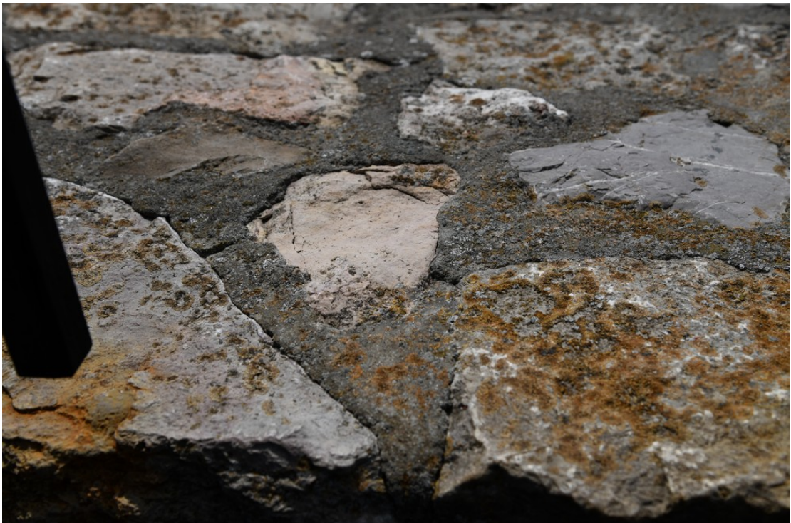
Fot. 119 Chęciny – Zamek Królewski Wieża zachodnia, korona Stan przed konserwacją Fot. Marek Mazurek 2024
