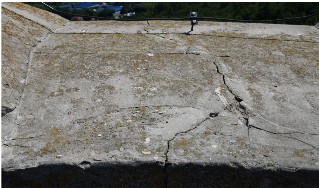
Fot. 162 Chęciny – Zamek Królewski Wieża wschodnia, korona muru Stan przed konserwacją Fot. Marek Mazurek 2024
