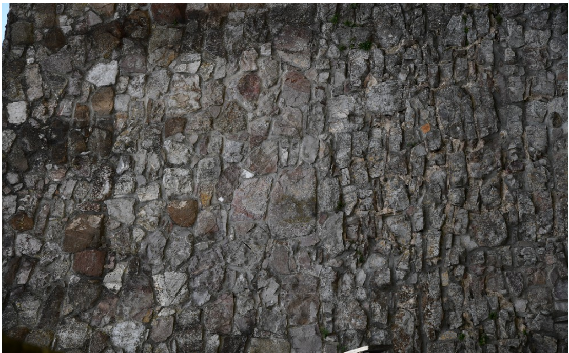
Fot. 21 Chęciny – Zamek Królewski Mur obwodowy południowy, wewnętrzny Stan przed konserwacją Fot. Marek Mazurek 2024
