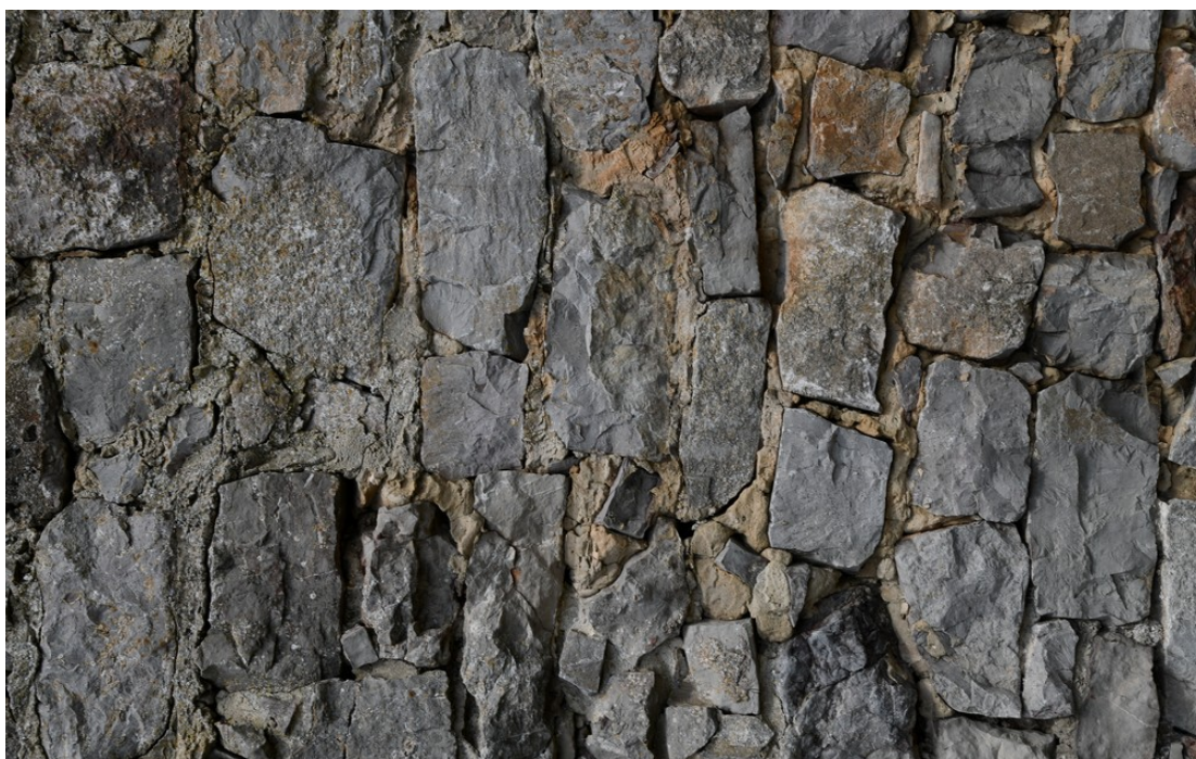
Fot. 67 Chęciny – Zamek Królewski Mur obwodowy północny, wewnętrzny Stan przed konserwacją Fot. Marek Mazurek 2024
