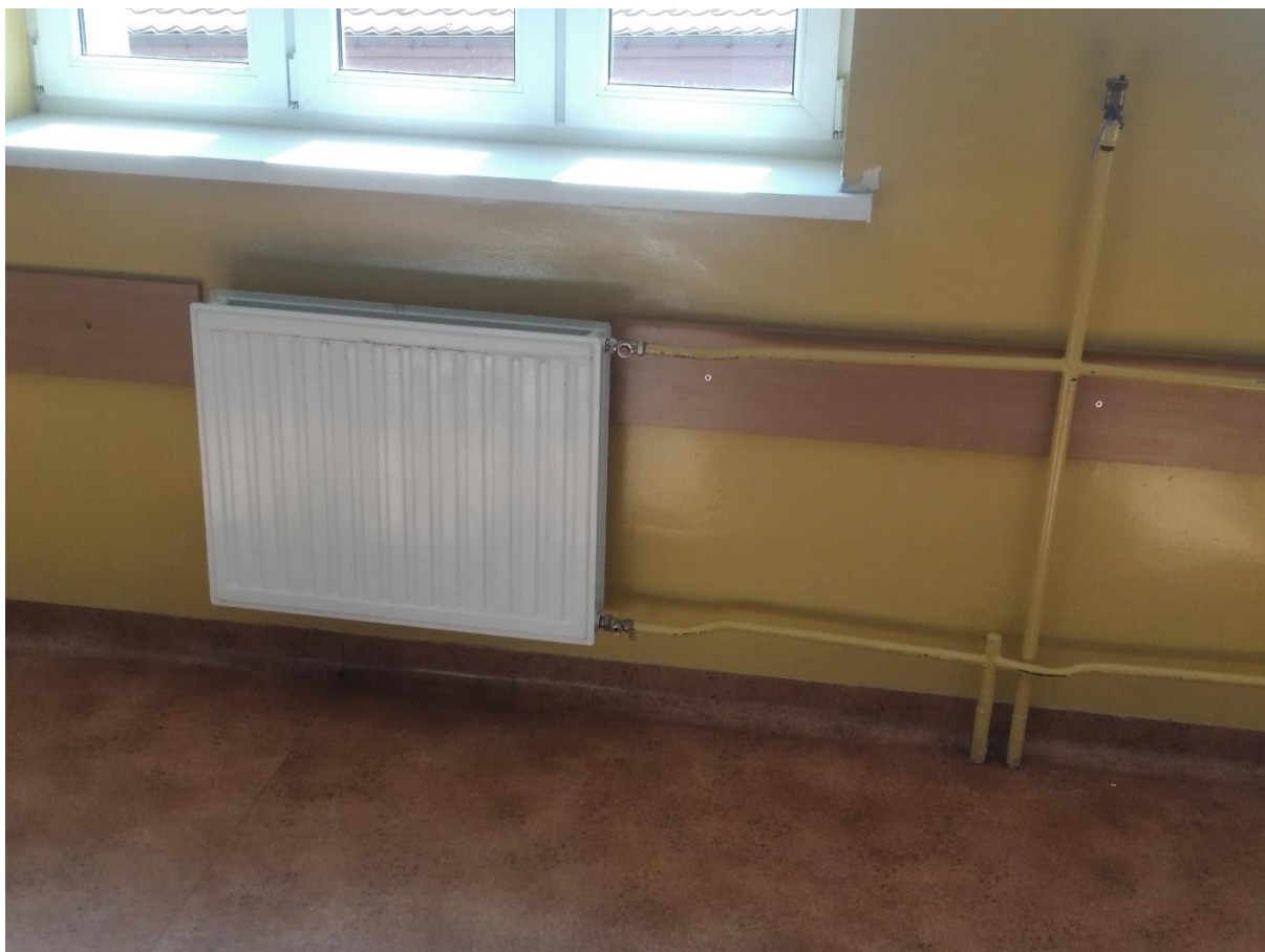
Rysunek 8. System dystrybucji w rozpatrywanym budynku
