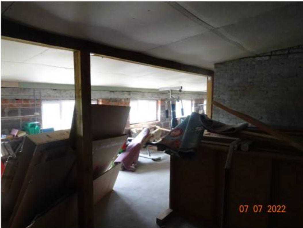
Fot. nr 5. Widok poddasza.
