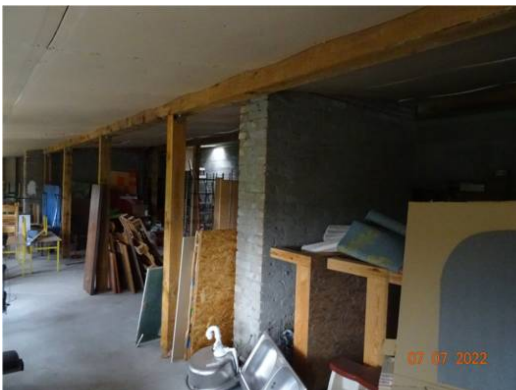
Fot. nr 2. Widok poddasza.
