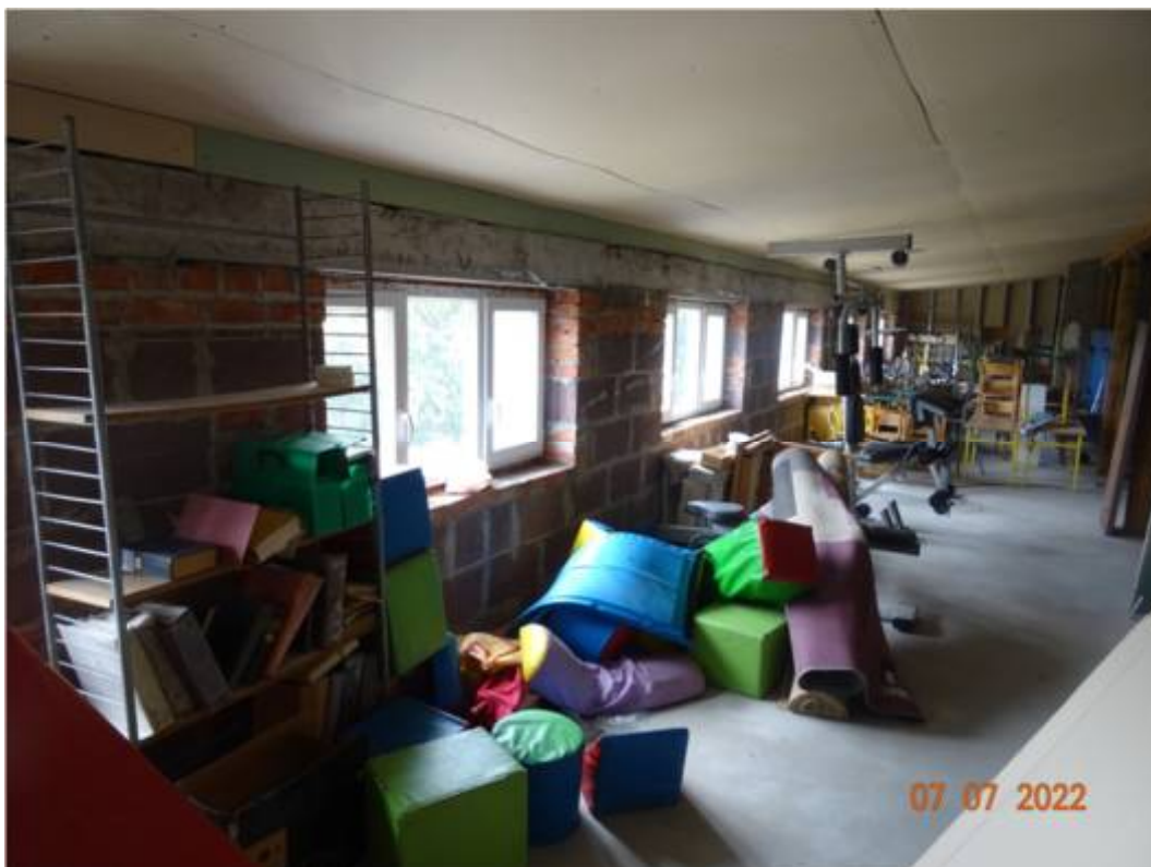
Fot. nr 1. Widok poddasza.
