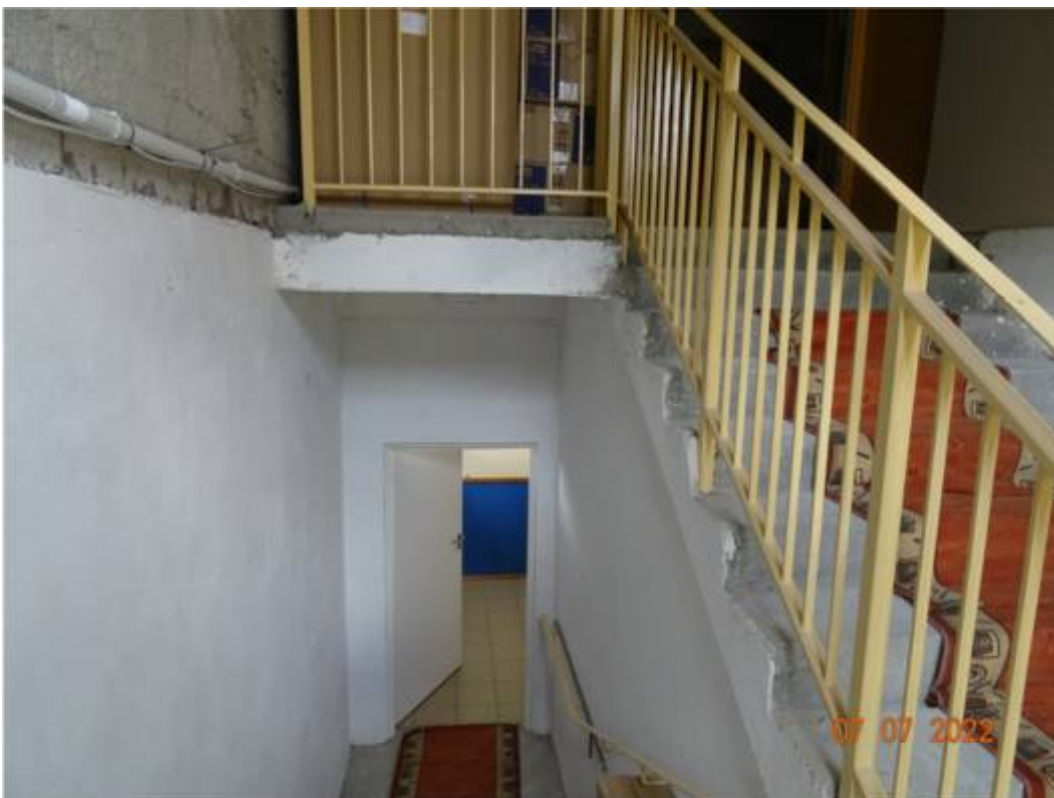
Fot. nr 8. Widok poddasza- klatka schodowa.
