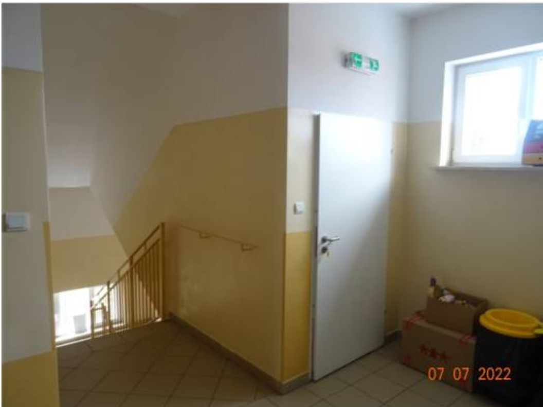
Fot. nr 10. Poziom 1 piętra- drzwi wejściowej na poddasze.
