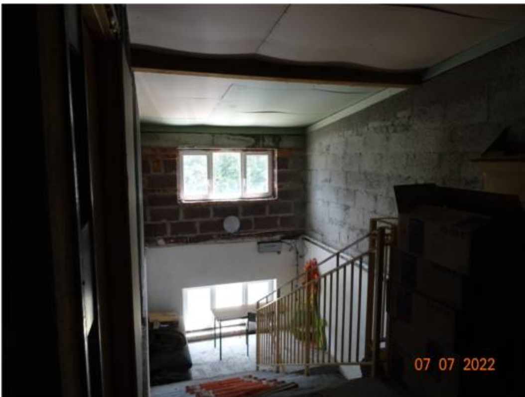
Fot. nr 6. Widok poddasza- klatka schodowa.
