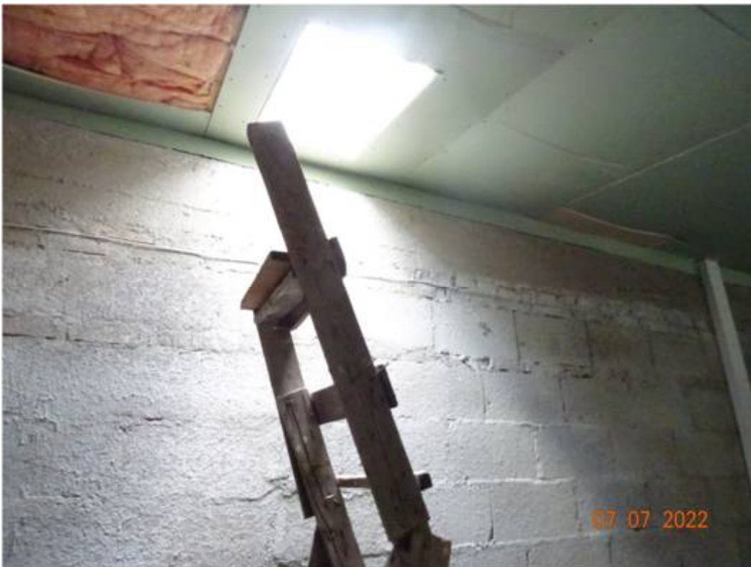
Fot. nr 3. Widok poddasza- wyjście (wyłaz) na dach.
