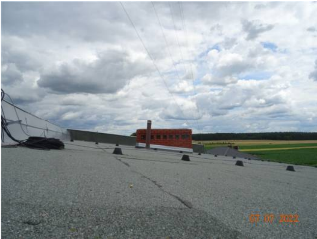
Fot. nr 9. Widok dachu.
