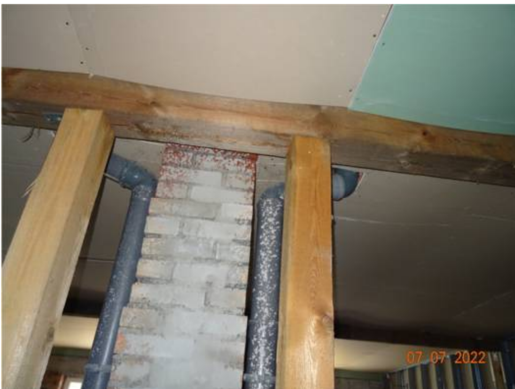
Fot. nr 4. Widok poddasza.
