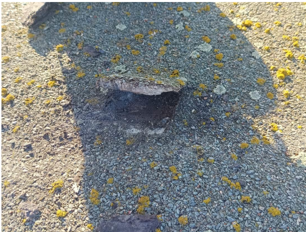
Rys. 6 Odkrywka papy na płytach korytkowych – 2 warstwy papy
