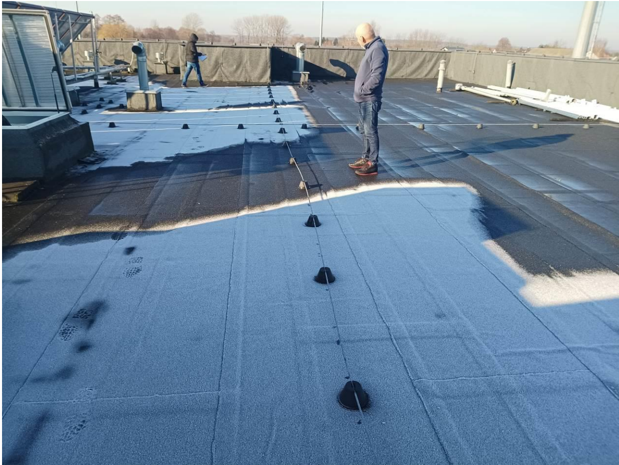
FOT. 1 Widok na połąć dachową – lokalne bąble świadczące o niedogrzeniu fragmentów papy
