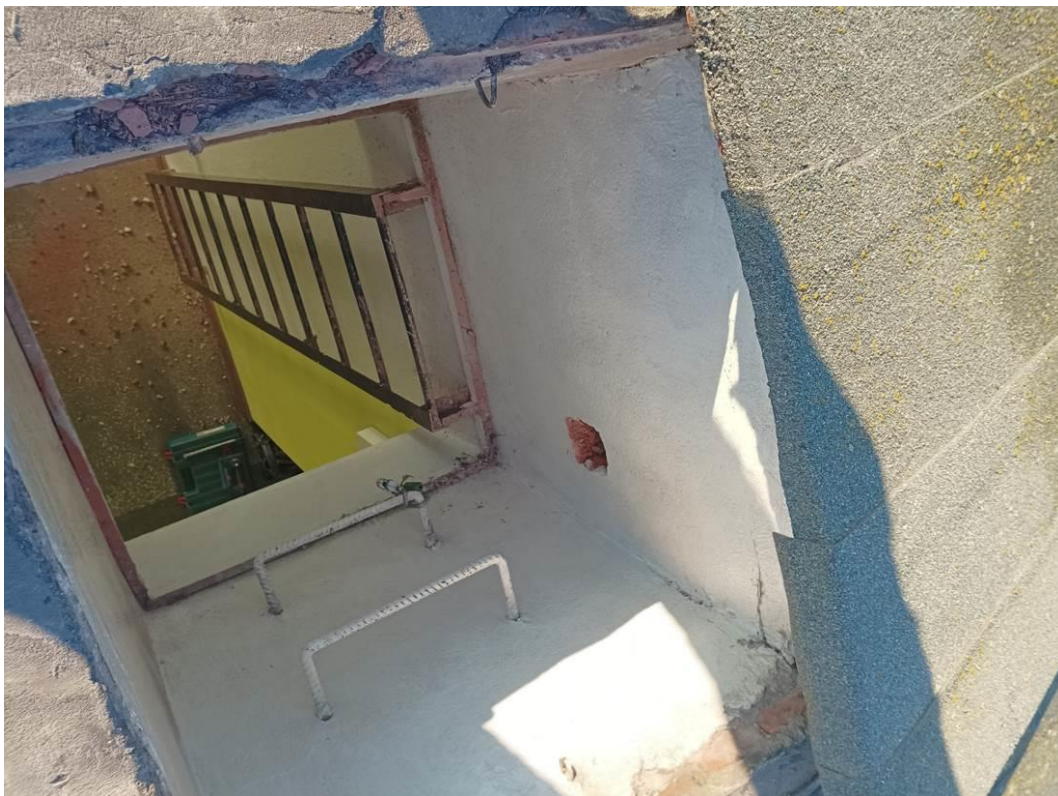
Rys. 7 Odkrywka przestrzeni stropodachu wentylowanego
