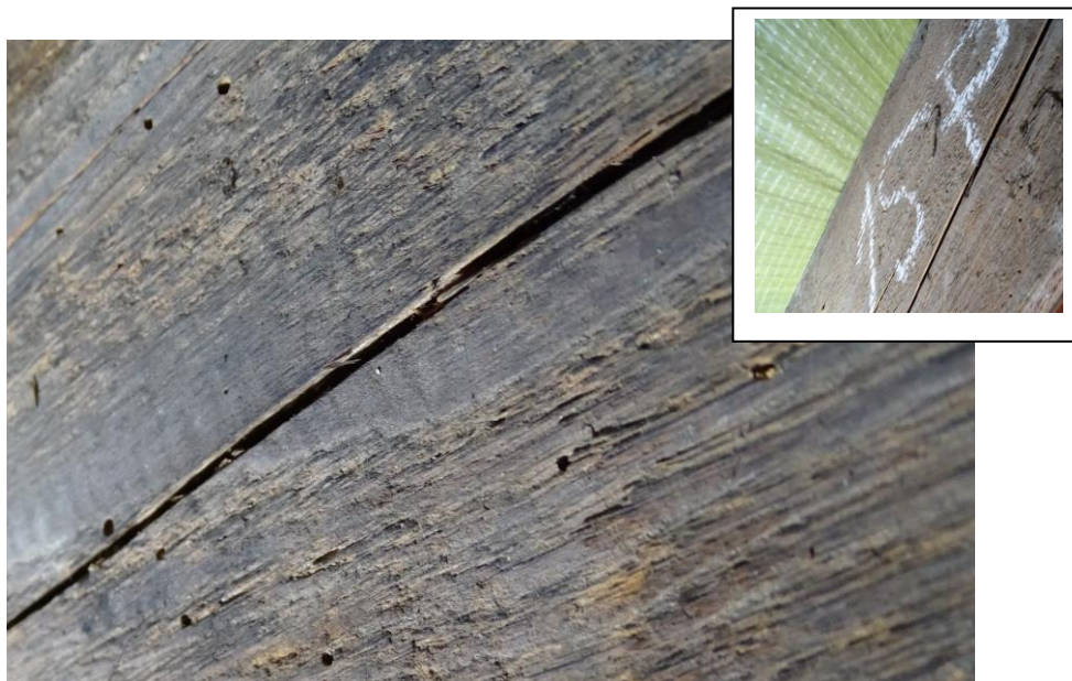
Fot. 34 Ślady bytowania ksylofagów na kolejnej krokwi
