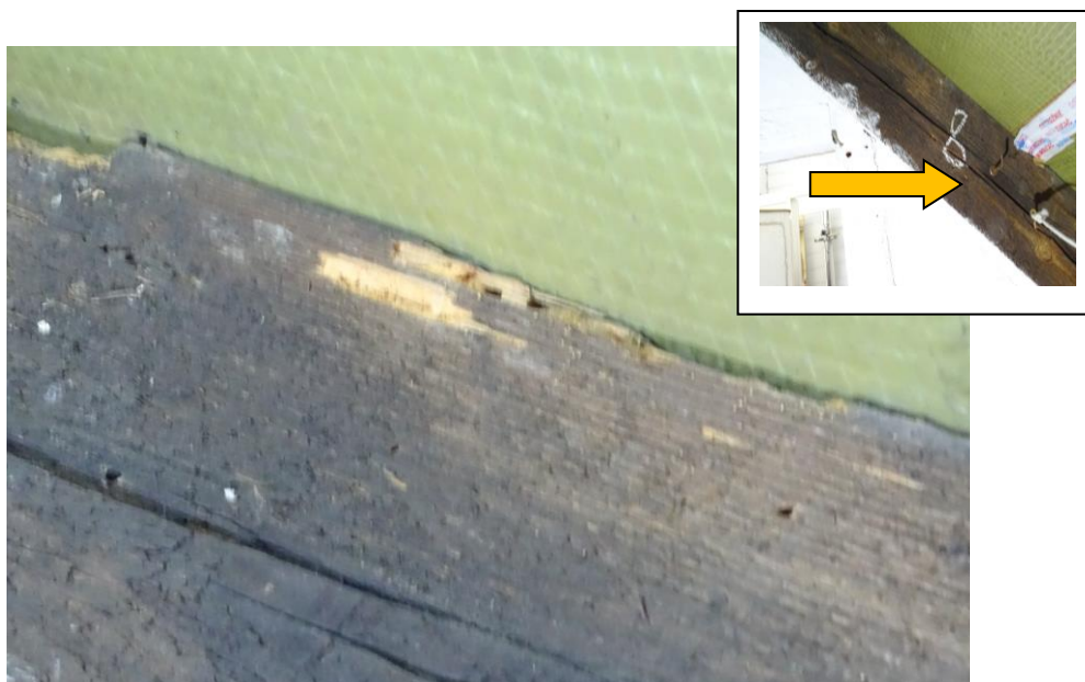
Fot. 81 Czynne żerowisko krokwi (nr 8 od strony okna)
