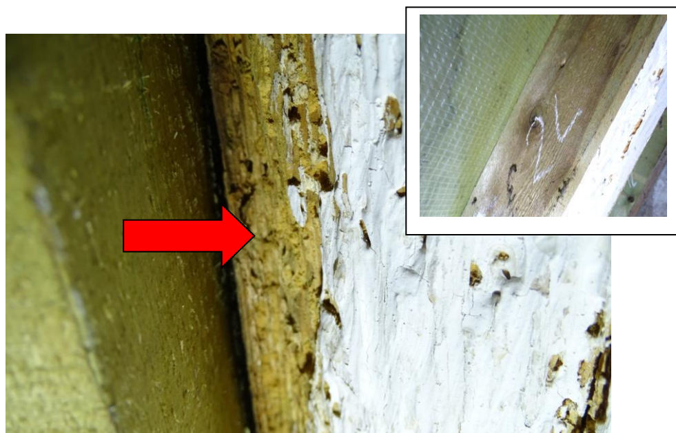
Fot. 4 Zniszczenia dokonane przez drewnojady –krokiew druga od ściany szczytowej (strona od ulicy)
