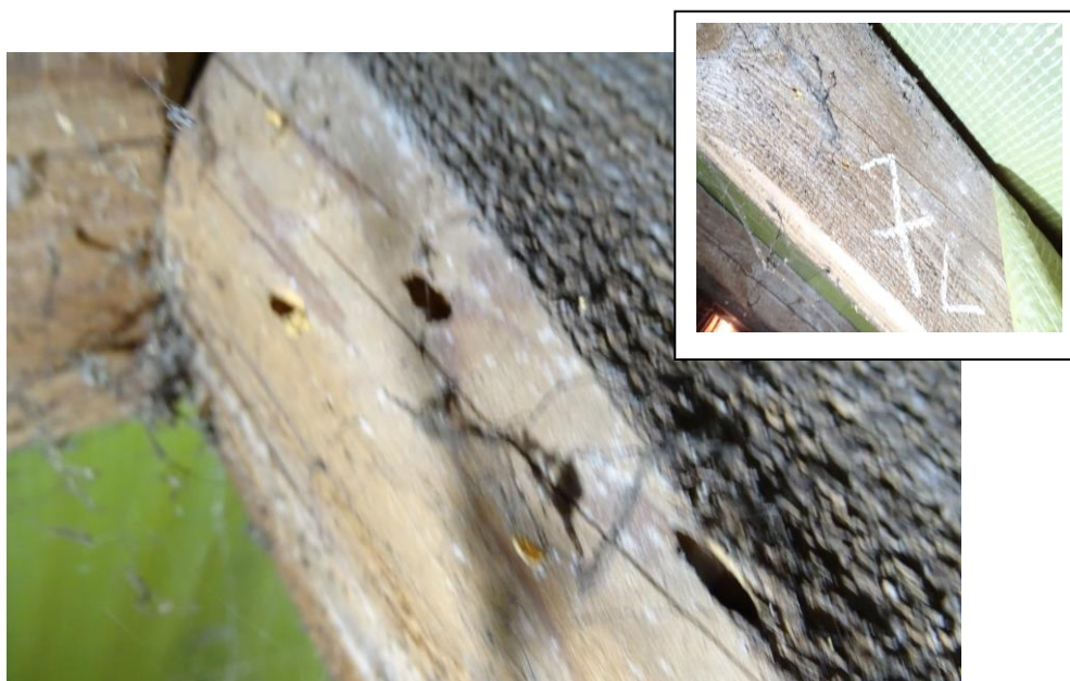
Fot. 40 Otwory wylotowe Spuszczela popolitego na krokwi w skrzydle j.w. (krokiew nr 7 od strony podwórka)
