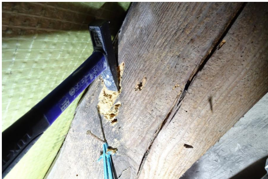
Fot. 72 Ostukiwanie krokwi przy ścianie zewnętrznej wykazuje znaczne zniszczenia dokonane przez drewnojady
