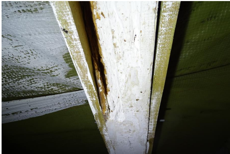
Fot. 5 j.w. krokiew wzmocniona
