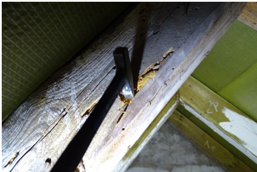
Fot. 9 Ostukiwanie młotkiem j.w.
