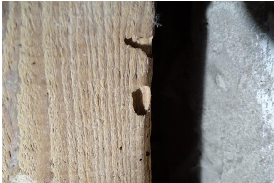
Fot. 3 Otwory wydrążone przez drewnojady
