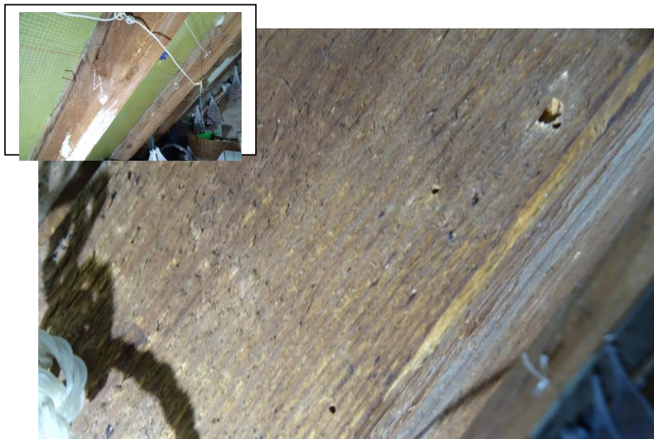
Fot. 76 Otwory wylotowe drewnojadów na kolejnej krokwi w w/w pomieszczeniu
