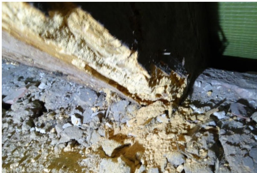
Fot. 47 Ostukiwanie młotkiem wykazało znaczne zniszczenia j.w.
