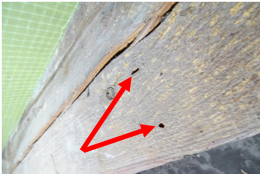
Fot. 57 Otwory wylotowe drewnojadów na kolejnej krokwi wykusza
