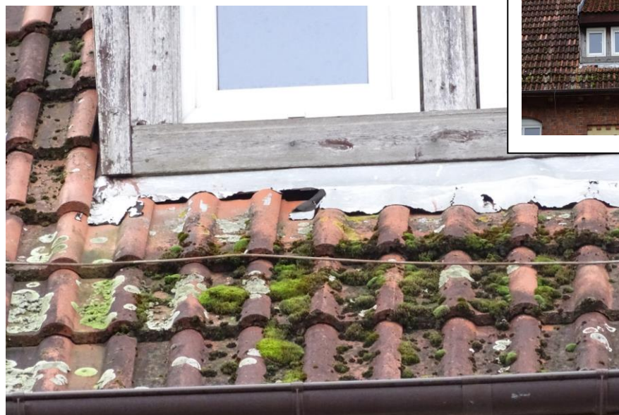
Fot. 101 Ubytki obróbek blacharskich pod oknem, mech, grzyby itd. Na dachówkach
