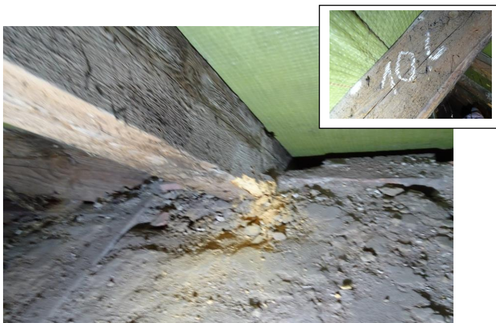
Fot. 46 Zniszczenia dokonane przez ksylofagi krokwi nr 10 od strony podwórka
