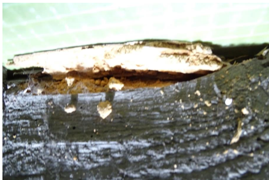
Fot. 18 j.w. znaczne zniszczenia drewna dokonane przez ksylofagi
