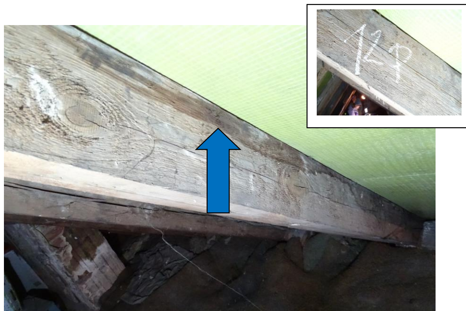
Fot. 29 Zacieki na krokwi na poddaszu j.w.
