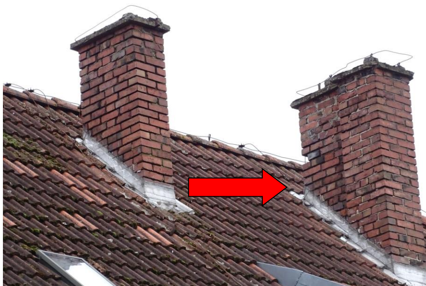
Fot. 98 Rozsypujący się komin. Stanowi zagrożenie dla przechodniów. Należy odgrodzić teren i odpowiednio oznakować
