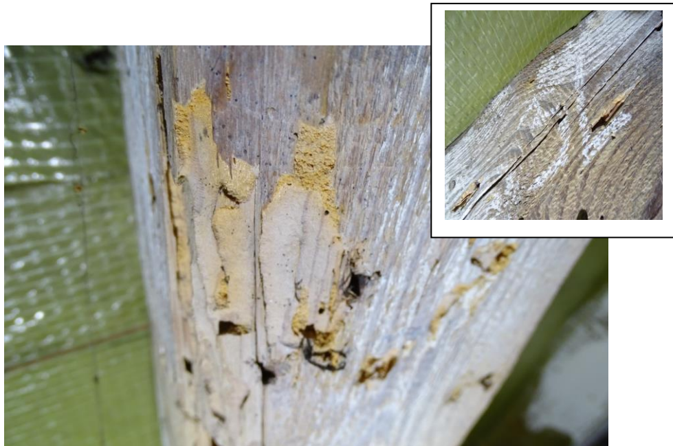
Fot. 7 Korytarze, czynne żerowisko, mączka drzewna z odchodami ksylofagów na krokwi nr 3 od strony ulicy
