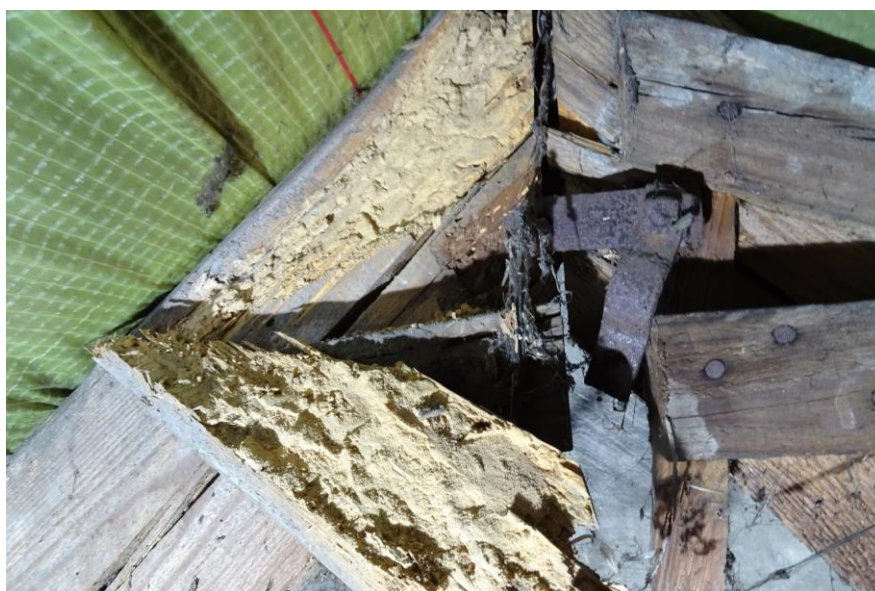
Fot. 54 Ostukiwanie młotkiem wykazało znaczne zniszczenia spowodowane przez ksylofagi
