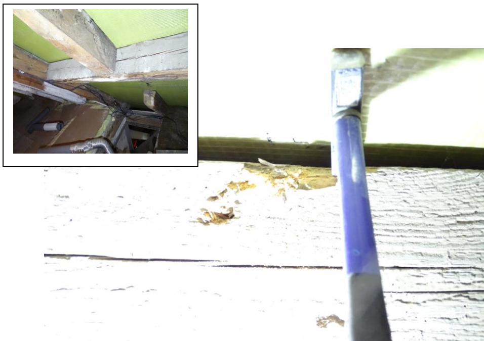
Fot. 17 Ostukiwanie wymianu nad wejściem na poddasze
