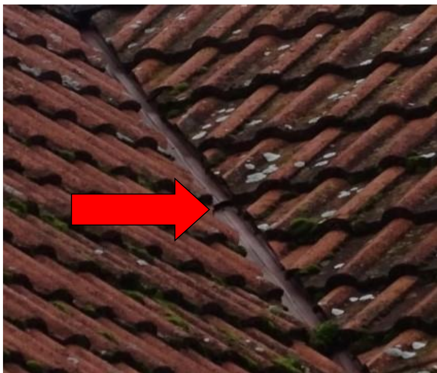
Fot. 96 j.w. widoczna dziura, nieszczelność obróbki koszowej
