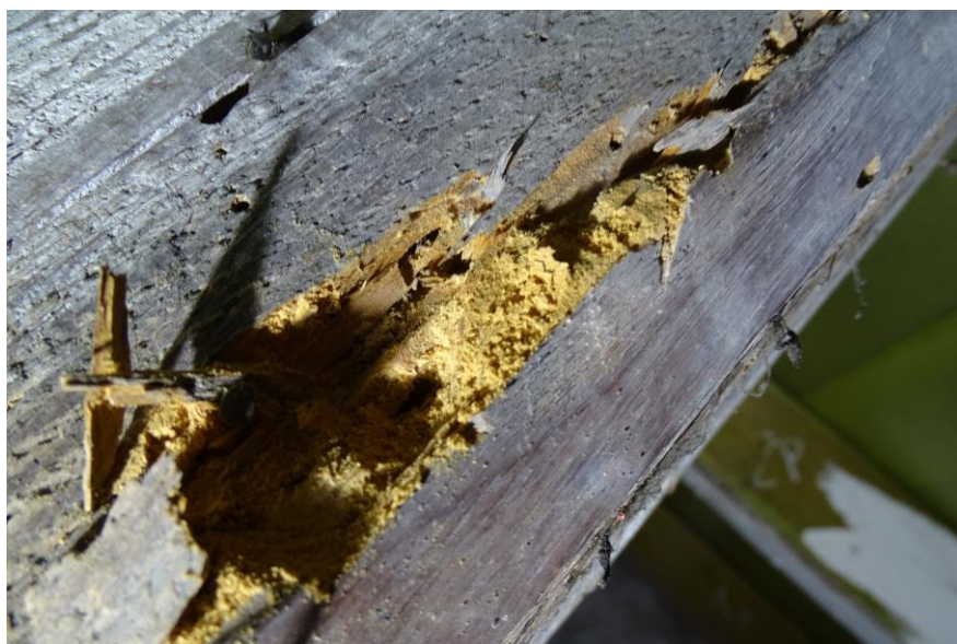
Fot. 10 Ostukiwanie młotkiem wykazuje znaczne zniszczenia dokonane przez ksylofagi – krokiew j.w.
