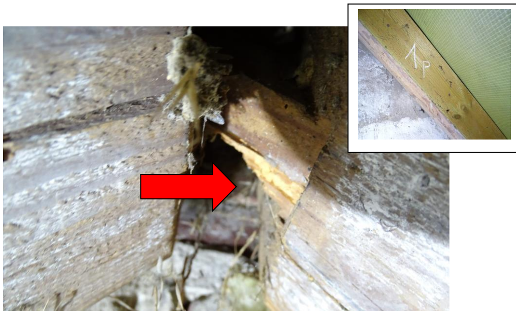
Fot. 2 Czynne żerowisku drewnojadów na łączeniu krokwi w kalenicy (pierwsza krokiew od strony wsch.)
