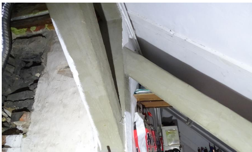
Fot. 67 Elementy połączeniowe dachu zabudowane (mieszkanie) Inne zamalowane
