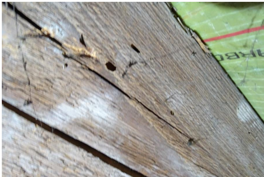
Fot. 53 Otwory wylotowe Spuszczela pospolitego i wysypująca się z nich mączka drzewna z odchodami
