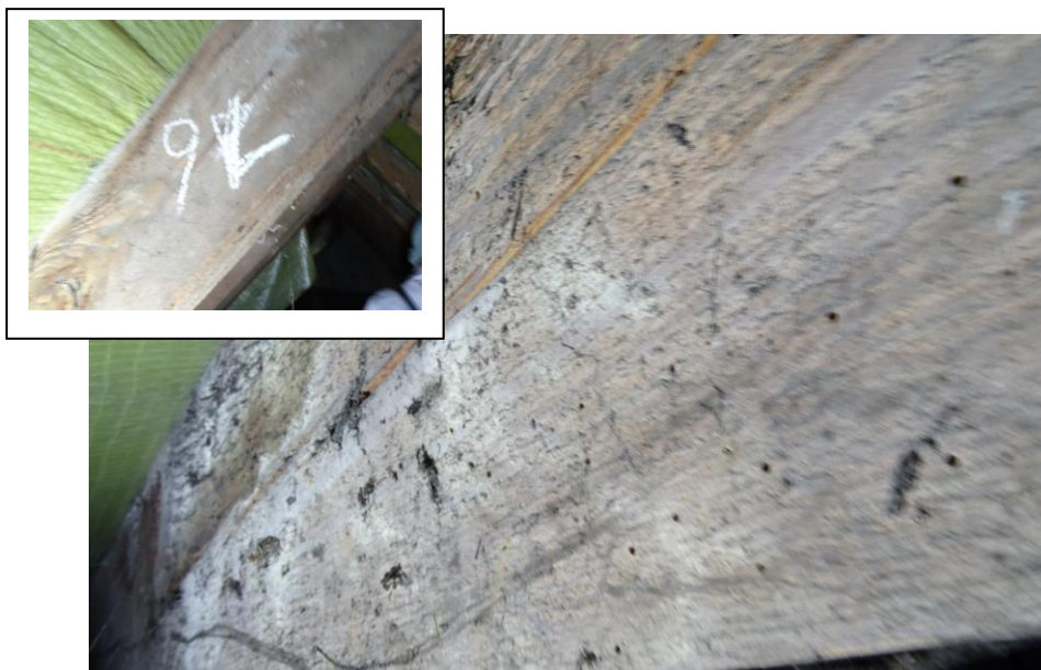
Fot. 43 Otwory wylotowe Anobium punctatum na krokwi nr 9 od strony podwórka
