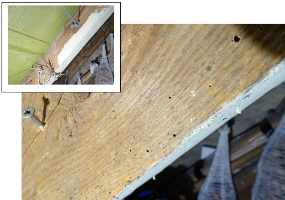
Fot. 74 Otwory wylotowe ksylofagów na krokwi drugiej w kolejności licząc od ściany zewnętrznej
