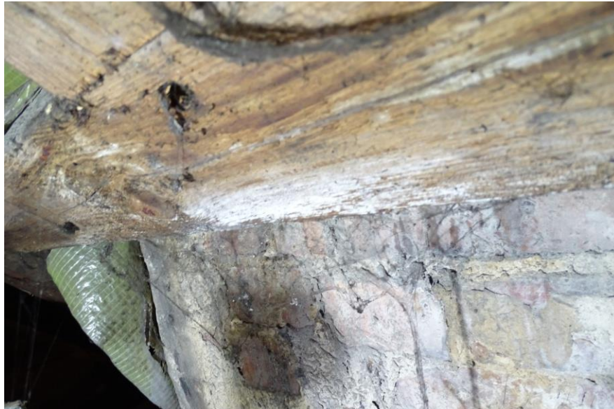
Fot. 19 Przegniła substancja drewna wymianu j.w.
