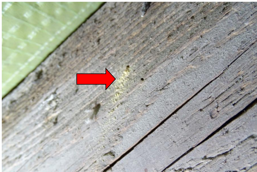
Fot. 13 Wysypująca się mączka drzewna z odchodami Kołatka domowego Anobium punctatum z otworu wylotowego (krokiew nr 5 od strony ulicy) świadczy o czynnym żerowisku
