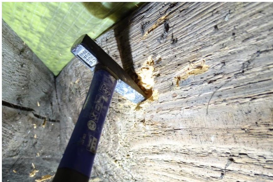
Fot. 37 Ostukiwanie krokwi koszowej
