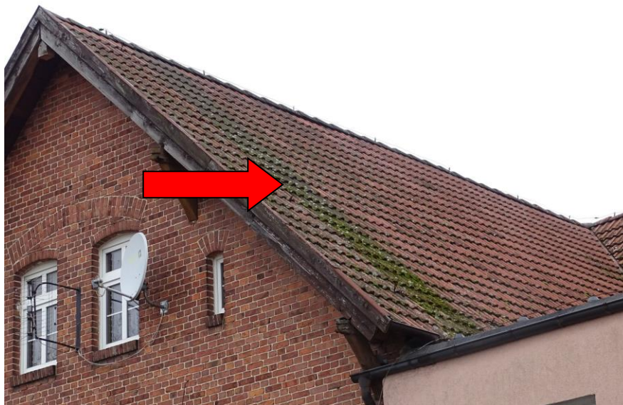
Fot. 97 Glony i mech na dachówce
