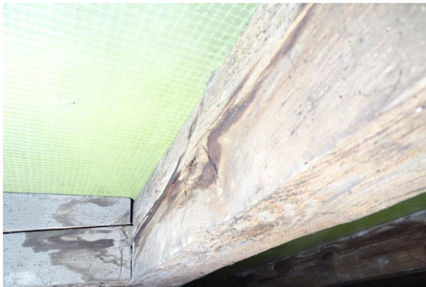
Fot. 21 Zacieki na elementach drewnianych konstrukcji dachu
