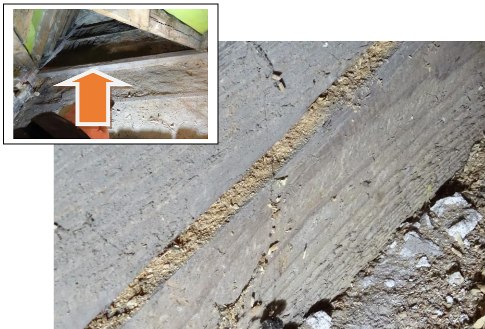
Fot. 49 Podwalina przed wykuszem w skrzydle j.w. widoczna mączka drzewna z odchodami ksylofagów w szczelinie
