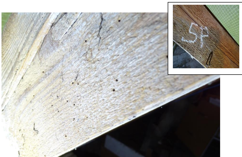
Fot. 11 Otwory wylotowe Kołatka domowego na krokwi nr 5 od strony podwórka
