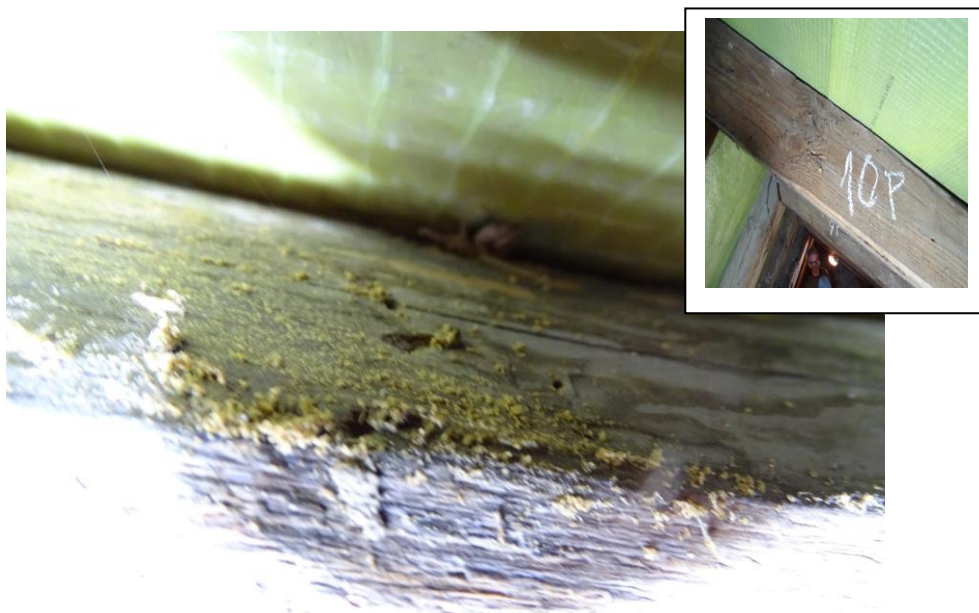
Fot. 20 Czynne żerowisko, sypiąca się mączka drzewna z odchodami drewnojadów na krokwi nr 10 od strony podwórka
