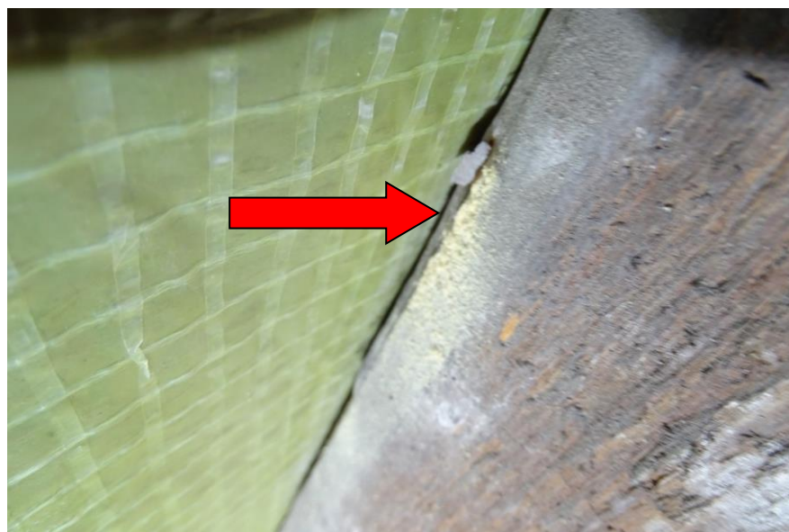
Fot. 60 j.w. sypiąca się mączka drzewna z odchodami drewnojadów wskazuje na czynne żerowisko
