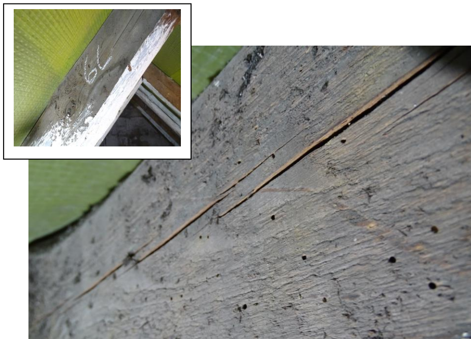
Fot. 16 Otwory wylotowe Kołatka domowego na krokwi nr 6 od strony ulicy
