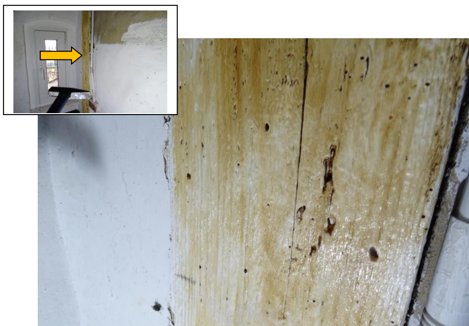
Fot. 86 Otwory wylotowe ksylofagów na słupie drewnianym przy ścianie zewnętrznej zabudowanym ścianą murowaną
