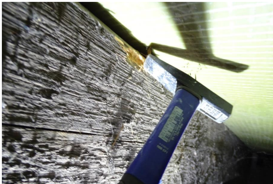
Fot. 33 Ostukiwanie młotkiem krokwi j.w.
