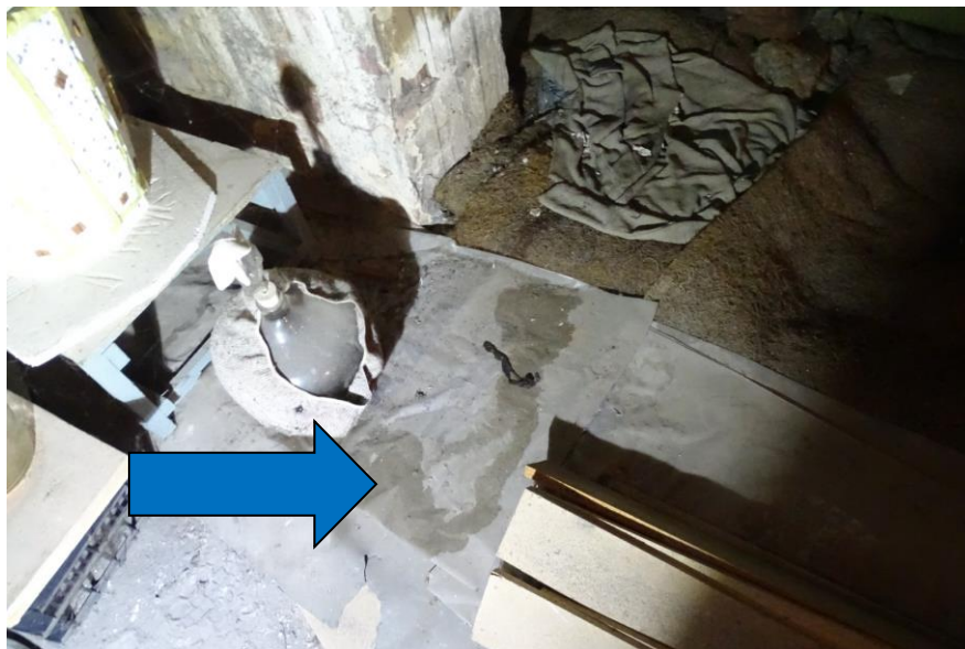
Fot. 23 Nieszczelności w dachu powodują zalewanie podłogi na poddaszu j.w.
