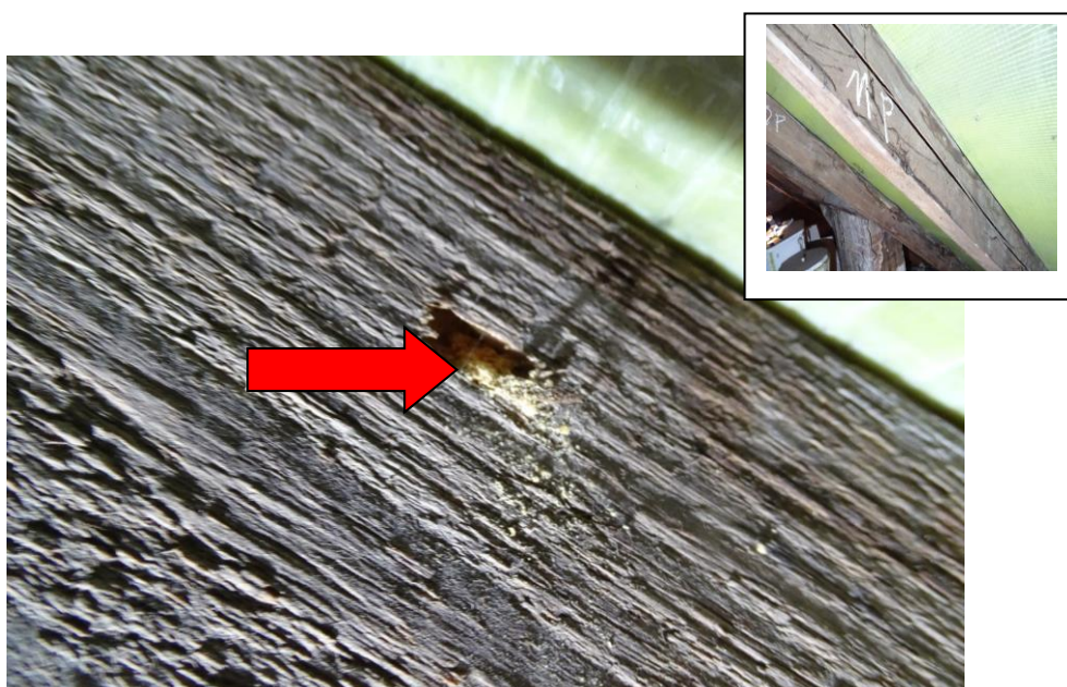
Fot. 26 Czynne żerowisko ksylofagów w krokwi nr 11 od strony podwórka
