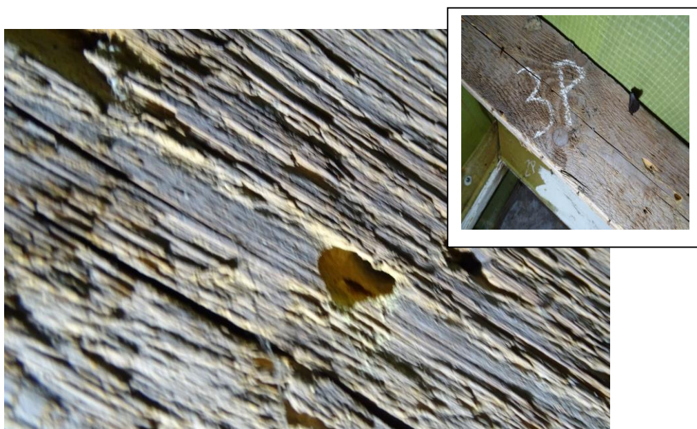
Fot. 6 Sypiąca się z otworu wylotowego mączka z odchodami Spuszczela pospolitego Hylotrupes bajulus (krokiew nr 3 od strony podwórka)
