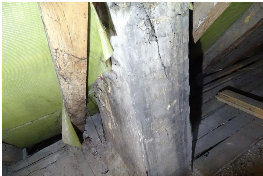
Fot. 27 Zły stan komina od strony ulicy (widoczne zacieki, grzyby pleśniowe, sypiące się tynki)
