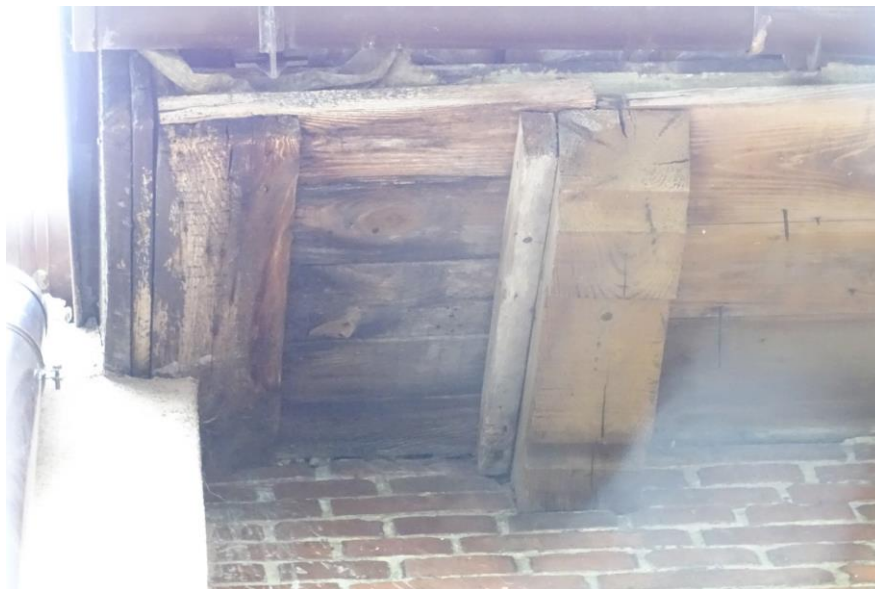
Fot. 91 Zagrzybiony narożnik podbitki dachowej – do wymiany
