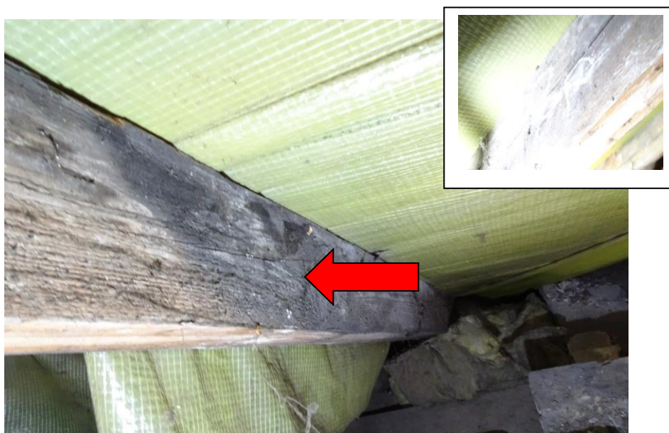
Fot. 42 Przebarwienia, grzyby pleśniowe na krokwi (nr 8 od strony wsch.)
