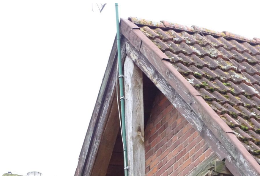
Fot. 100 nieszczelne obróbki blacharskie, glony i mech na dachówce, gnijące obróbki drewniane
