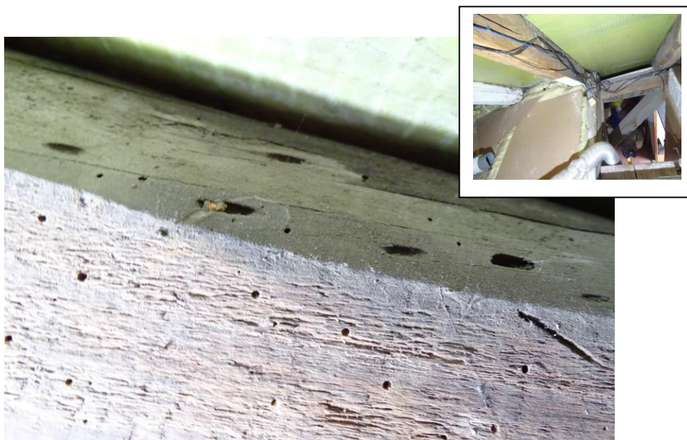
Fot. 14 Otwory wylotowe Spuszczela pospolitego (większe) i Kołatka domowego (mniejsze) na krokwi w okolicy wejścia, klapy na poddasze
