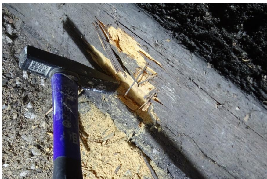
Fot. 50 Ostukiwanie młotkiem wykazywało znaczne zniszczenia spowodowane przez ksylofagi
