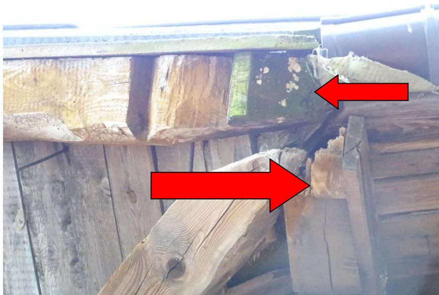
Fot. 92 Przegniłe elementy drewniane w narożniku
