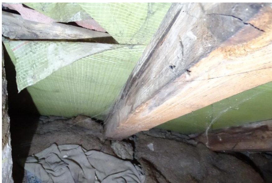
Fot. 22 Zerwana folia izolacyjna j.w.
