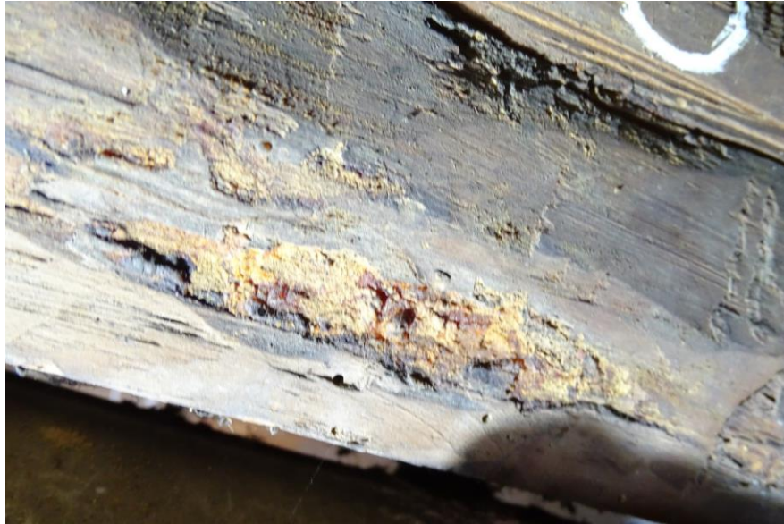
Fot. 15 Żerowisko pod korą Stukacza świerkowca – krokiew j.w.
