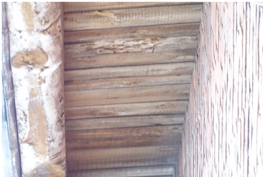
Fot. 93 Zagrzybione deskowania podbitki dachowej
