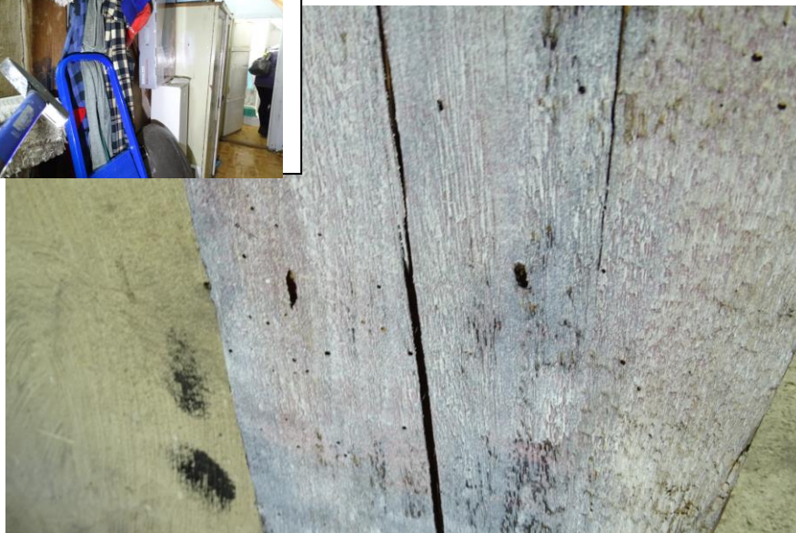
Fot. 82 Otwory wylotowe ksylofagów na słupie drewnianym zabudowanym ścianą murowaną
