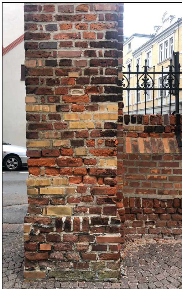
Il. 8 - 11. Ujęcia węgarów i lica filarów bramy – widoczne pozostałości dekoracyjnej spoiny i rozległe uzupełnienia lica cegłami żółtymi.
