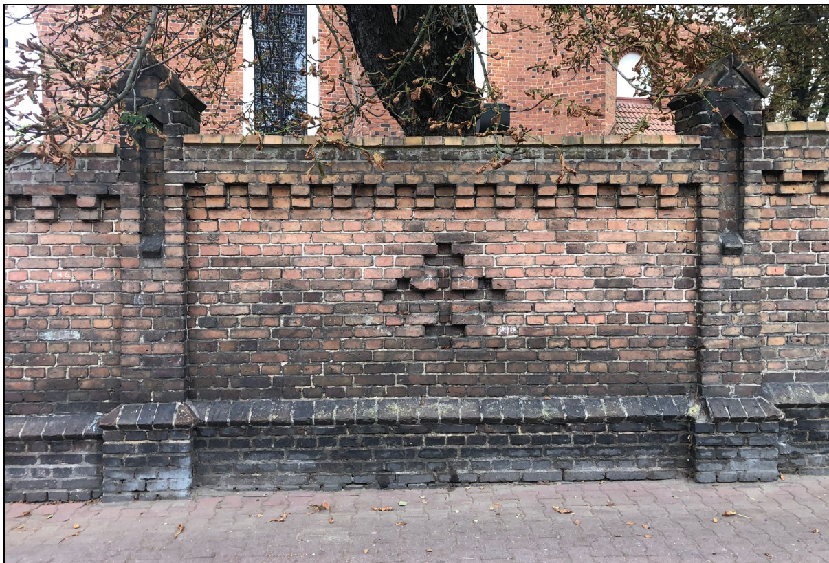
Il. 12. Jedno z przęseł masywnego ogrodzenia z krzyżem trójlistnym (tzw. krzyż Łazarza). Widok od strony ul. Kapłańskiej.
