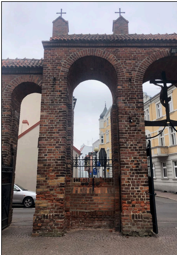
Il. 4 i 5. Wewnętrzna strona bramy – po prawej przęsło w którym zawieszony był dzwon. Pozostały po nim końcówki belki w podłuczcu arkady i schody u podstawy. Widok od strony zachodniej, z poziomu placu wokół bazyliki.
