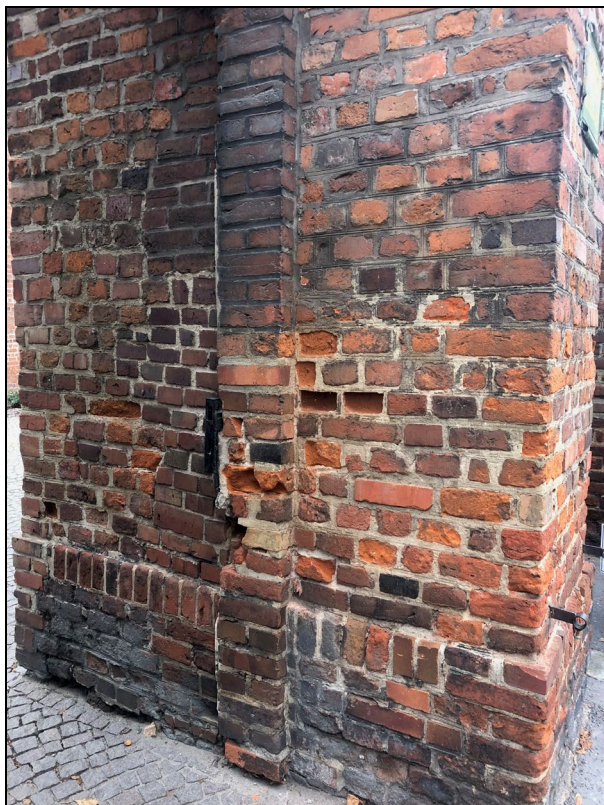
Il. 8 - 11. Ujęcia węgarów i lica filarów bramy – widoczne pozostałości dekoracyjnej spoiny i rozległe uzupełnienia lica cegłami żółtymi.
