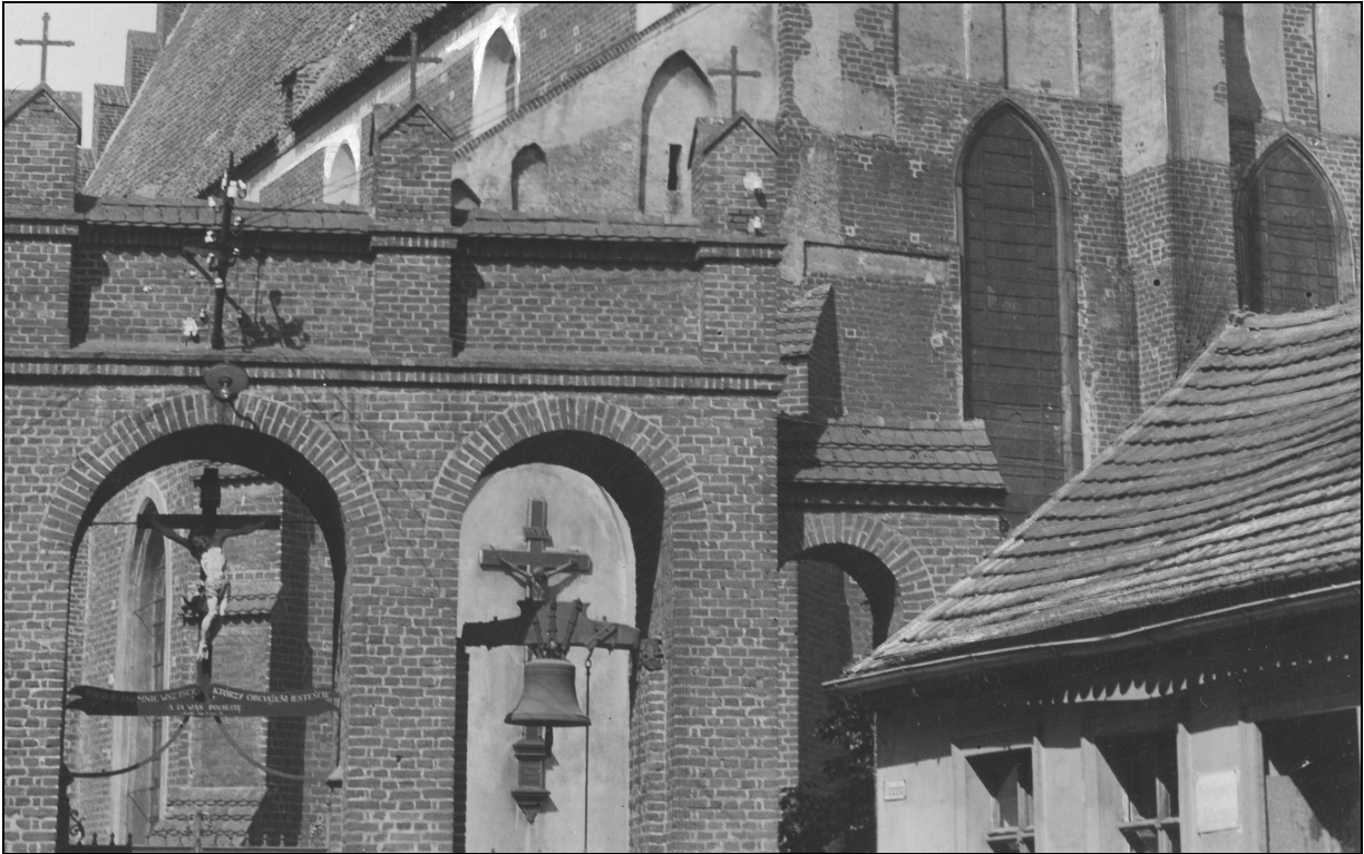
Il. 2. Fotografia kolegiaty z lat 1929-1935 (zbiory Narodowego Archiwum Cyfrowego). U dołu widoczna zewnętrzna, północna część bramy. Na osi przyłączy instalacji telefonicznej. W sąsiedniej, północnej arkadzie niewielki dzwon.
