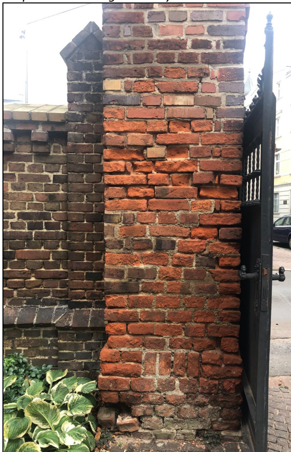
Il. 8 - 11. Ujęcia węgarów i lica filarów bramy – widoczne pozostałości dekoracyjnej spoiny i rozległe uzupełnienia lica cegłami żółtymi.
