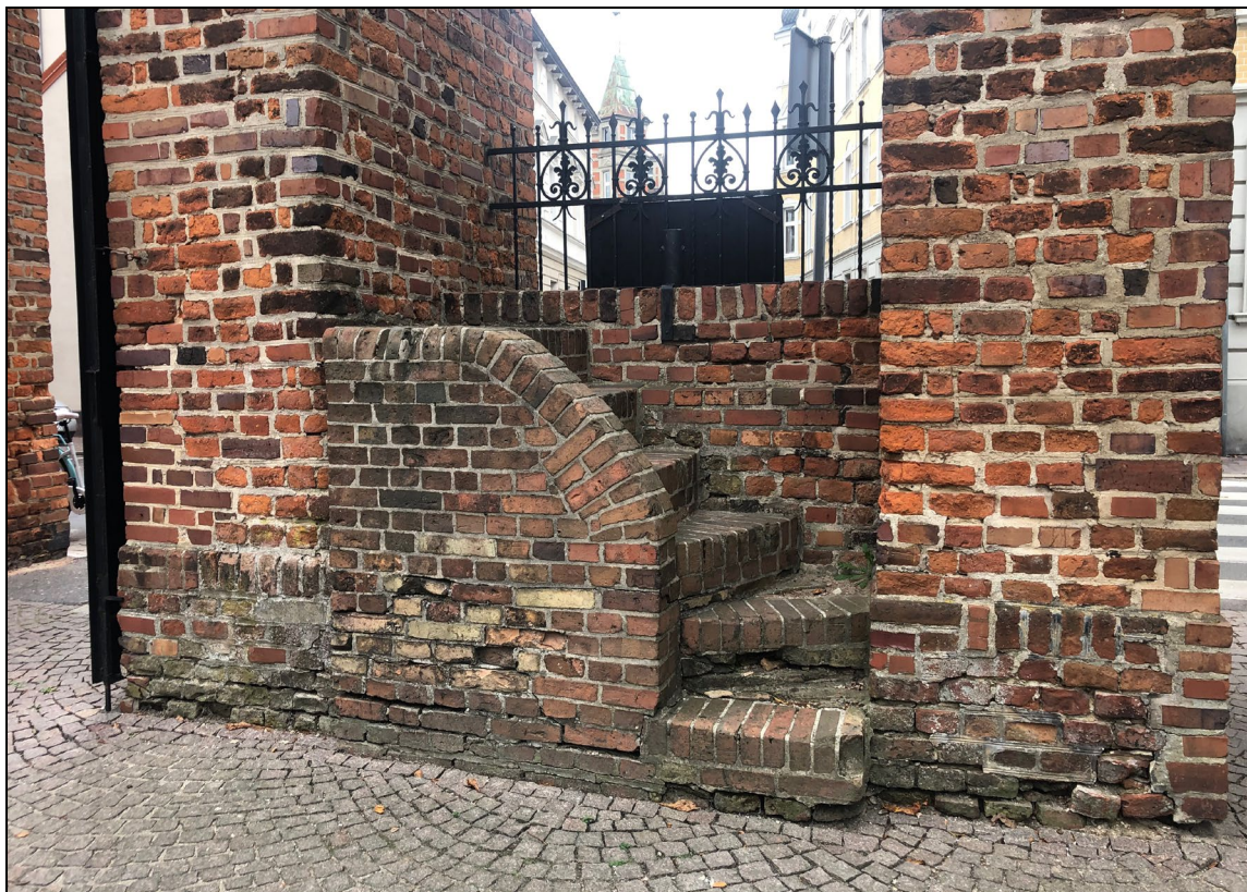
Il. 6. Masywne schody wmurowane wtórnie między arkady bramy w celu obsługi dzwonu po wewnętrznej stronie przęsa południowego.
