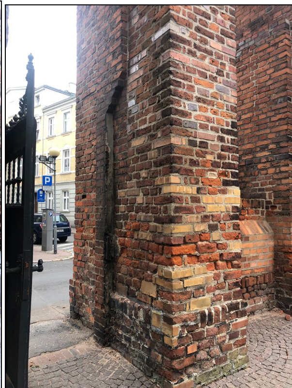
Il. 8 - 11. Ujęcia węgarów i lica filarów bramy – widoczne pozostałości dekoracyjnej spoiny i rozległe uzupełnienia lica cegłami żółtymi.
