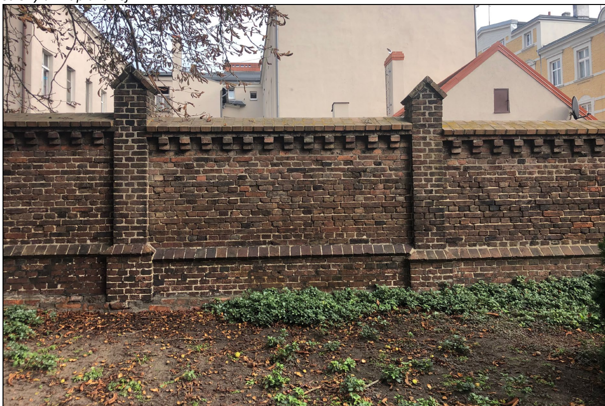
Il. 13. Przęsła masywnego ogrodzenia. Widok od strony ul. Kapłańskiej.
