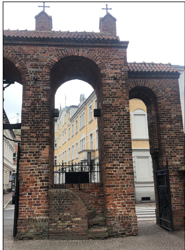
Il. 4 i 5. Wewnętrzna strona bramy – po prawej przęsło w którym zawieszony był dzwon. Pozostały po nim końcówki belki w podłuczcu arkady i schody u podstawy. Widok od strony zachodniej, z poziomu placu wokół bazyliki.
