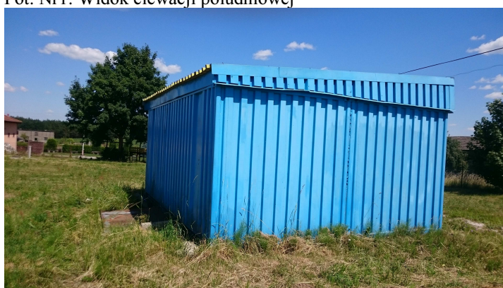
Fot. Nr1. Widok elewacji zachodniej
