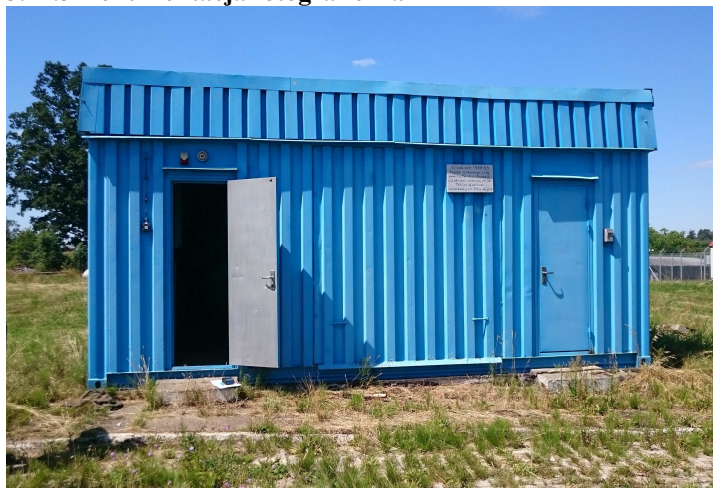
Fot. Nr1. Widok elewacji południowej
