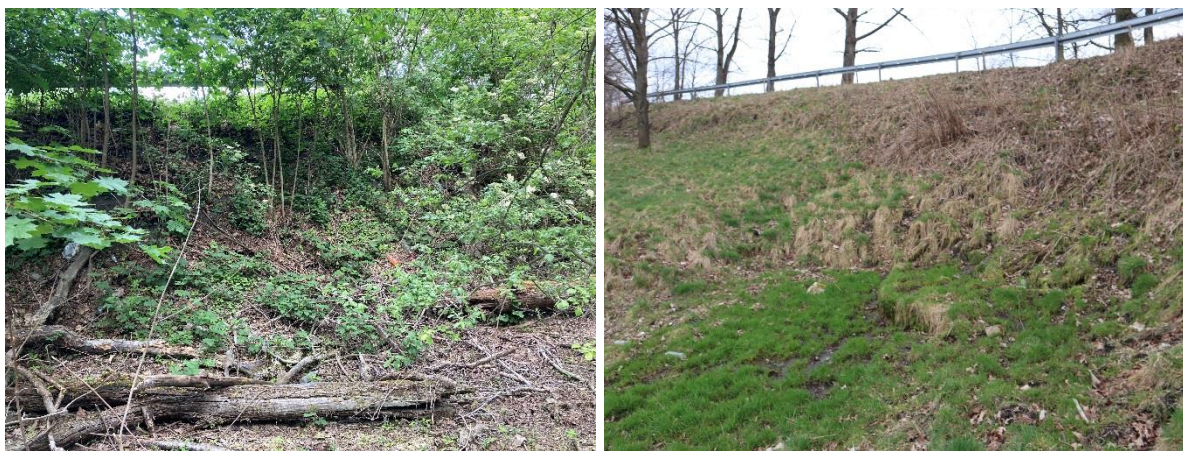
Fot. Przepust nr 1. Widok wlotu, widok wylotu (droga powiatowa 2466D, stan 03-04.2024 r.).
