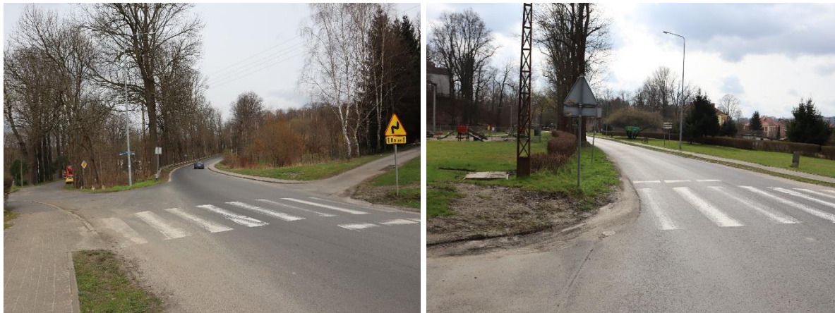
Fot. Przejście dla pieszych nr 2. Przejście dla pieszych w ciągu ul. M. Reja / ul. Lechów w Leśnej (DP 2466D, stan 03.2024 r.).
