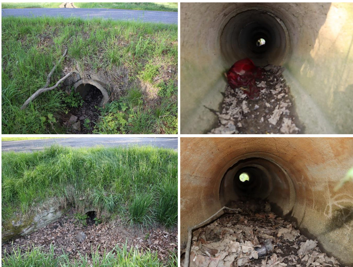
Fot. Przepust nr 3. Widok wlotu, przewód przepustu, widok wylotu, przewód przepustu (DP 2466D, stan 04.2024 r.).
