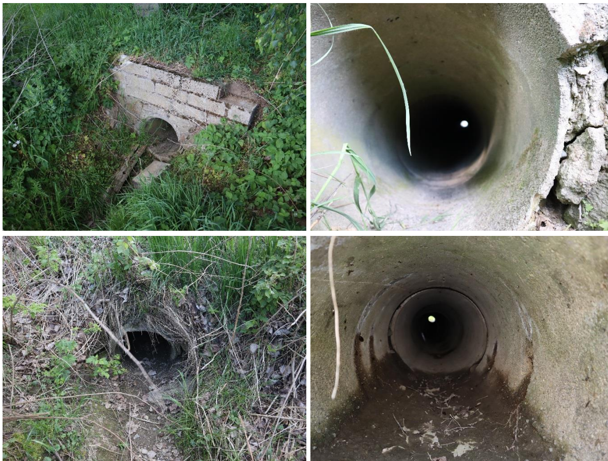
Fot. Przepust nr 6. Widok wlotu, przewód przepustu, widok wylotu, przewód przepustu (DP 2466D, stan 04.2024 r.).
