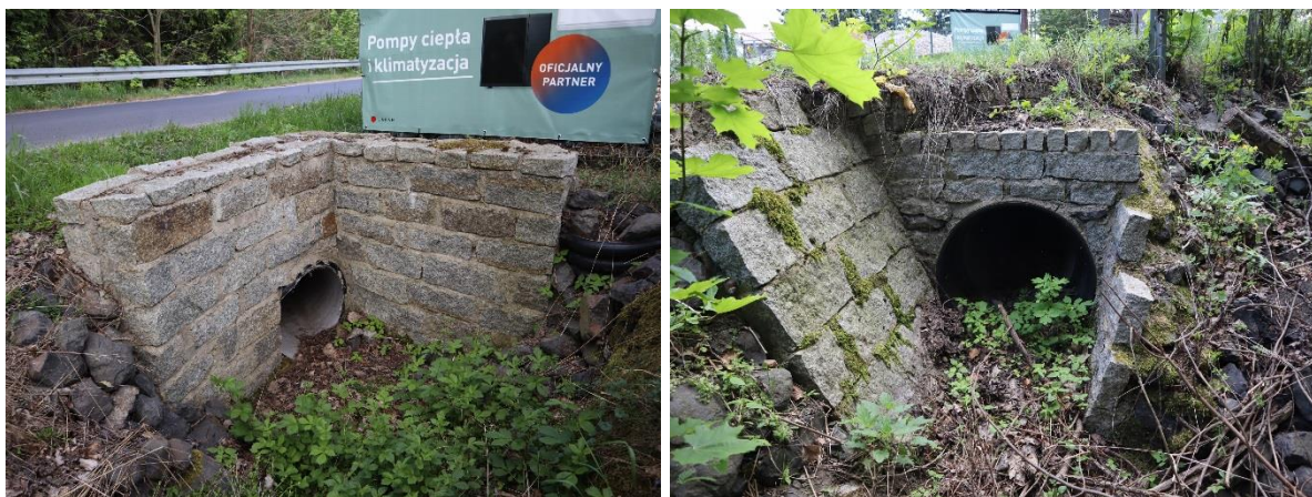
Fot. Przepust nr 5. Widok wlotu, widok wylotu (droga powiatowa 2466D, stan 04.2024 r.).
