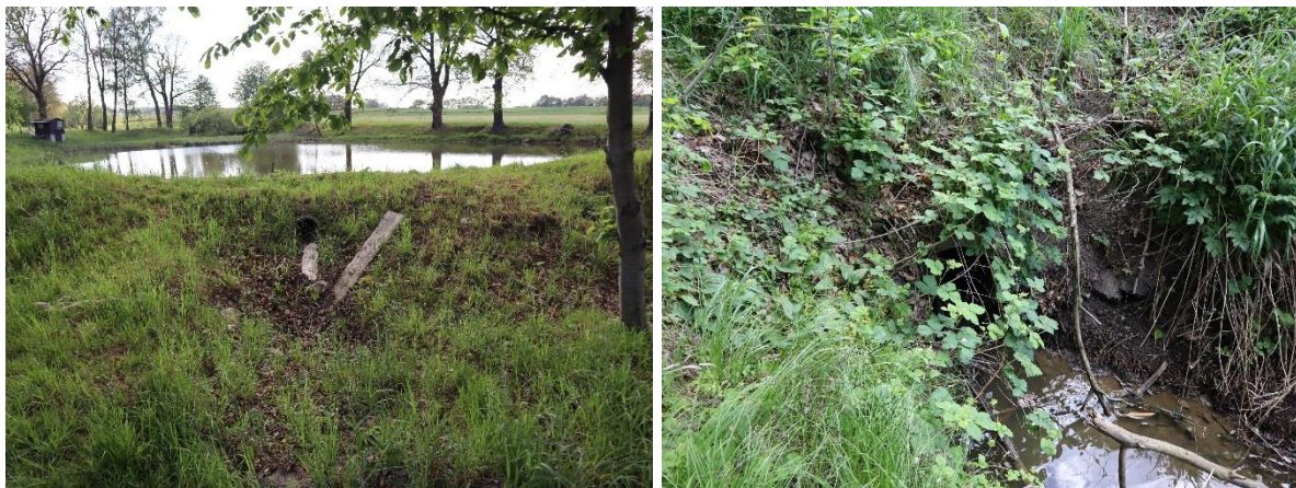
Fot. Przepust nr 4. Widok wlotu, widok wylotu (droga powiatowa 2466D, stan 04.2024 r.).
