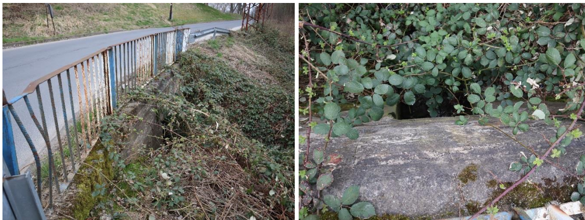
Fot. Przepust nr 6. Widok wlotu, przewód przepustu, widok wylotu (droga powiatowa 2466D, stan 03.2024 r.).
