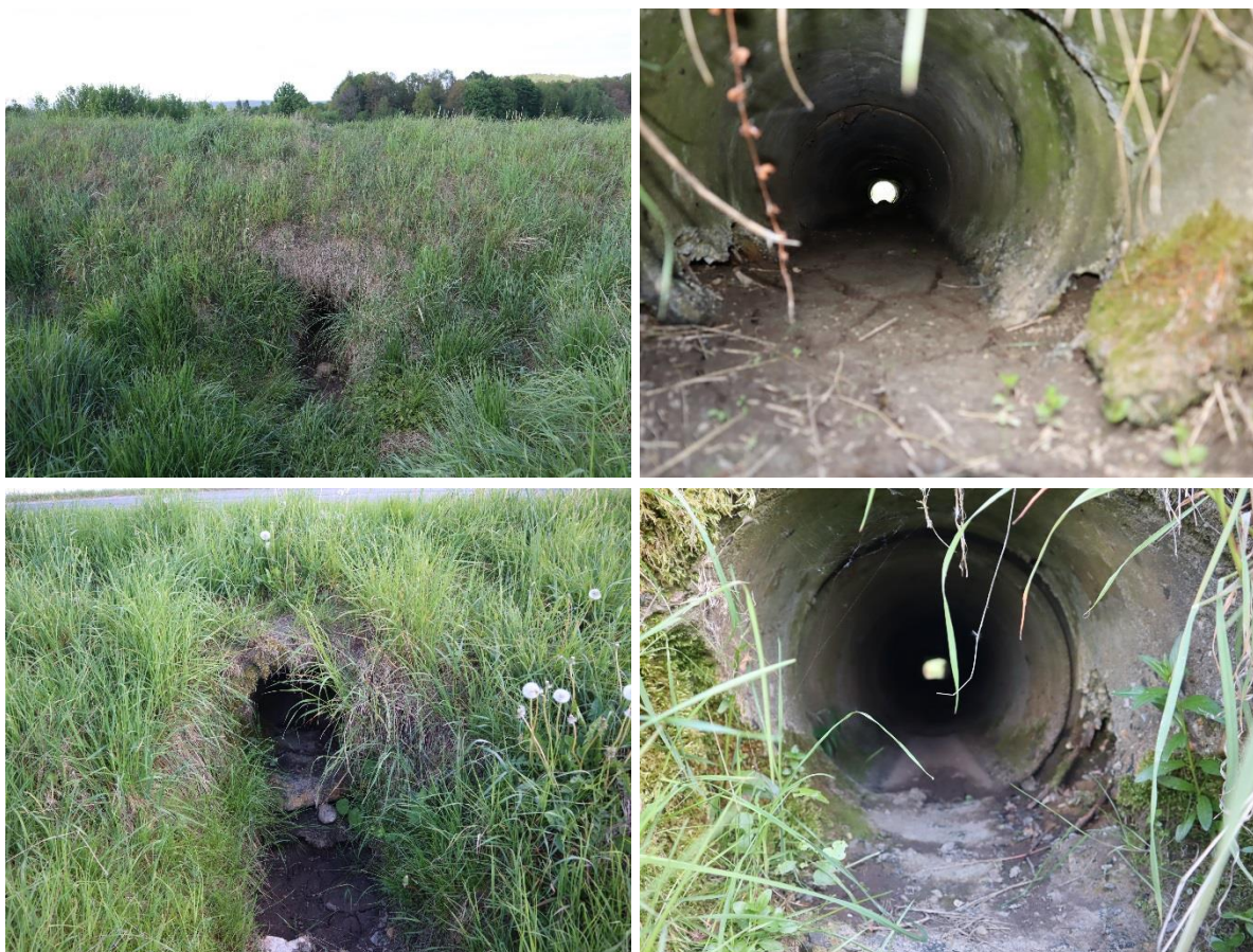
Fot. Przepust nr 8. Widok wlotu, przewód przepustu, widok wylotu, przewód przepustu (DP 2466D, stan 04.2024 r.).
