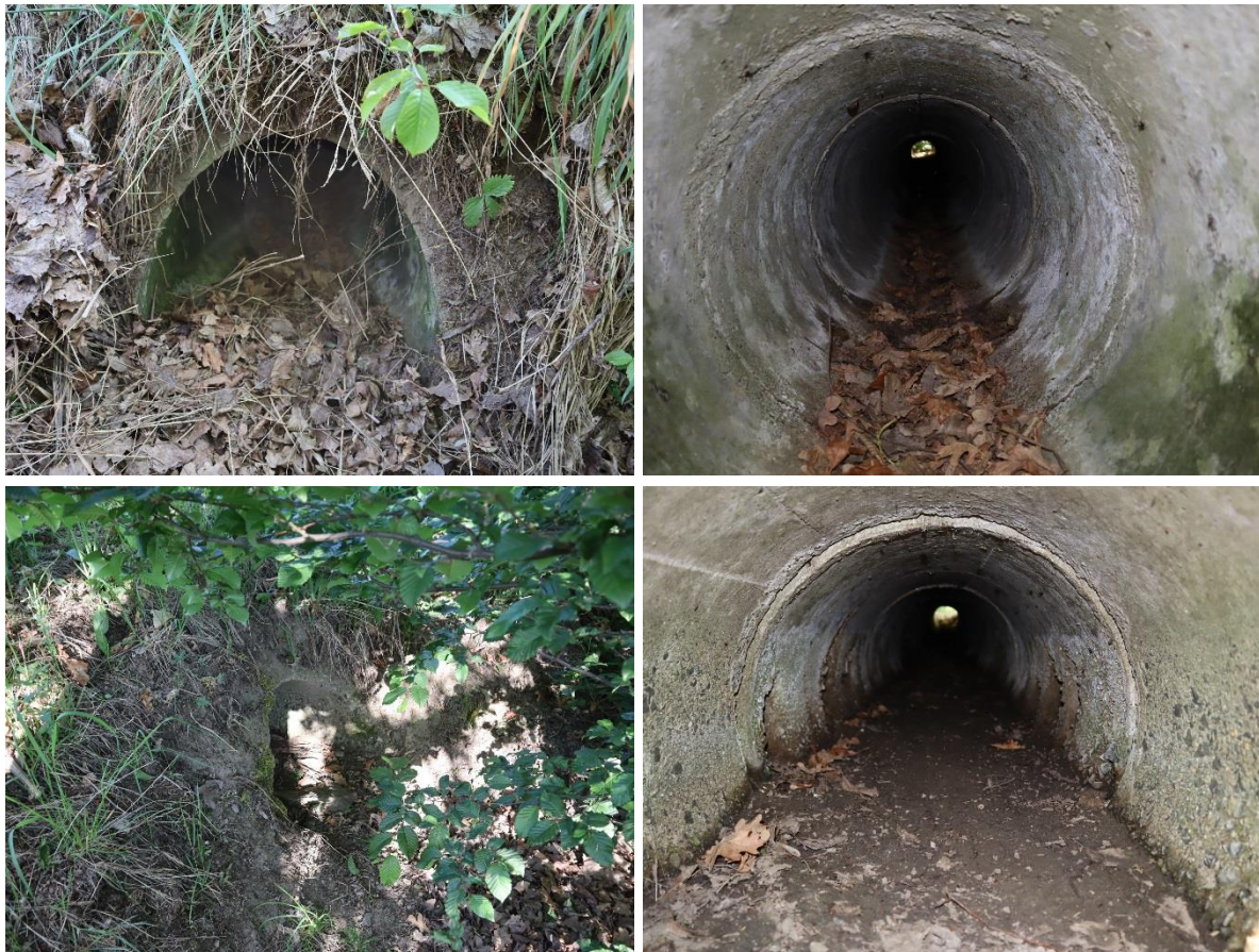
Fot. Przepust nr 9. Widok wlotu, przewód przepustu, widok wylotu, przewód przepustu (DP 2466D, stan 04.2024 r.).
