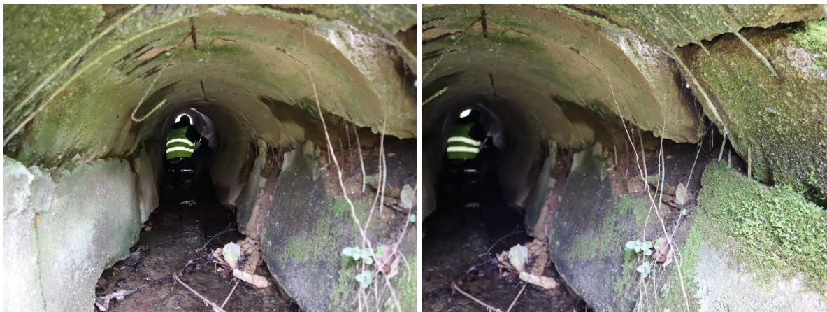
Fot. Przepust nr 2. Widok wlotu, widok wylotu, przewód przepustu (droga powiatowa 2466D, stan 03.2024 r.).
