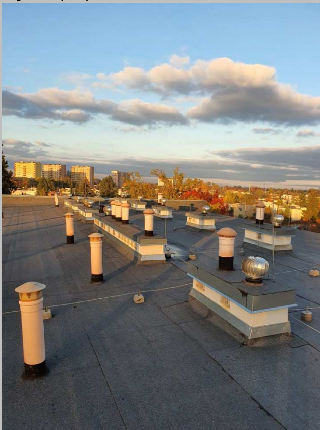
Zdj.3 . Obróbki o kominy wentylacyjne
