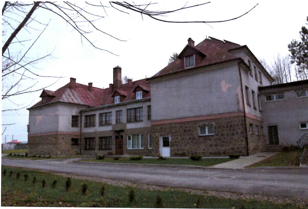
Fot. 1. Budynek Internatu Zespołu Szkół Zawodowych w Bobowej - elewacja frontowa od strony wewnętrznej drogi dojazdowej - stan istniejący. Od strony prawej widoczna dobudówka części warsztatowej szkoły - poza zakresem opracowania.
