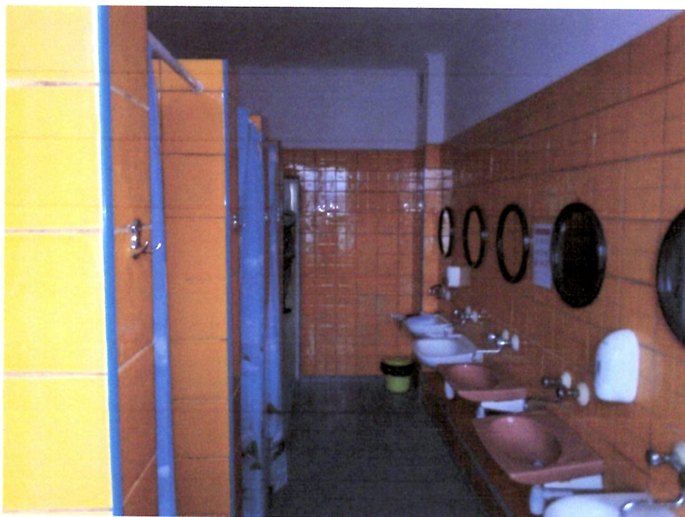
Fot. 12. Budynek j.w. - pomieszczenia sanitarne na I piętrze do przebudowy - stan istniejący.
