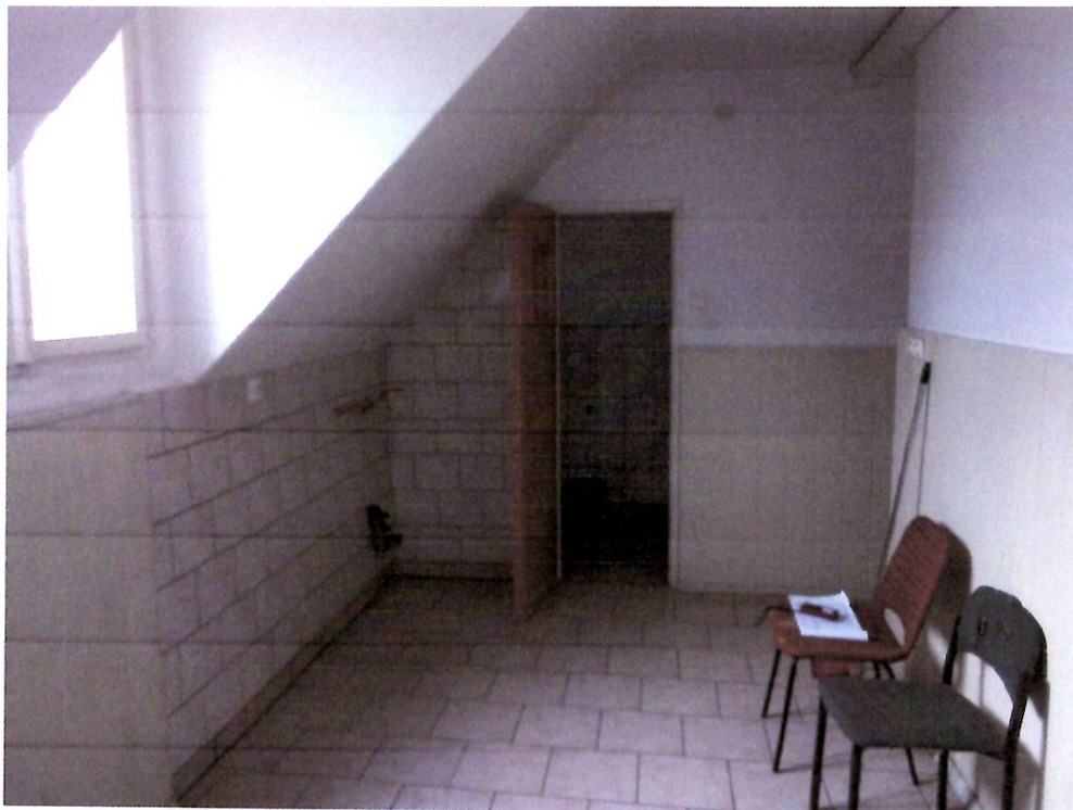
Fot. 13. Pomieszczenia użytkowe na II piętrze przeznaczone do przebudowy na węzeł sanitarny - stan istniejący.
