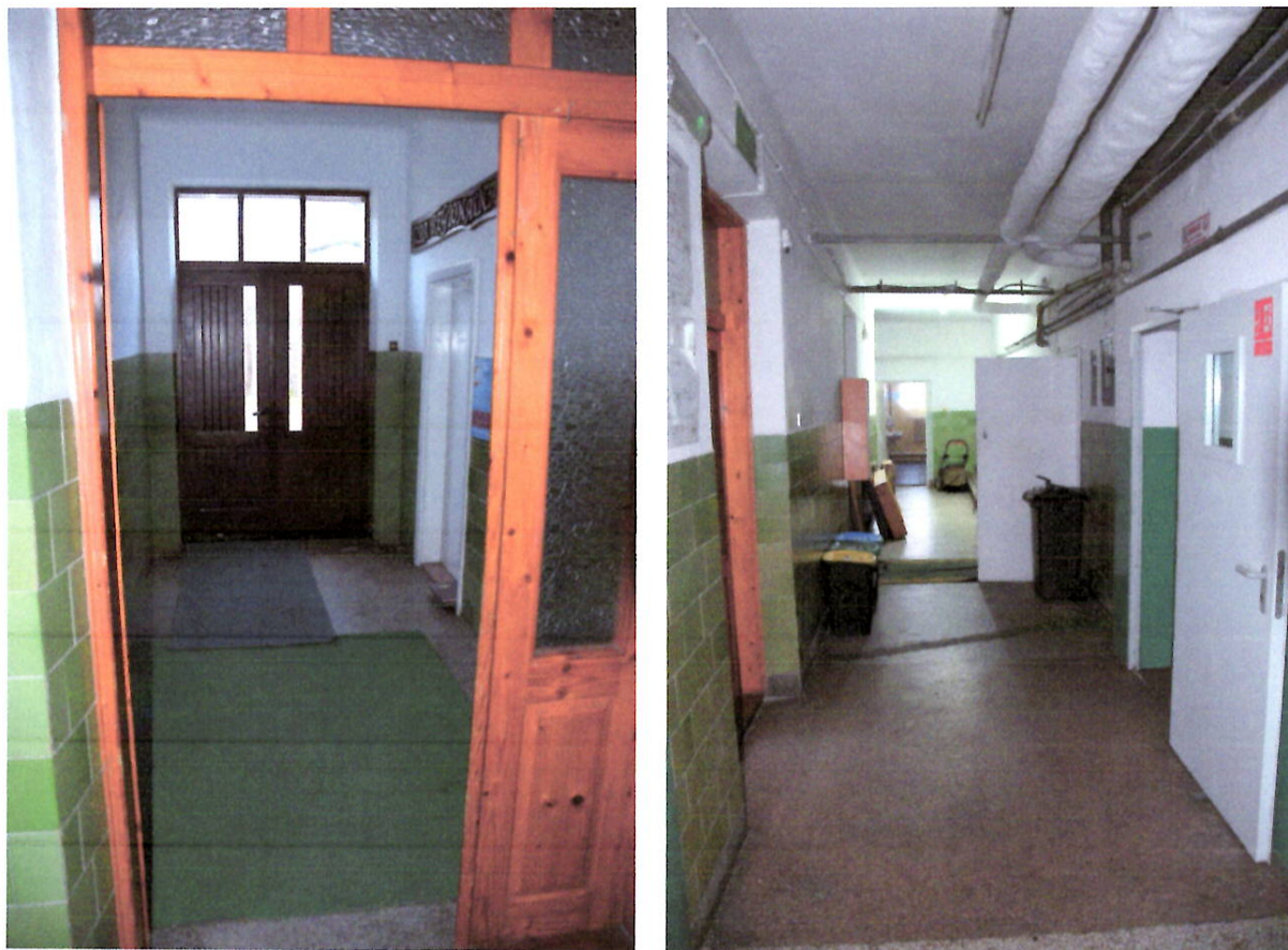
Fot.5, 6. Budynek j.w.- widok drzwi wejściowych od strony wewnętrznego korytarza. Po prawej stronie widoczne drzwi do pomieszczenia izby regionalnej, w której zostanie zlokalizowany szyb windowy. Na drugim zdjęciu widoczny korytarz na parterze budynku, gdzie zlokalizowane zostanie wejście do windy.
