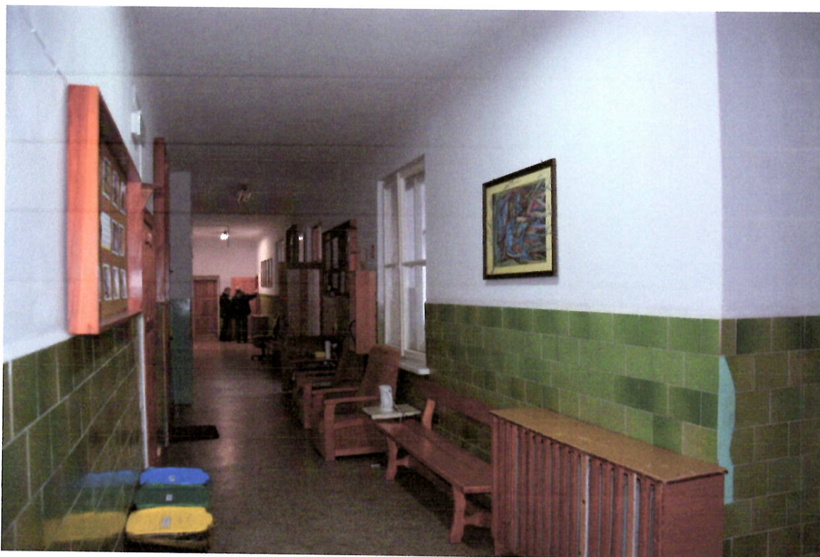
Fot.9. Budynek j.w. – korytarz na poziomie I piętra – po prawej widoczne okno wewnętrzne do przebudowy na wejście do windy.
