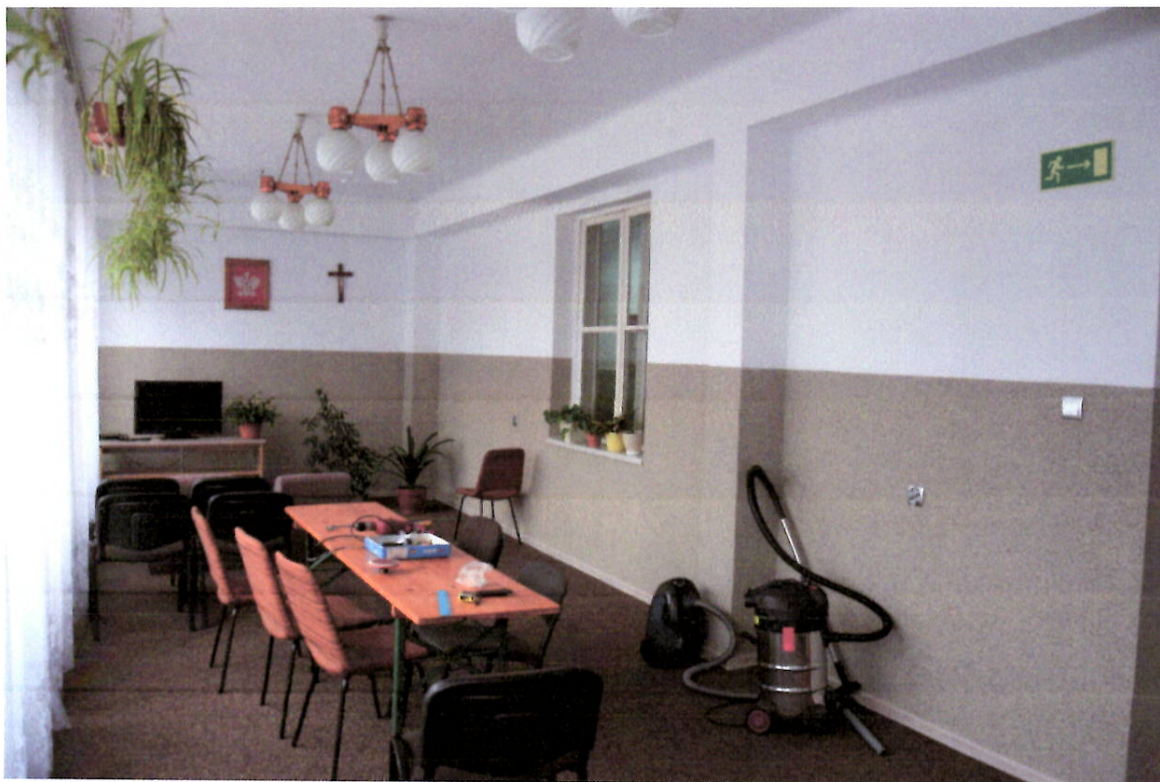
Fot. 8. Pomieszczenie świetlicy na kondygnacji I piętra budynku – po lewej widoczne okno wewnętrzne, w miejscu którego zlokalizowane zostanie wejście do windy od strony korytarza.
