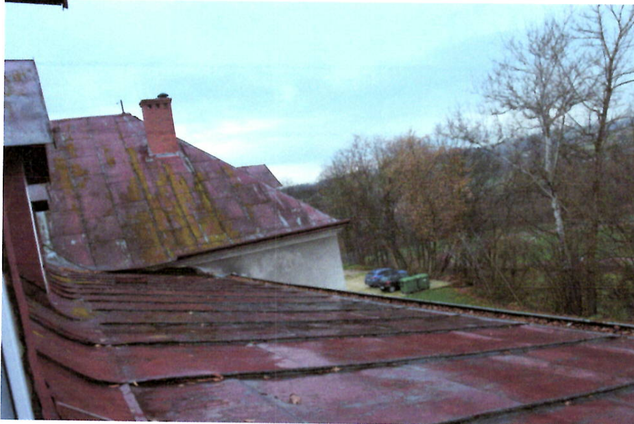
Fot.18. Budynek j.w. – dach jednospadowy z pokryciem z blachy ocynkowanej malowanej nad pomieszczeniem świetlicy znajdującej się na I piętrze budynku - widoczne miejsca lokalizacji projektowanego szybu windy (poziom II piętra).
