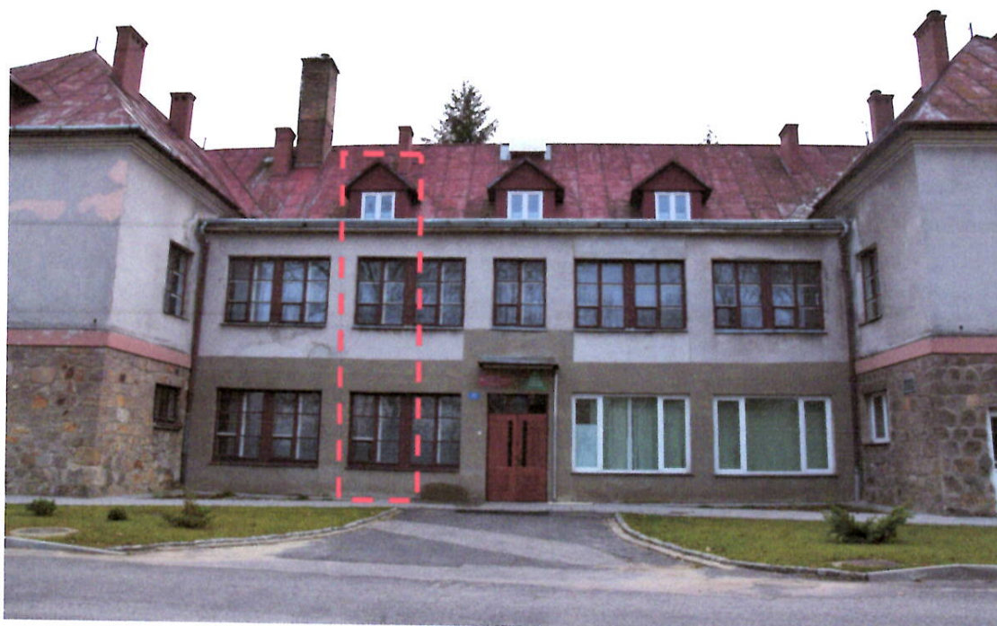
Fot. 4. Budynek j.w. , elewacja frontowa - oznaczenie lokalizacji projektowanego wewnętrznego szybu windowego.
