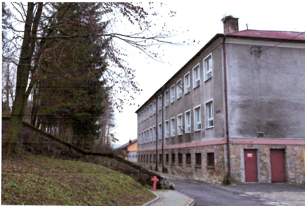
Fot. 3. Budynek j.w. - elewacja tylna od strony powiatowej drogi asfaltowej - stan istniejący.
