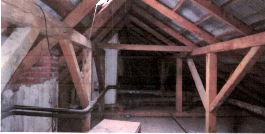
Fot.16. Poddasze nieużytkowe - drewniana płatwiowo-krokwkowa konstrukcja dachu.
