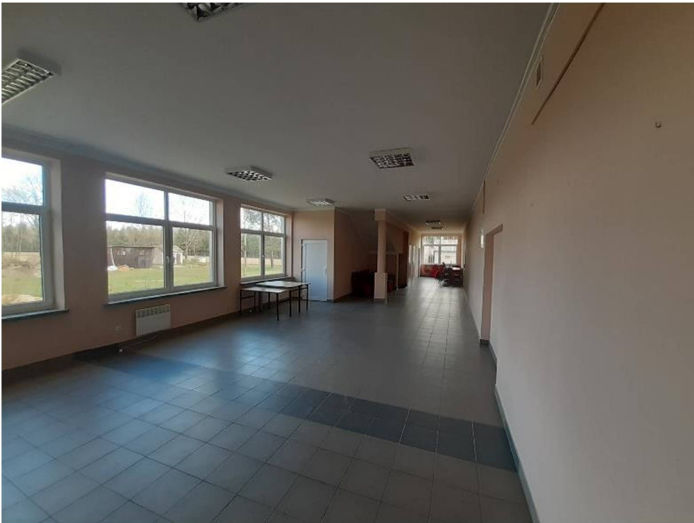
Fot. nr 15. Widok oświetlenia i grzejników elektrycznych na parterze budynku.
