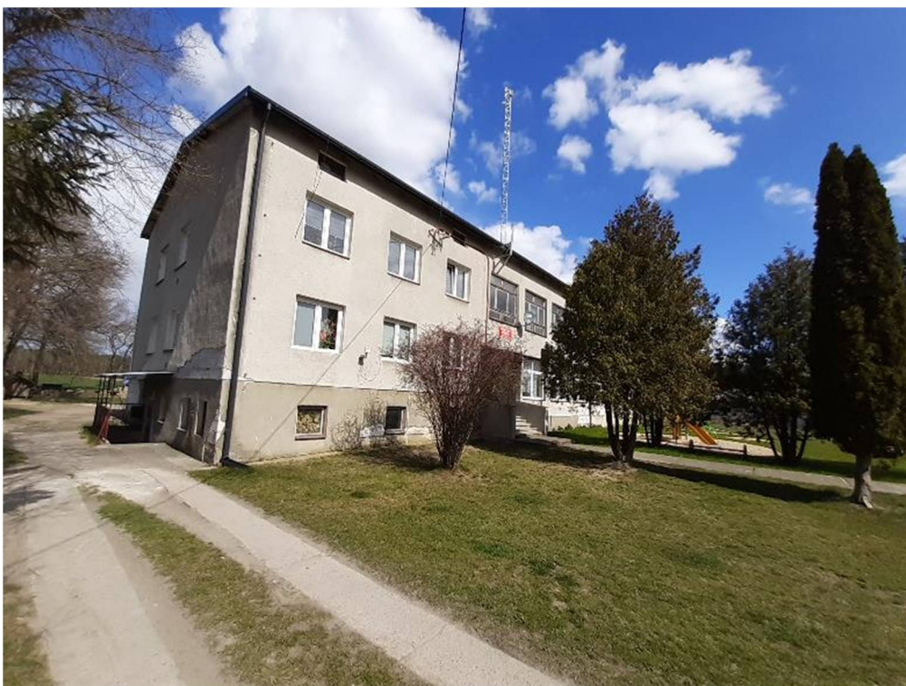
Fot. nr 2. Widok narożnika elewacji zach.-połud.
