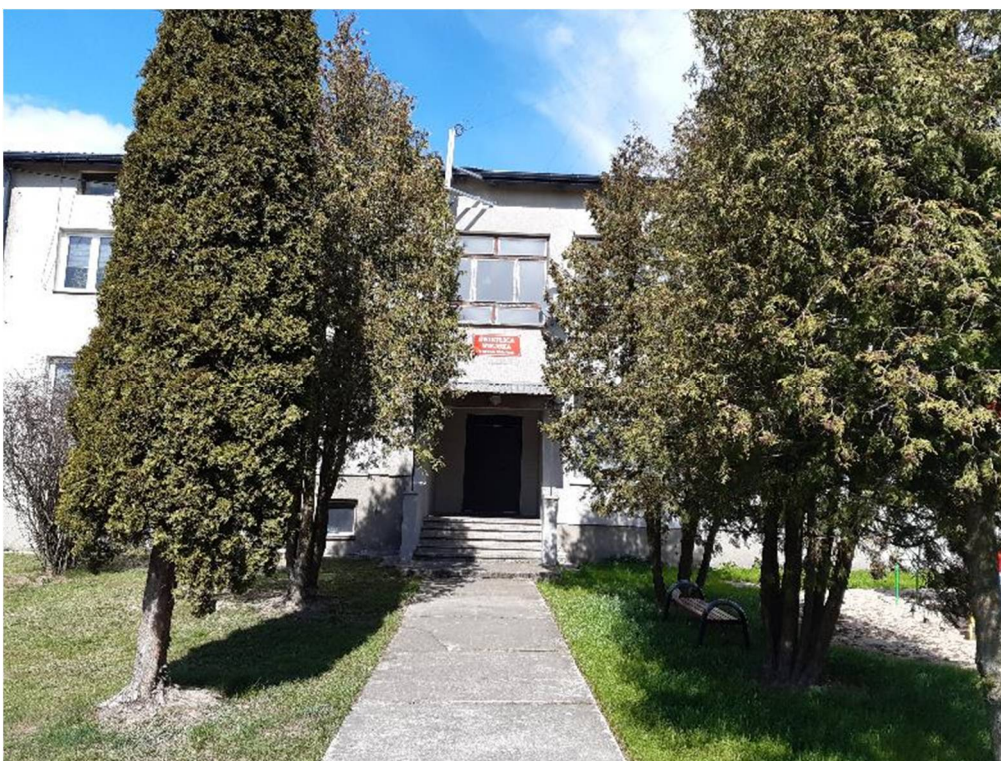
Fot. nr 3. Elewacja południowa- główne wejście do budynku.
