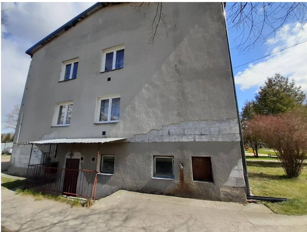
Fot. nr 9. Widok elewacji zachodniej.
