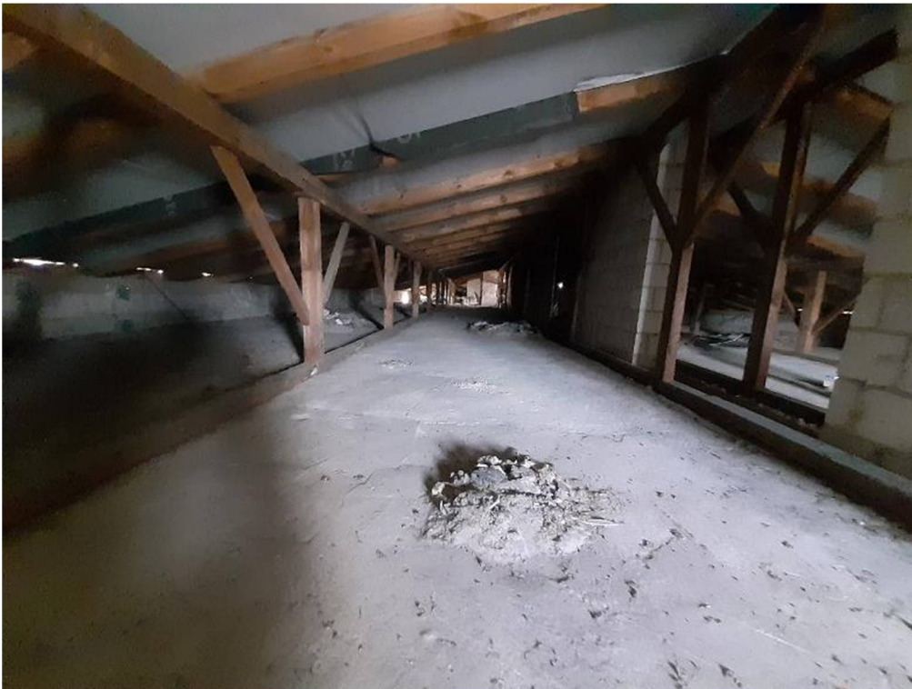
Fot. nr 11. Widok przestrzeni poddasza nieużytkowego (wieżby dachowej).
