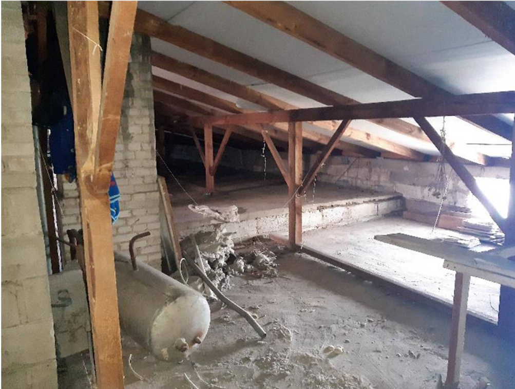
Fot. nr 10. Widok przestrzeni poddasza nieużytkowego (wieżby dachowej).
