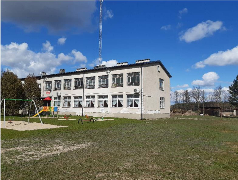
Fot. nr 4. Widok elewacji połd.- wsch.
