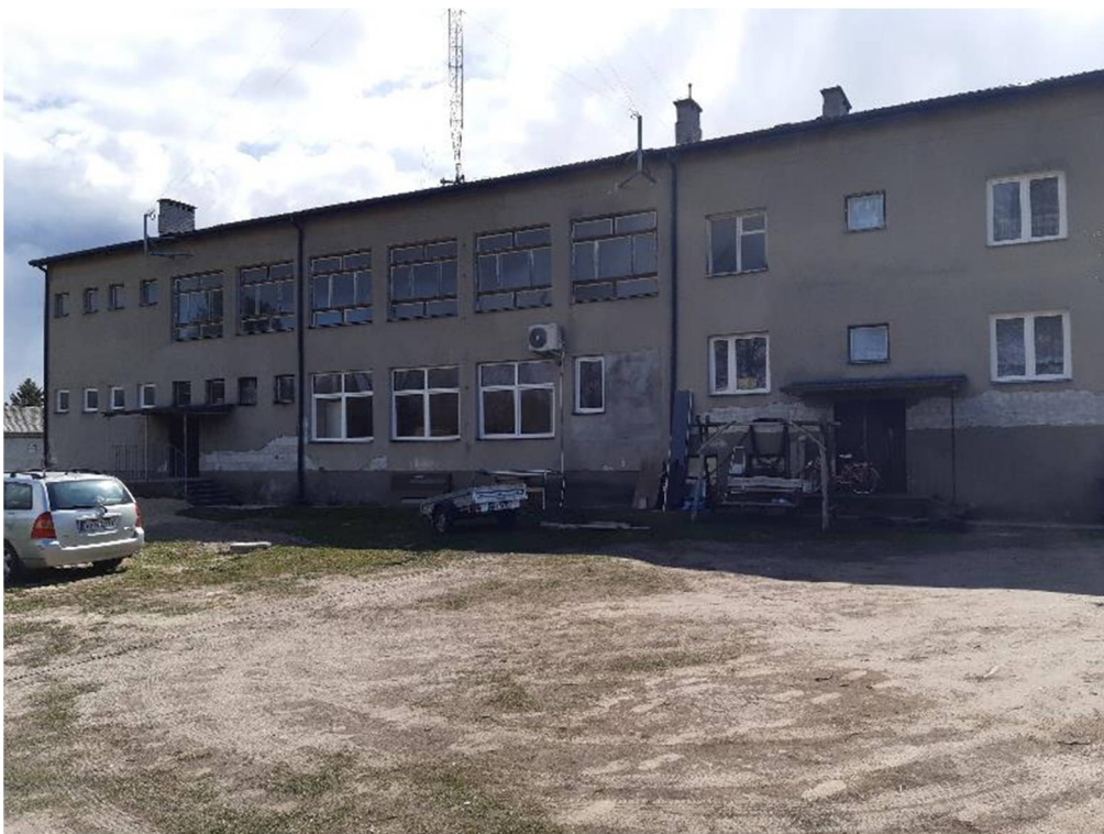
Fot. nr 7. Widok elewacji północnej.
