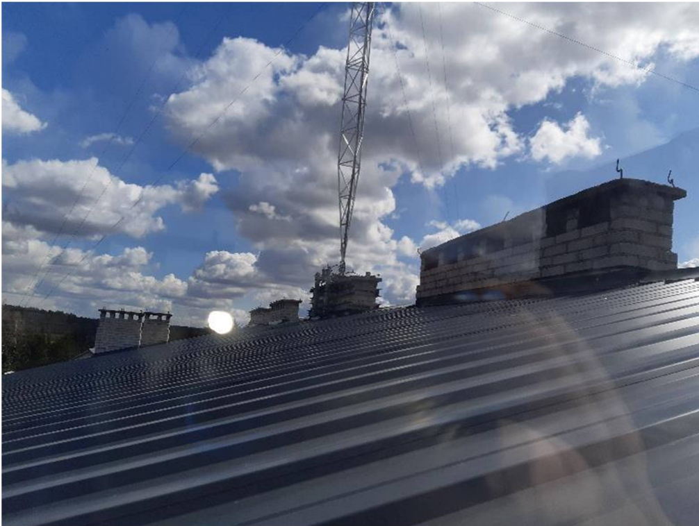
Fot. nr 13. Widok pokrycia dachu oraz kominów.
