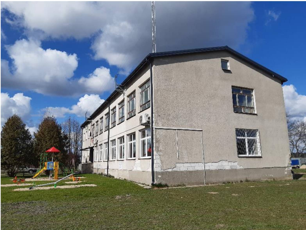
Fot. nr 5. Widok elewacji połd.- wsch.
