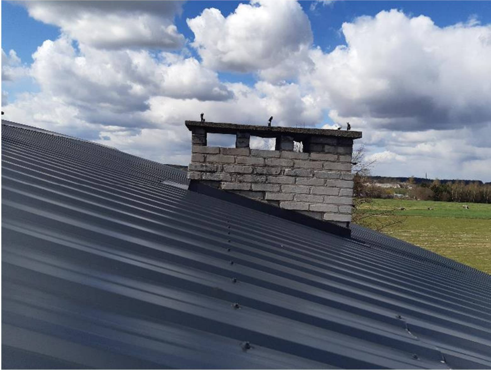
Fot. nr 12. Widok pokrycia dachu oraz komina.
