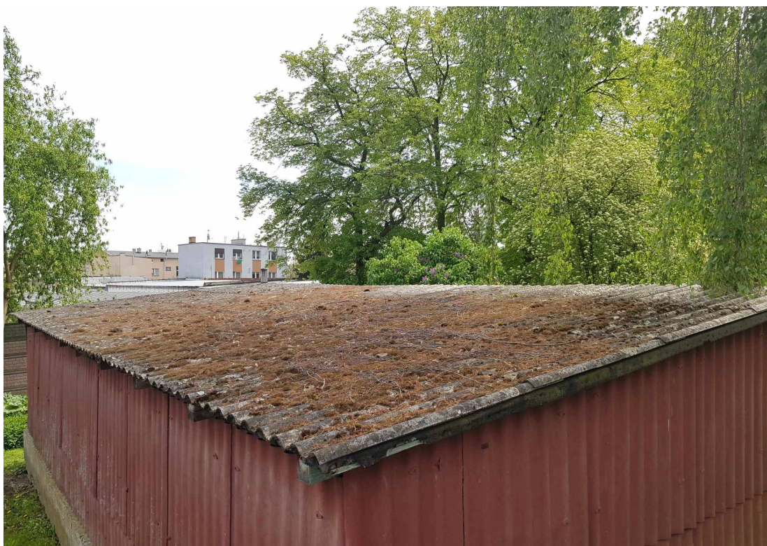
Fot. 6 Pokrycie dachowe z płyt azbestowo-cementowych
