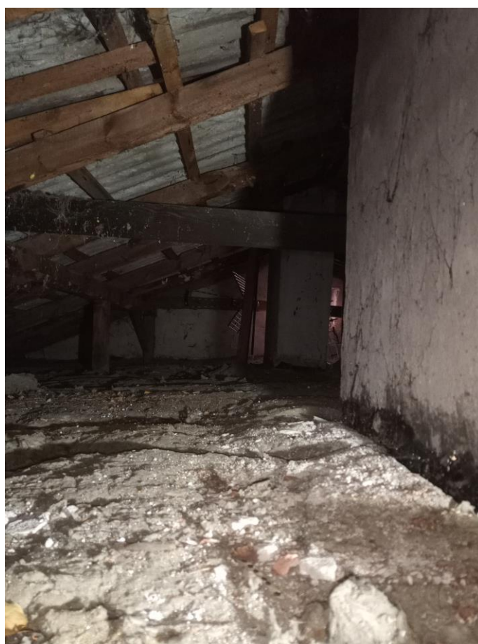
Fot. 3 Stan istniejący stropu drugiej kondygnacji
