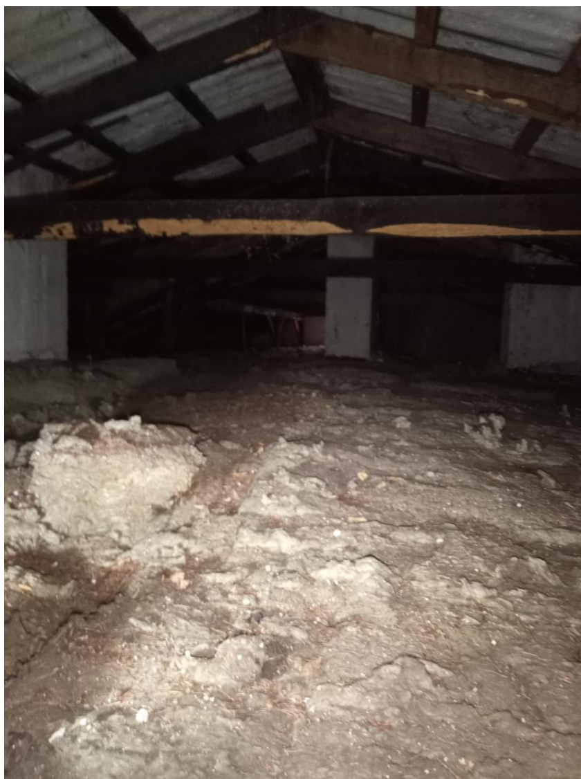
Fot. 1 Stan istniejący stropu drugiej kondygnacji
