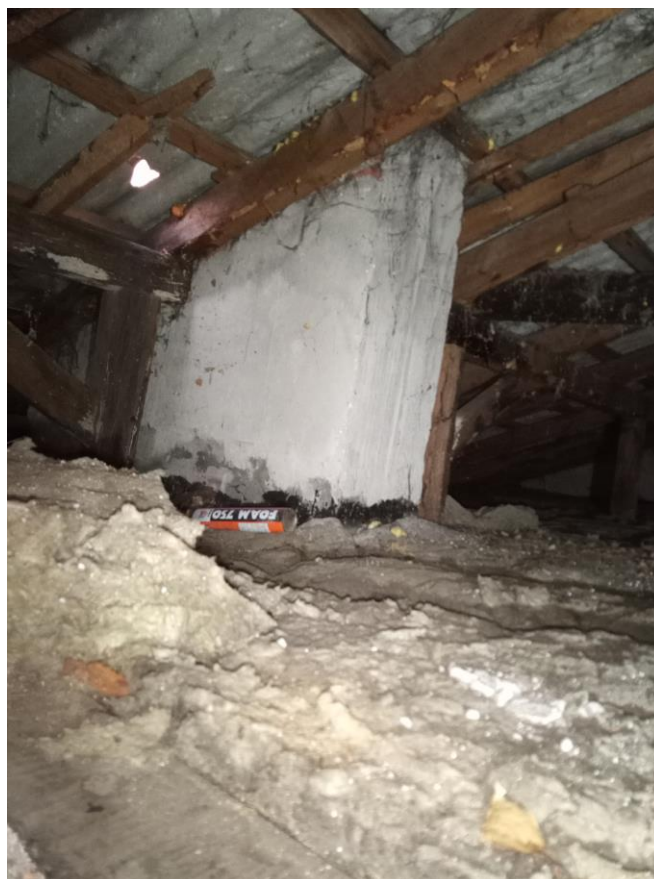
Fot. 2 Stan istniejący stropu drugiej kondygnacji
