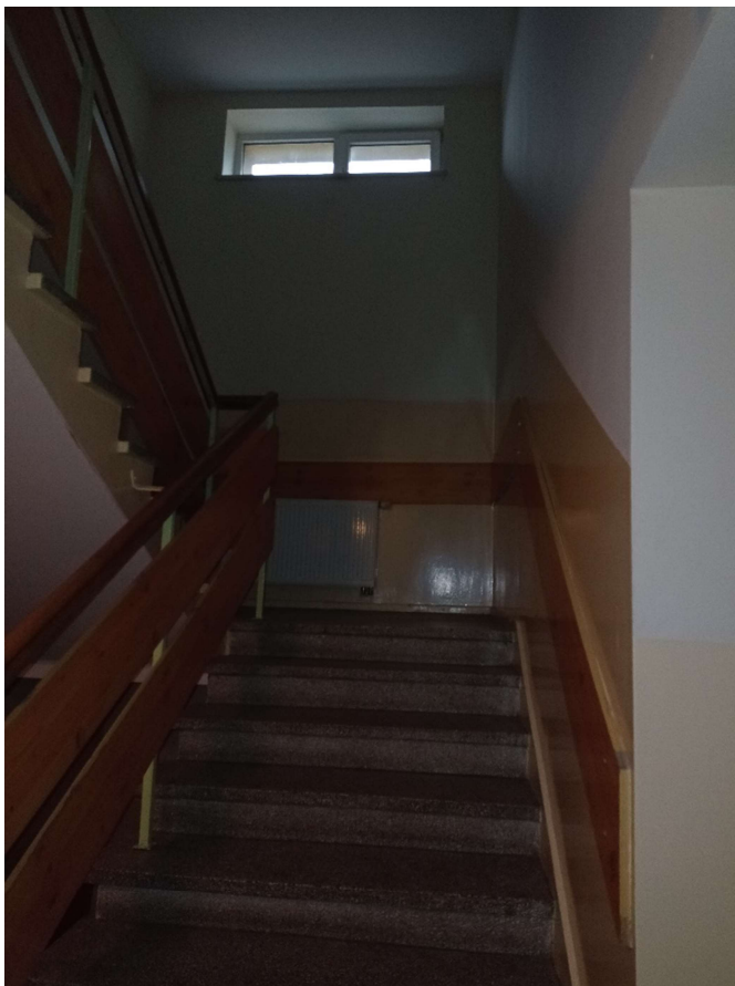
Fot.40 Widok klatki schodowej z I piętra na poddasze.
