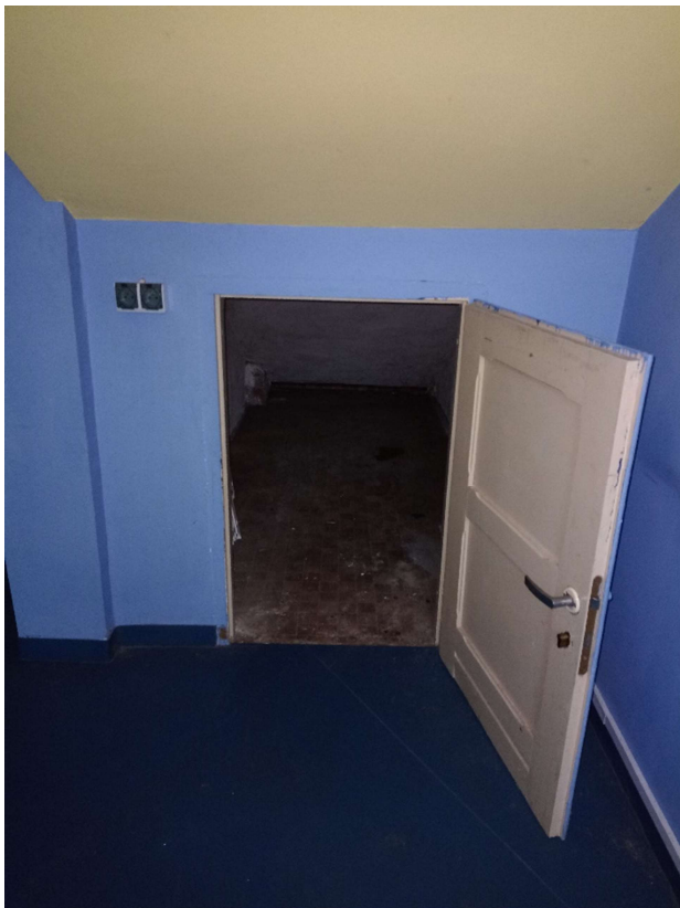
Fot.25 Widok schowka pod schodami w łączniku – parter.
