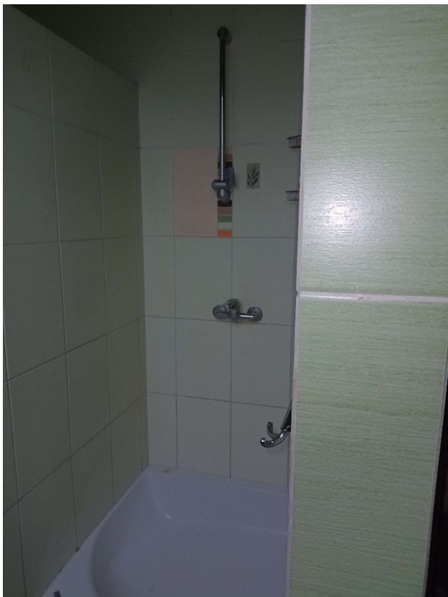
Fot.65 Widok łazienki - poddasze.
