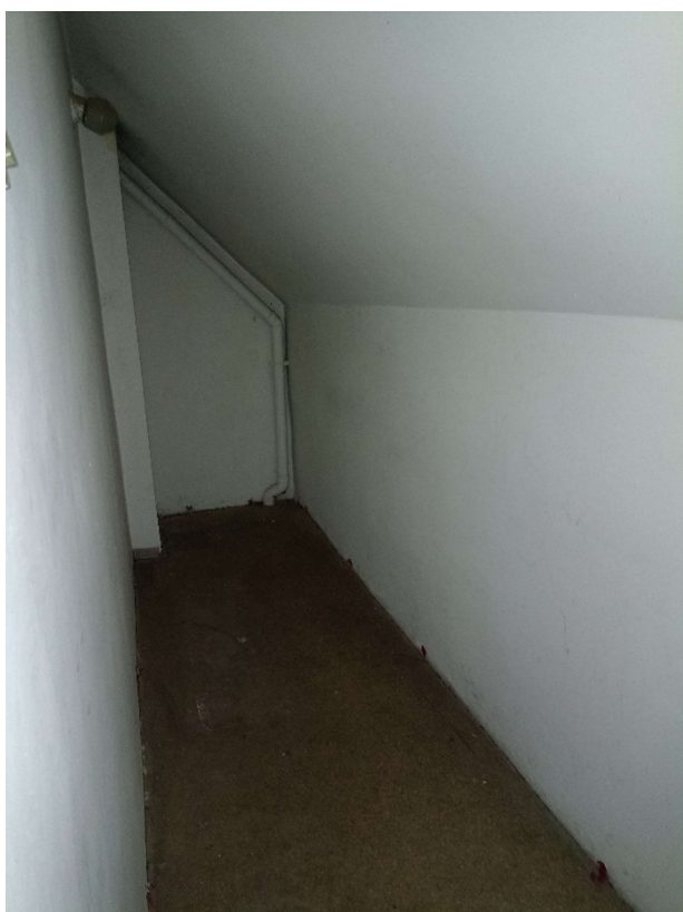
Fot.68 Widok pomieszczenia pomocniczego – poddasze.
