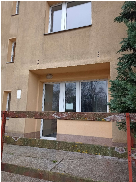
Fot.80 Widok tarasu.
