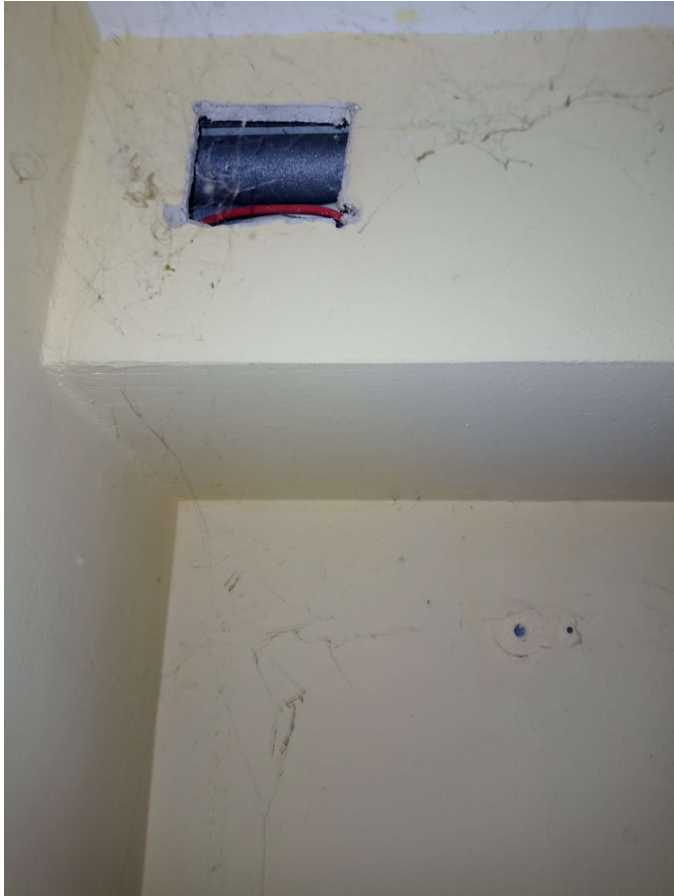
Fot.14 Widok ściany z otwartą rewizją w pokoju – parter.
