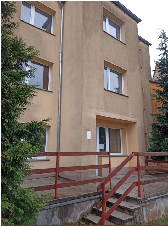
Fot.79 Widok elewacji od strony boiska.
