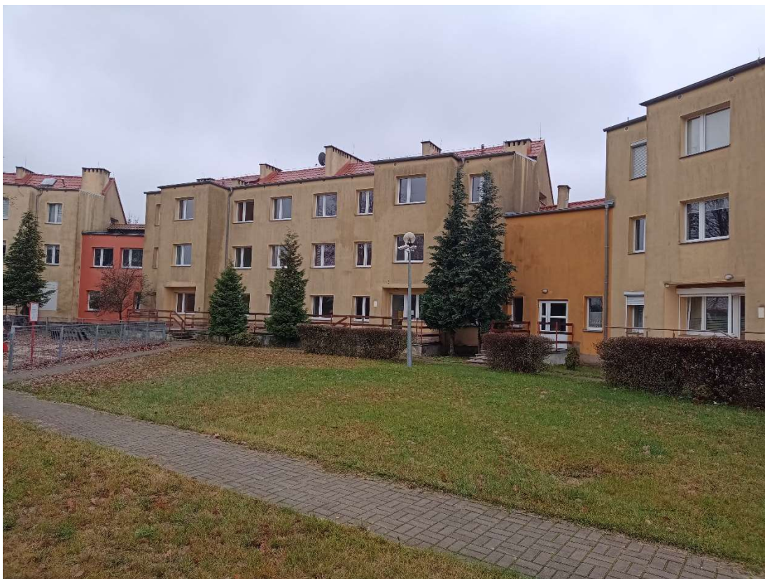
Fot.84 Widok elewacji od strony boiska.
