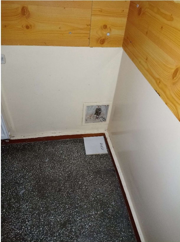
Fot.58 Widok ściany klatki schodowej z rewizją.
