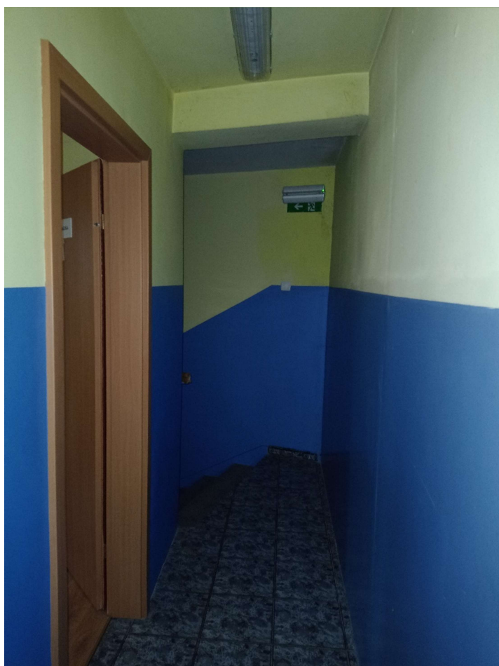
Fot.33 Widok korytarza w łączniku – I piętro.
