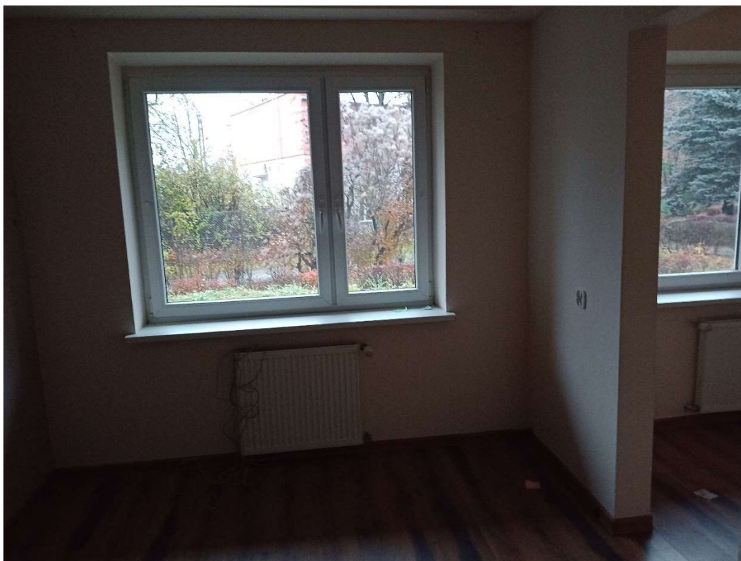
Fot.8 Widok ściany z oknem w pokoju – parter.
