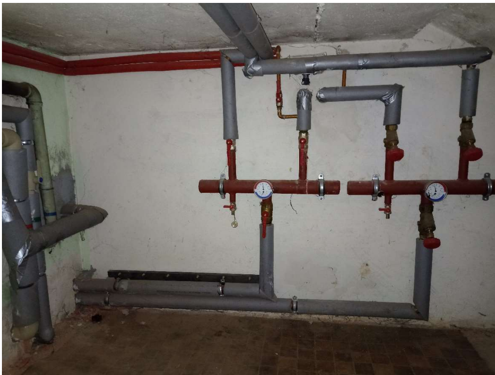
Fot. 21 Widok pomieszczenia z instalacjami sanitarnymi.
