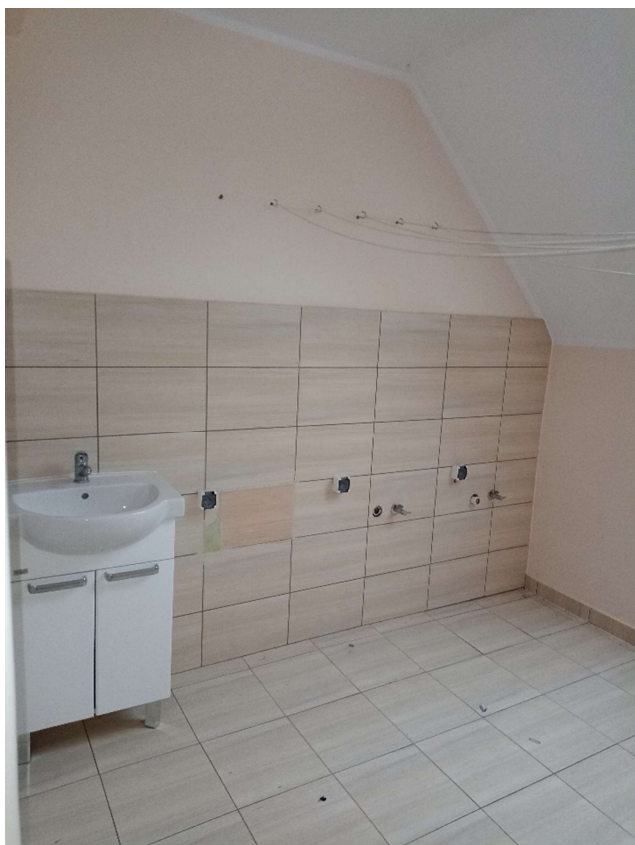
Fot.45 Widok pomieszczenia z umywalką – I piętro.
