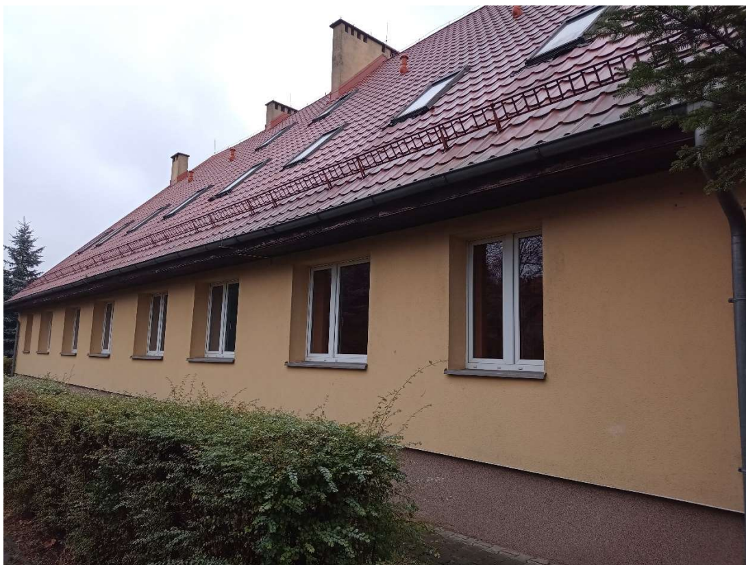
Fot.87 Widok elewacji od strony wjazdu.
