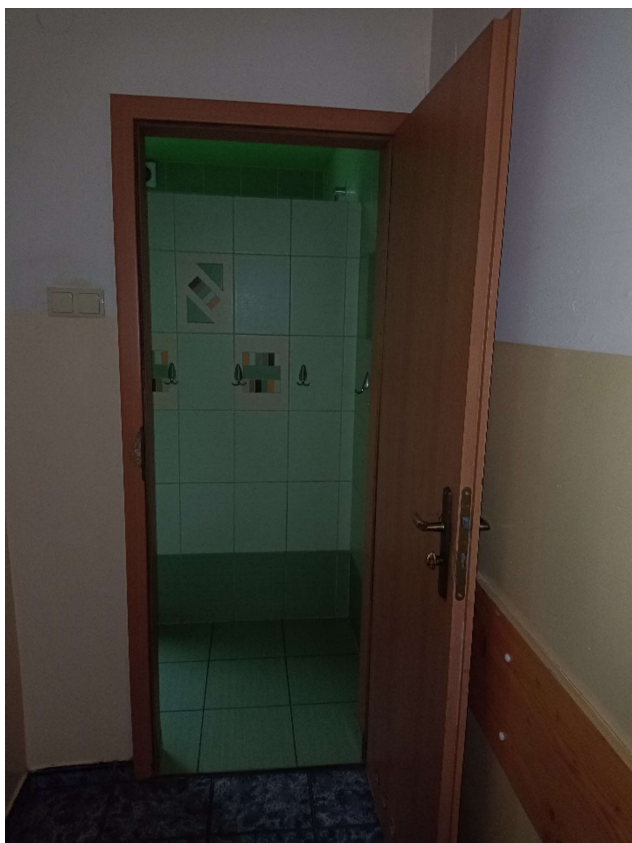
Fot.66 Widok drzwi wejściowych do łazienki – poddasze.
