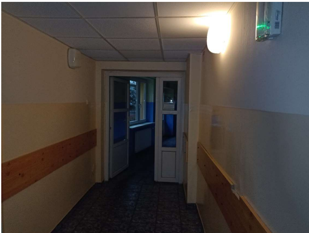
Fot.17 Widok korytarza z drzwiami do łącznika – parter.
