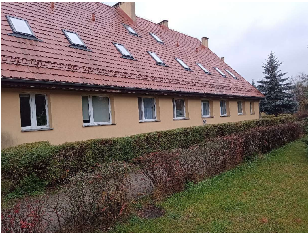
Fot.85 Widok elewacji od strony wjazdu.
