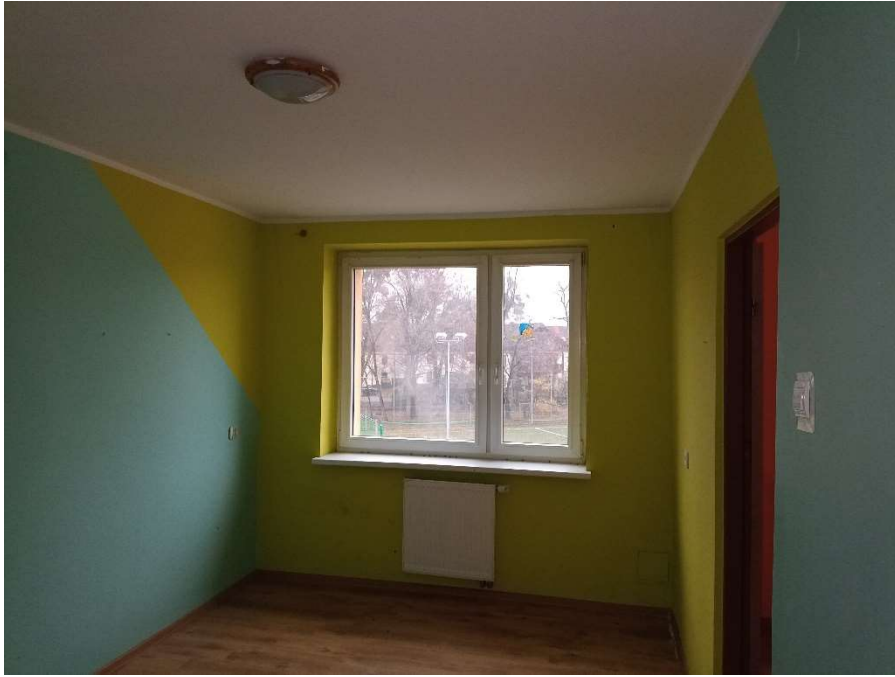
Fot.62 Widok ściany z oknem w pokoju – poddasze.
