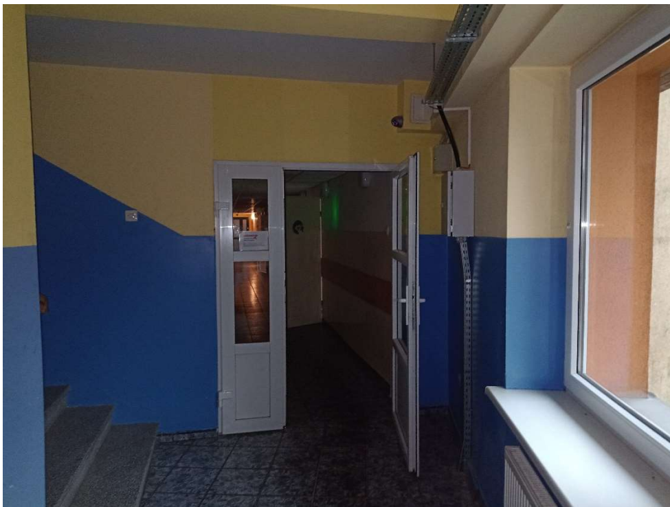
Fot.27 Widok korytarza w łączniku z drzwiami wejściowymi do segmentu B – parter.
