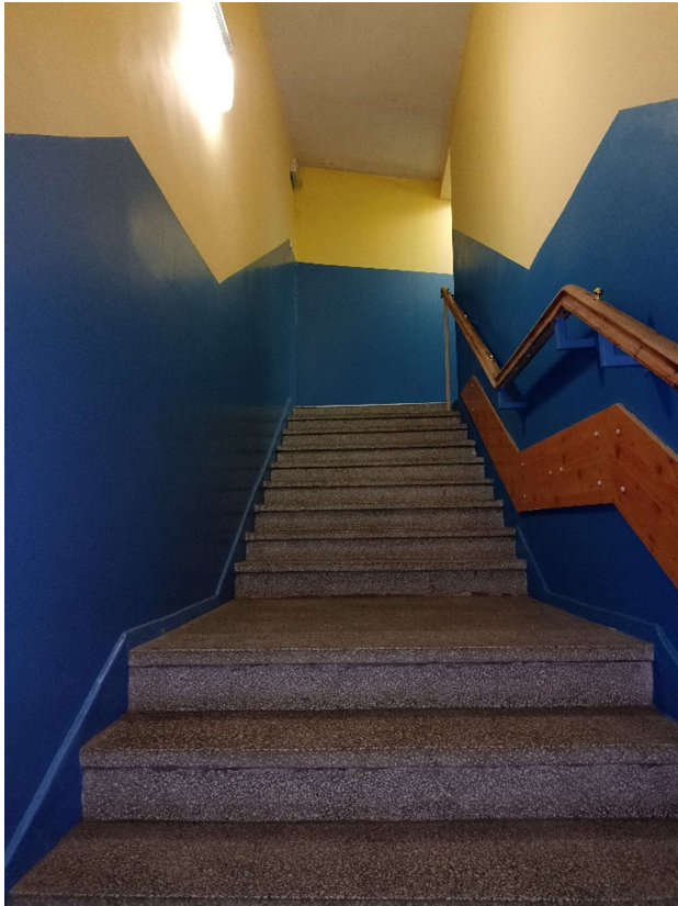
Fot.30 Widok klatki schodowej w łączniku – parter.
