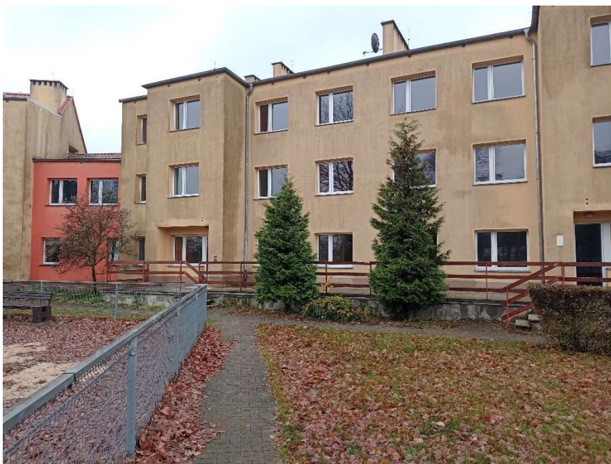
Fot.82 Widok elewacji od strony boiska.
