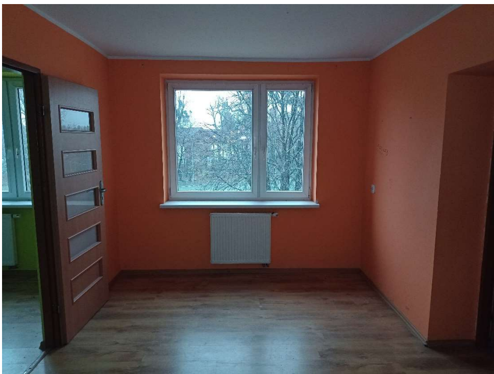
Fot.61 Widok ściany z oknem w pokoju – poddasze.
