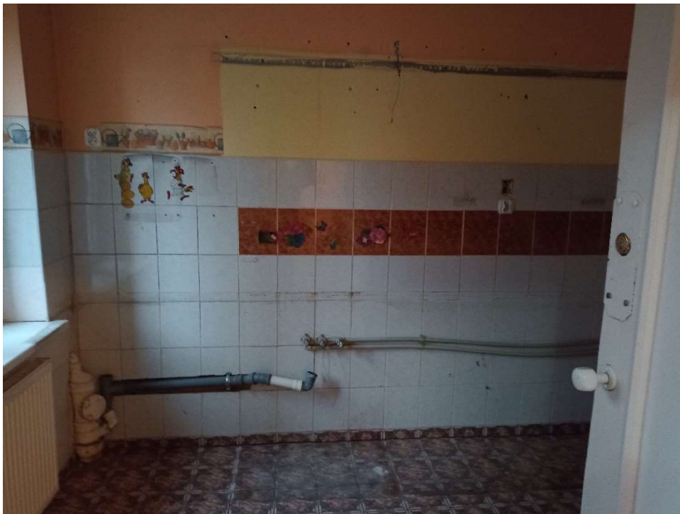
Fot.3 Widok ścian z instalacjami, kuchnia, parter.
