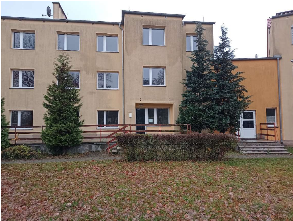
Fot.83 Widok elewacji od strony boiska.
