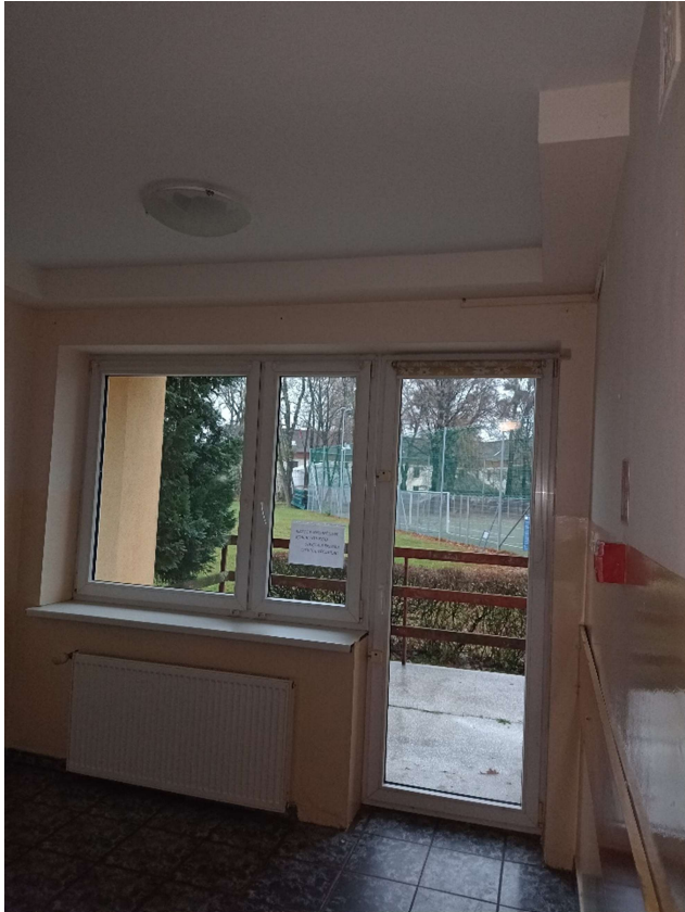
Fot.16 Widok ściany z oknem balkonowym – wyjściem na taras – parter.
