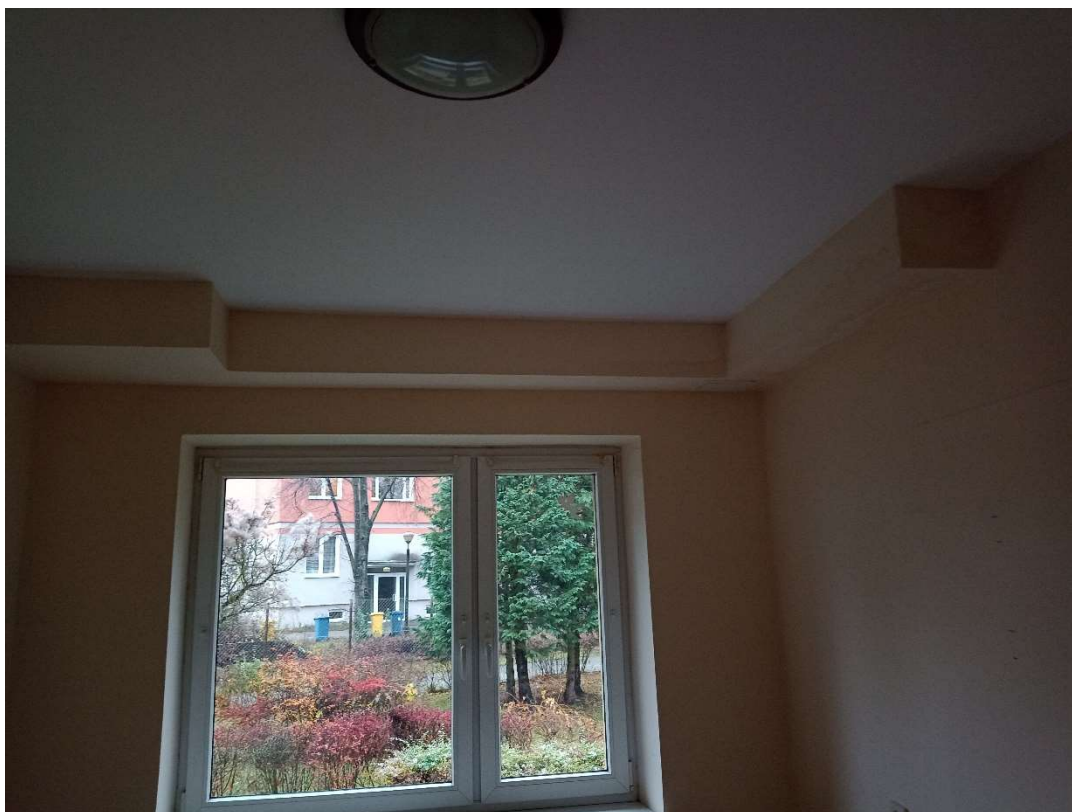
Fot.10 Widok ściany z oknem w pokoju – parter.
