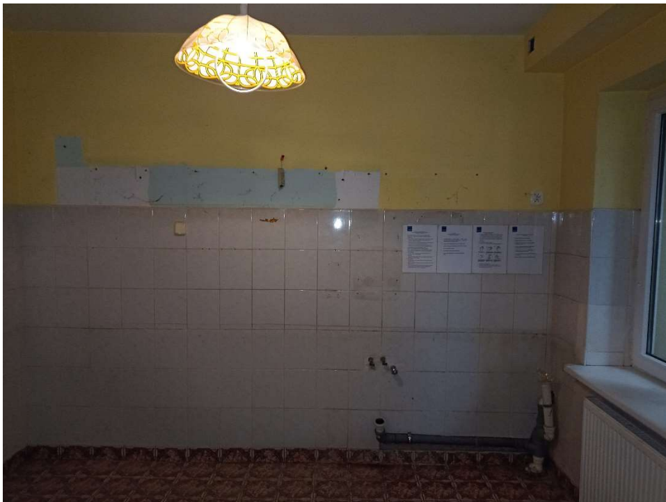
Fot.15 Widok ściany w kuchni z instalacjami – parter.
