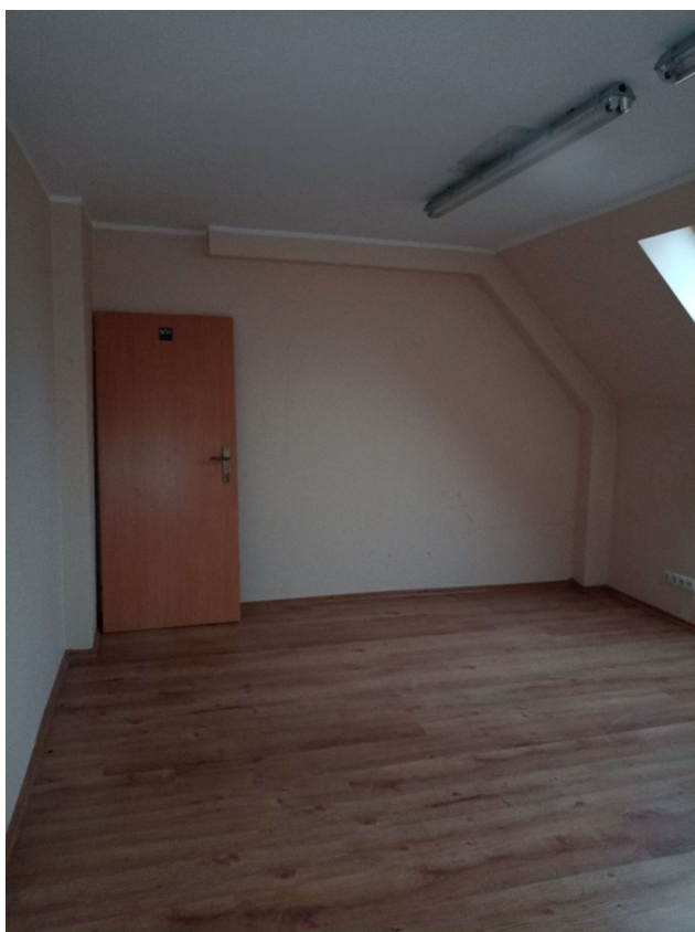
Fot.55 Widok pomieszczenia – poddasze.
