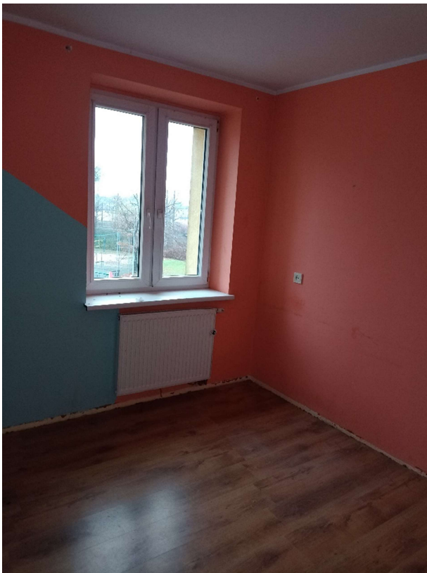
Fot.59 Widok ściany z oknem w pokoju – poddasze.
