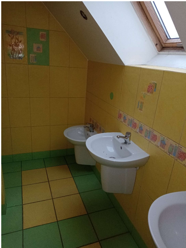
Fot.72 Widok łazienki – poddasze.
