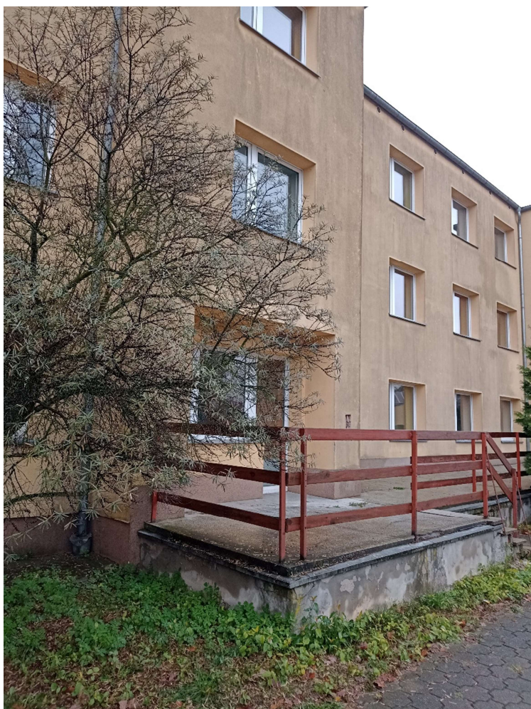
Fot.78 Widok elewacji od strony boiska.
