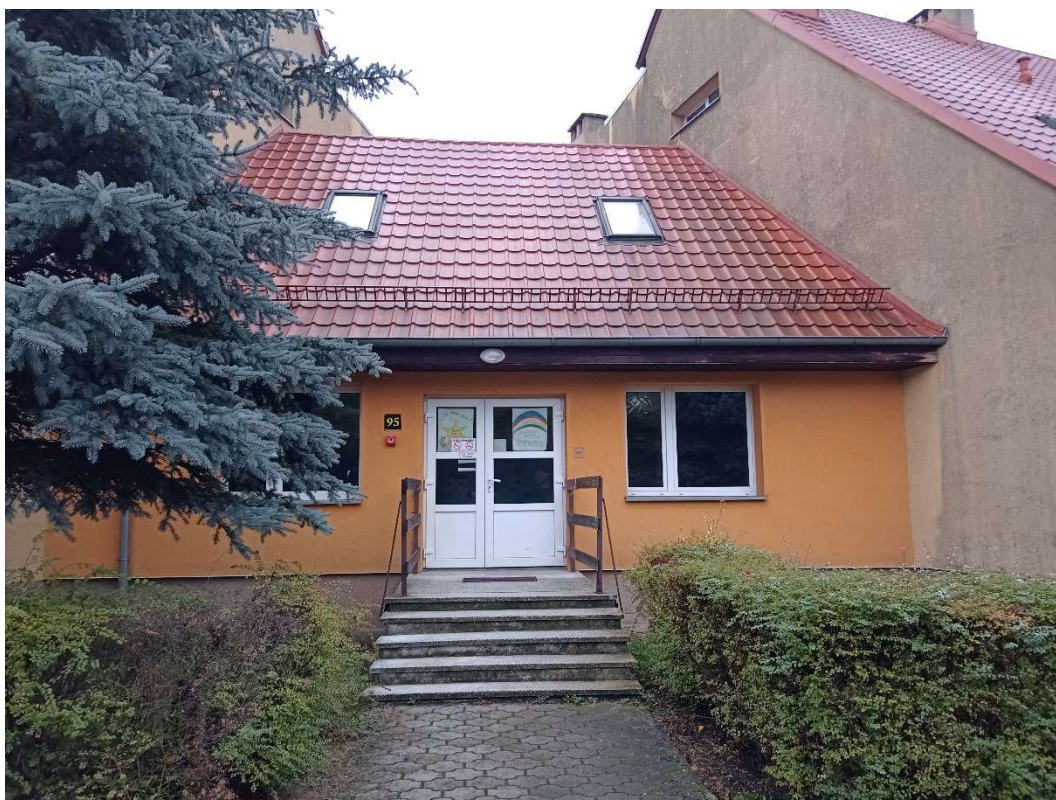
Fot.86 Widok drzwi wejściowych z łącznikiem.
