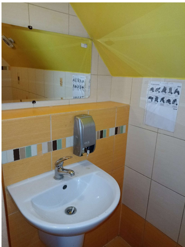
Fot.67 Widok pomieszczenia WC – poddasze.
