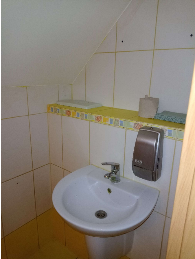
Fot.75 Widok pomieszczenia WC – poddasze.
