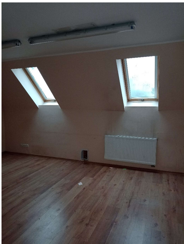
Fot.54 Widok pomieszczenia z oknami dachowymi – poddasze.
