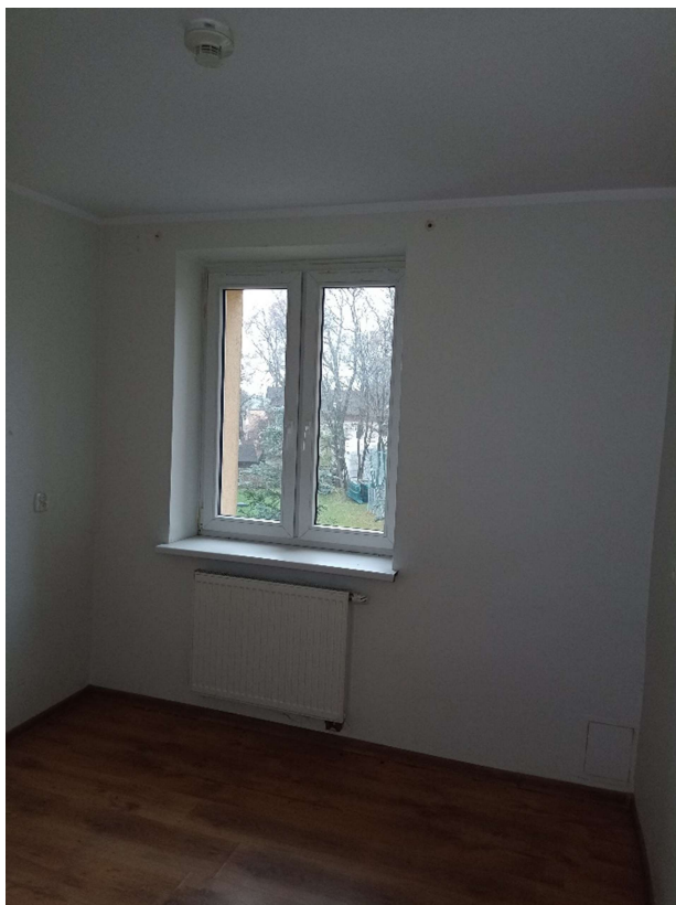
Fot.70 Widok ściany z oknem w pokoju – poddasze.
