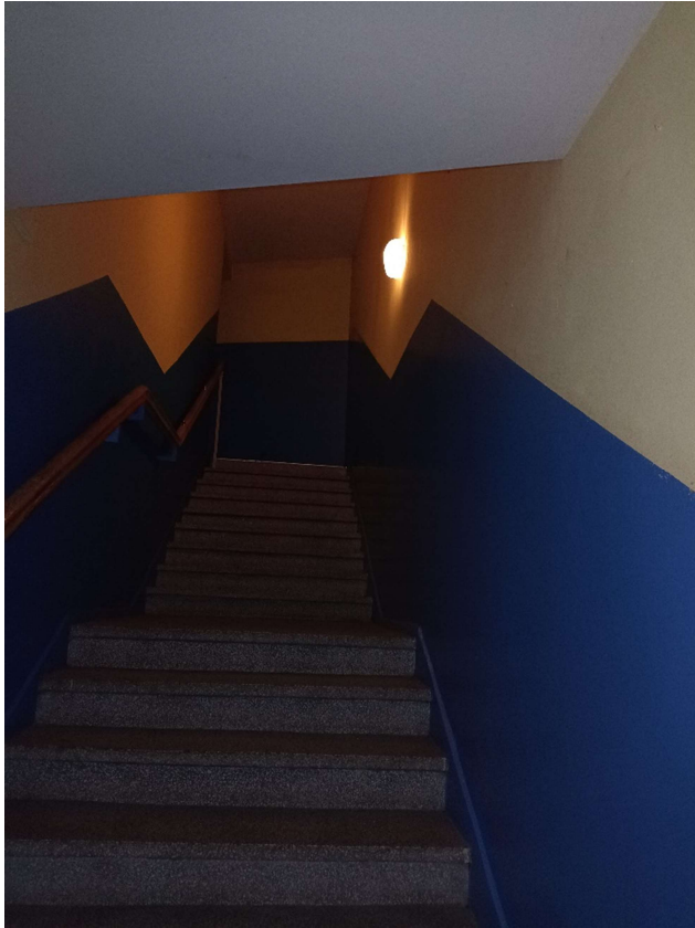
Fot.34 Widok klatki schodowej w łączniku.
