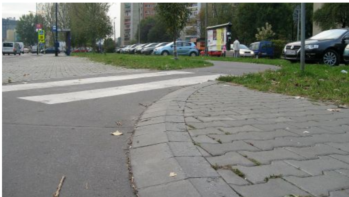
Fot. 5. Prawidłowe oddzielenie drogi dla rowerów od przylegającego chodnika położonym na płasko krawężnikiem drogowym, tworzącym skos ok. 15-30 stopni przy obniżeniu niwelety drogi dla rowerów wobec chodnika o 3-5 cm. Ul. Marii Dąbrowskiej, Kraków.
