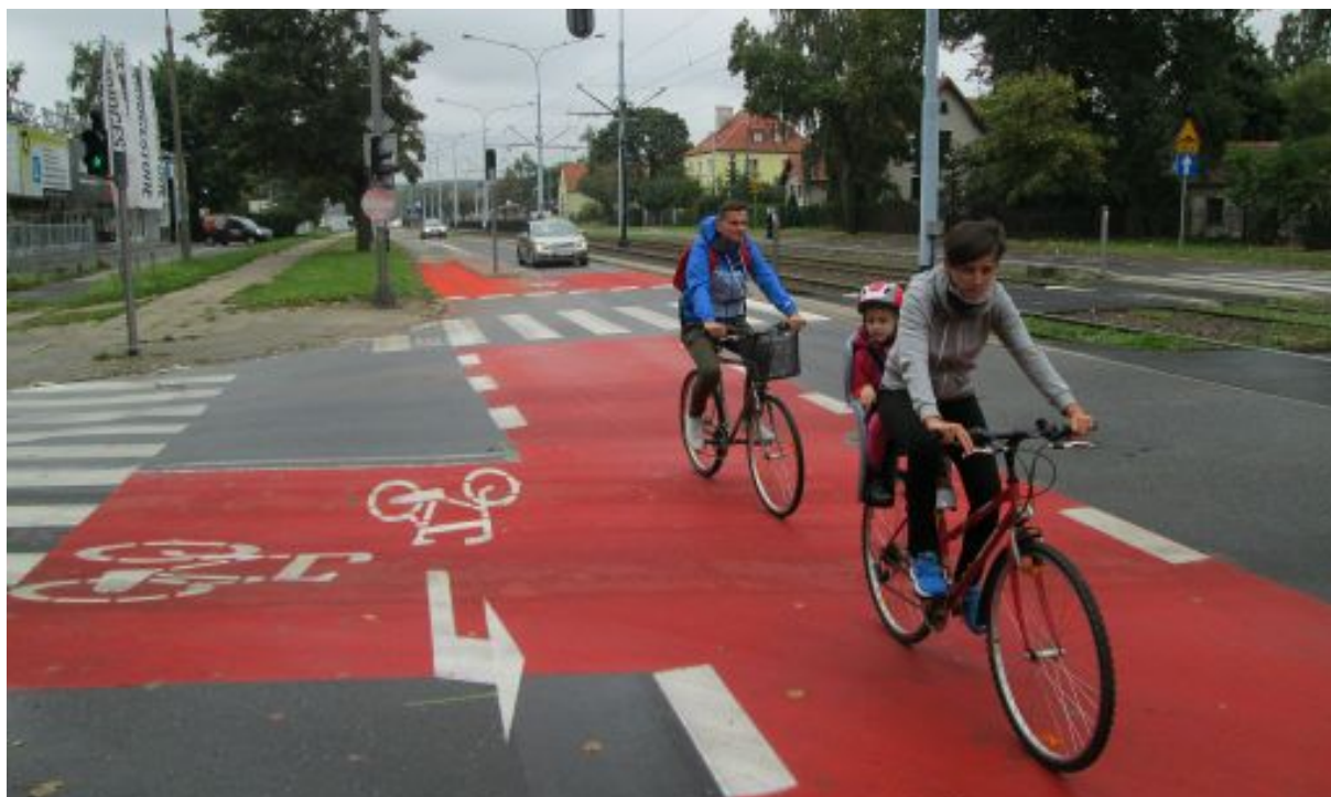
Fot. 9. Śluza typu 2, Gdańsk, ul. Wojska Polskiego. W głębi widoczna na wlocie śluza klasyczna, typu 1. Uwaga: zdjęcie przedstawia rozwiązanie eksperymentalne (rok 2013). W niniejszych standardach proponuje się nieco inne oznakowanie poziome śluzy typu 2, zgodne z przepisami po nowelizacji z 2015 roku (D.U.2015.1314).
