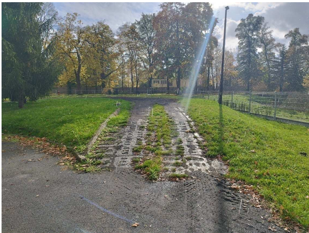
Rozbiórka istniejącego wzniesienia
