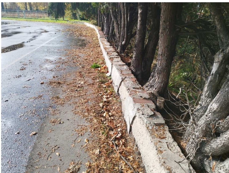
Rozróbka muru betonowego na krawędzi placu manewrowego
