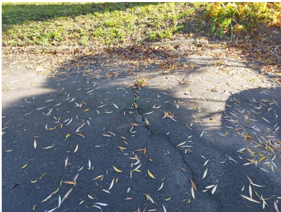
Naprawa pęknięć poprzecznych np. przy użyciu żywic bitumicznych (usunięcie roślinności, oczyszczenie pęknięcia, aplikacja wypełnienia)
