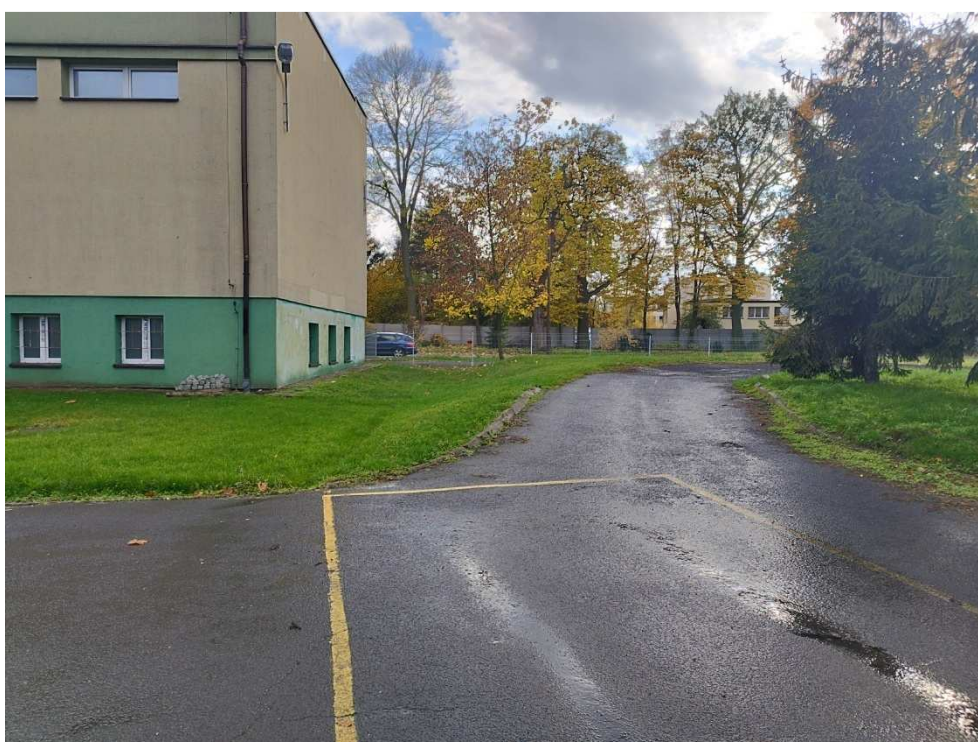
Rozbiórka istniejącego wzniesienia
