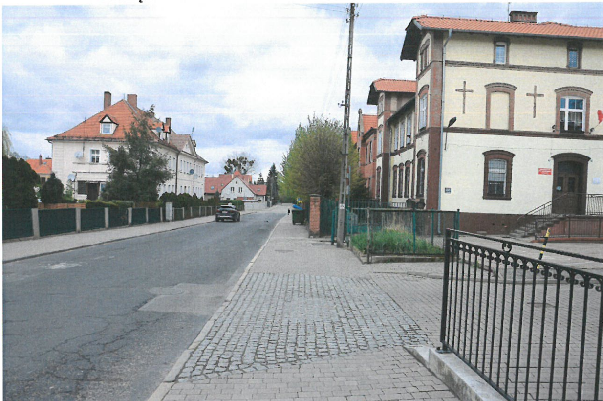
Fot. 1. Widok na wjazd na dz. Nr 27/13 z ul. Kilińskiego. Wjazd umożliwiający bezpośredni dojazd do nieogrodzonej, południowej części działki
