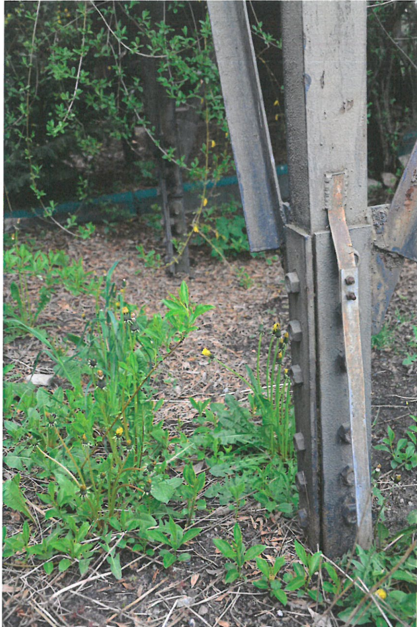
Fot. 7. Połączenie segment nr 1 z fundamentem blokowym
