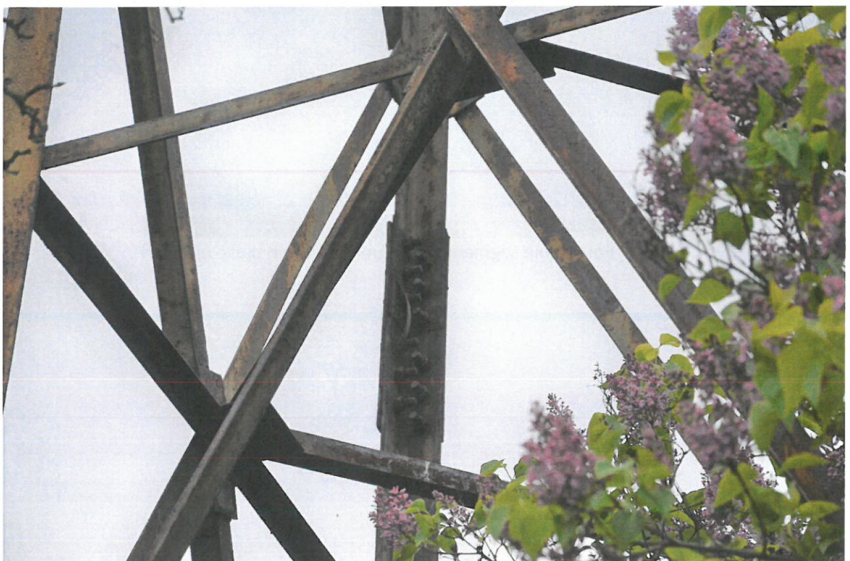
Fot. 9. Połączenie zakładkowe segmentu 1. z segmentem 2.
