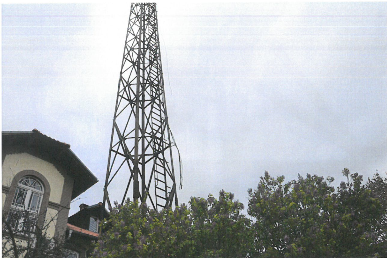
Fot. 10. Przepony stabilizujące poszczególne segmenty
