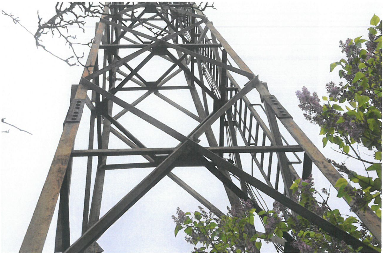
Fot. 8. Połączenie zakładkowe segmentu 1. z segmentem 2.
