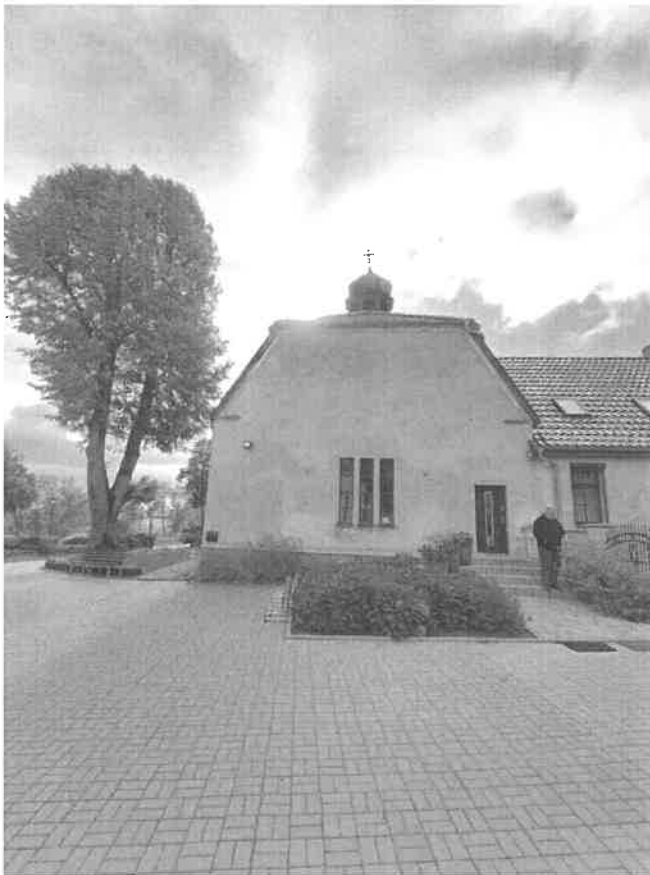
fot. nr 3 – elewacja tylna północna
