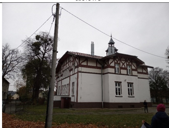
Fot. 18 – Pokrycie dachu z blachodachówki i kominy z blachy, w tle wieża na dachu
