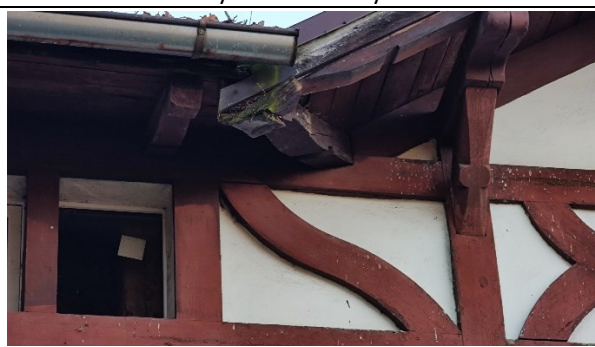
Fot. 16 – Wnętrze wnek okiennych poddasza i deski czołowe
