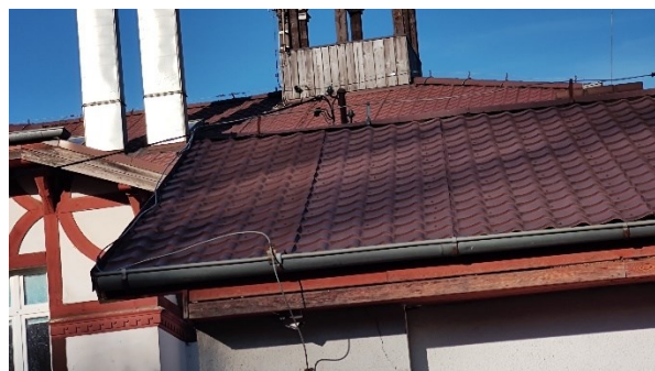
Fot. 17 – Pokrycie dachu z blachodachówki i kominy z blachy
