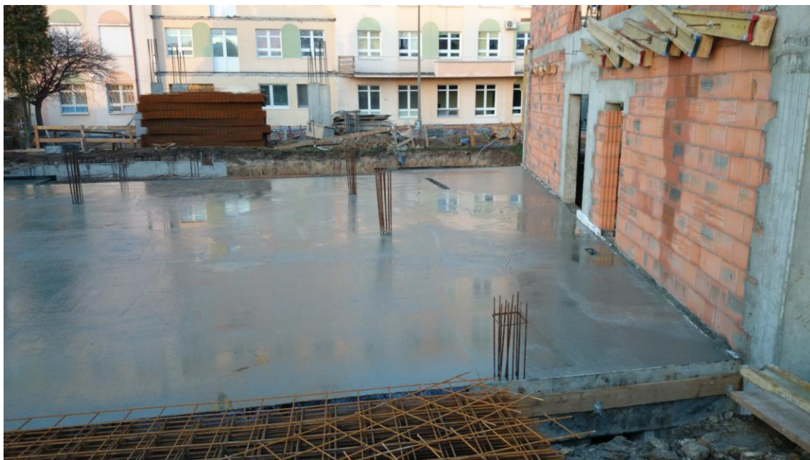
FOT. 9 Strop nad piwnicą
