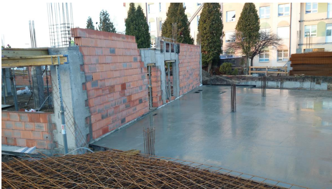
FOT. 10 Strop nad piwnicą oraz zbrojenie skrajnych słupów
