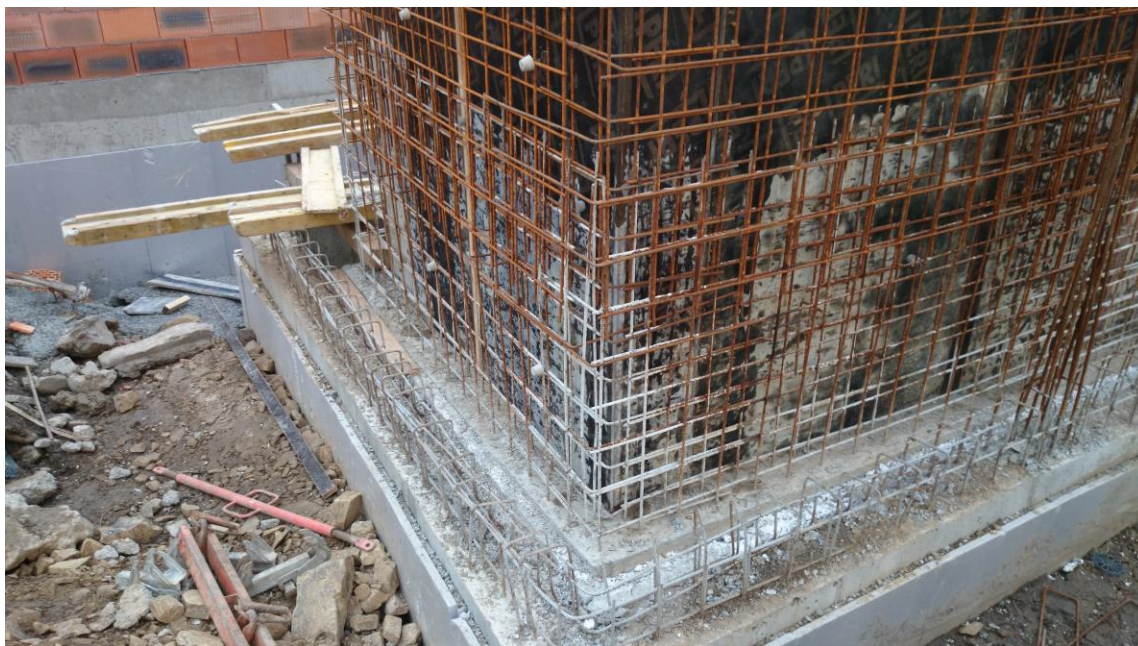
FOT. 13 Zbrojenie szybu windowego
