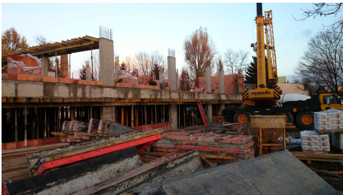
FOT. 8 Szalowanie konstrukcji ramy żelbetowej
