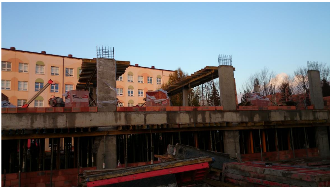
FOT. 5 Słupy piętra z widocznym zbrojeniem
