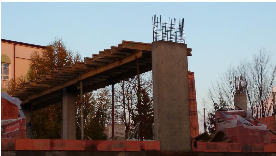
FOT. 6 Szczegół ułożenia prętów zbrojeniowych
