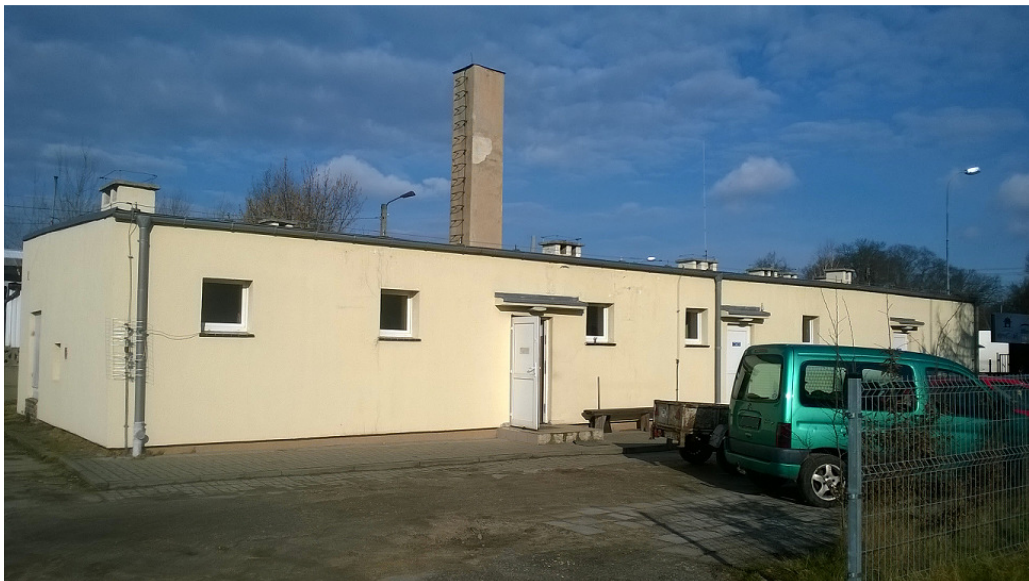
Rys. 3. Widok elewacji frontowej budynku pomocniczego z kotłownią olejową
